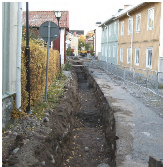
Figur 16. Översiktsbild som visar schaktet i Lilla gatan. Fotograferat från söder av Jonas Ros.
