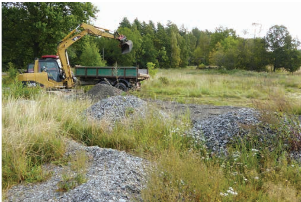
Figur 5. Fyra av de grushögar som skulle flyttas från boplats Lista 111. På bilden ser man också ett 0,3 meter tjockt lager grus från de högar som redan fraktats bort. Fotograferat från väster av Maud Emanuelsson.
