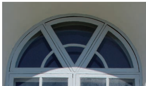
Figur 15. Västra fönstret i långhusets södra fasad, innan åtgärd. Bl.a. syns färgbortfall på vänstra delen av bågen. Foto: Tobias Mårud
