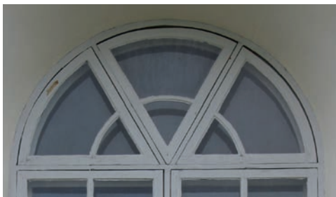
Figur 15. Västra fönstret i långhusets södra fasad, innan åtgärd. Bl.a. syns färgbortfall på vänstra delen av bågen. Foto: Tobias Mårud
