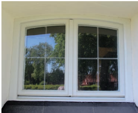
Figur 25 (Övan). Östra fasaden, sakristians tillbyggnad (arkivrummet). Foto: Tobias Mårud.
