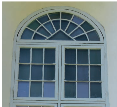
Figur 18. Korffönstret, efter åtgärd. Bl.a. anlägsnades smuts på båge och karm. Foto: Tobias Mårud
