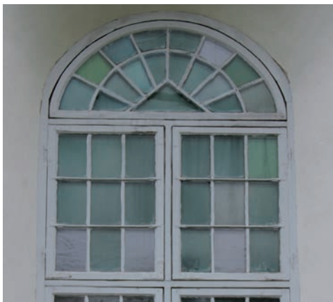
Figur 17. Korffönstret, innan åtgärd. Foto: Tobias Mårud
