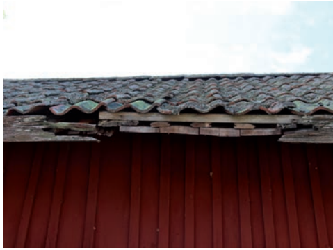
Figur 13. Läckage i taktäckning har lett till rötskador i östra takfallets takfot. Foto: Tobias Mårud.
