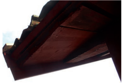
Figur 21. Rötskadade bräder i östra takfallets takfot har ersatts. Foto: Tobias Mårud. Figur 22. Även rötskadade bräder intill vindskivorna har ersatts. Foto: Tobias Mårud.
