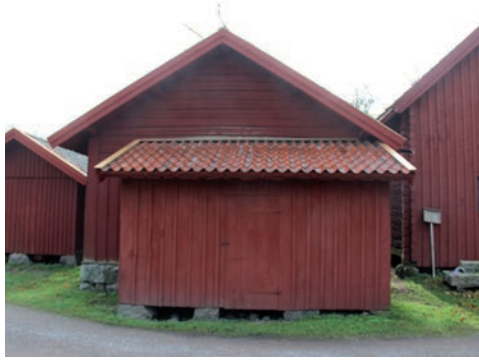
Figur 33. Vedbodens norra gavel, efter åtgärd. Foto: Tobias Mårud.
