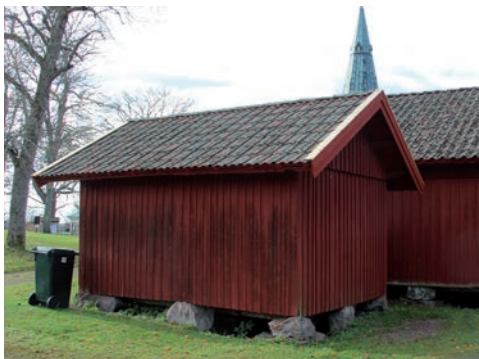
Figur 19. Östra takfallet efter åtgärd. Täckebrädorna är planerade att strykas nästa säsong. Foto: Tobias Mårud.
