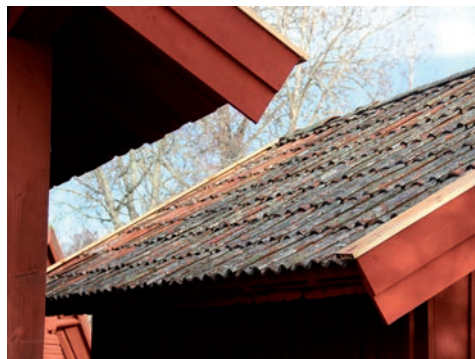
Figur 19. Östra takfallet efter åtgärd. Täckebrädorna är planerade att strykas nästa säsong. Foto: Tobias Mårud.
