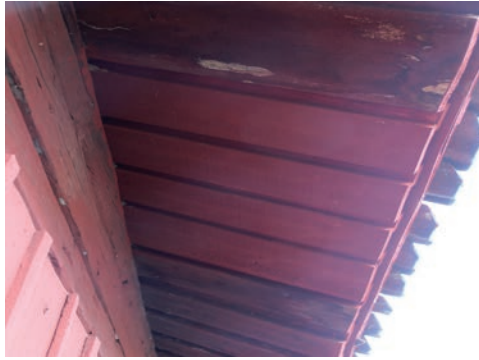
Figur 21. Rötskadade bräder i östra takfallets takfot har ersatts. Foto: Tobias Mårud. Figur 22. Även rötskadade bräder intill vindskivorna har ersatts. Foto: Tobias Mårud.
