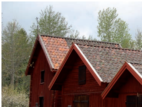
Figur 37. De kompletterade takpannorna lagda på södra delen av takfallet. Foto: Tobias Mårud.
