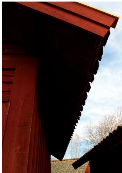
Figur 29 (Ovan). Östra takfoten innan åtgärd, med takpannor ur läge och virkesskador. Foto: Tobias Mårud.
