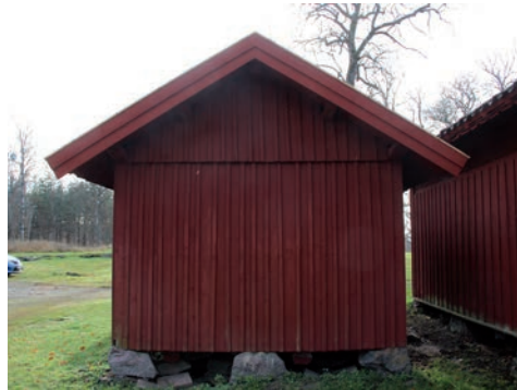
Figur 16. Vilket leder till vatteninträngning och rötskador. Här i västra takfallets nordvästra hörn. Foto: Tobias Mårud.
