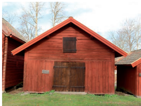
Figur 31 (Vänster). Rötskadorna i västra takfoten har åtgärdats. Foto: Tobias Mårud.
