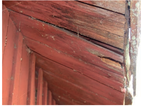
Figur 13. Läckage i taktäckning har lett till rötskador i östra takfallets takfot. Foto: Tobias Mårud.
