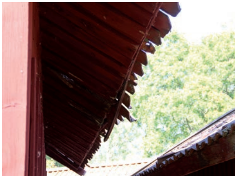
Figur 29 (Ovan). Östra takfoten innan åtgärd, med takpannor ur läge och virkesskador. Foto: Tobias Mårud.
