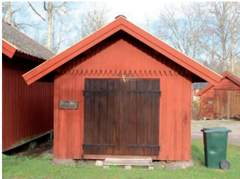
Figur 17. Sprutbodens södra gavel, efter åtgärd. Foto: Tobias Mårud.
