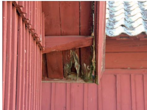
Figur 15. Vindskivornas täckebrädor är underdimensionerade och skeva. Foto: Tobias Mårud.
