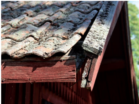
Figur 15. Vindskivornas täckebrädor är underdimensionerade och skeva. Foto: Tobias Mårud.
