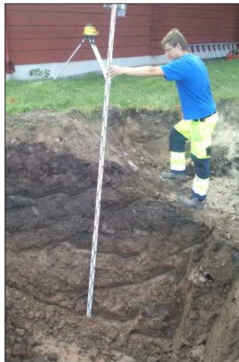
Figur 4. Schaktdjup 1,2 meter. Vy från NO.
