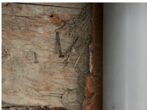
Figur 10. Timmerväggarna är lerklinade under de många lagren av tapeter. Foto: Tobias Mårud.
