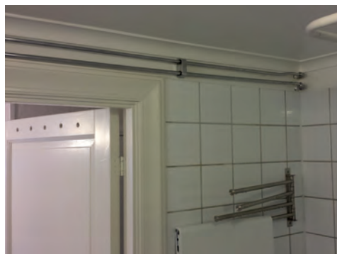
Figur 18. Fästpunkterna för de tidigare radiatorerna kunde återanvändas. Foto: Tobias Mårud.
