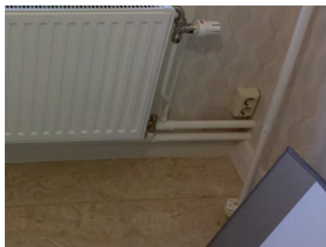
Figur 8. Exempel på flyttat eluttag, markeringar för håltagning syns på den bögra cäggen. Foto: Tobias Mårud.
