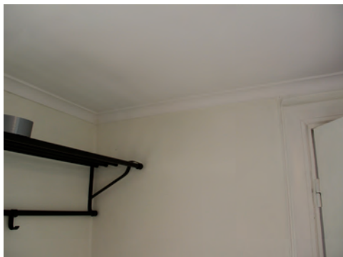
Figur 6. Rum 203, hallen, innan rördragning. Foto: Tobias Mårud.
