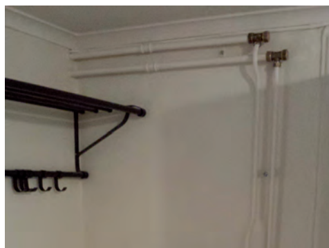
Figur 7. Samma vy efter dragningen är utförd. Rören är plomberade för att kunna skarvas vidare. Foto: Harakers bygg.
