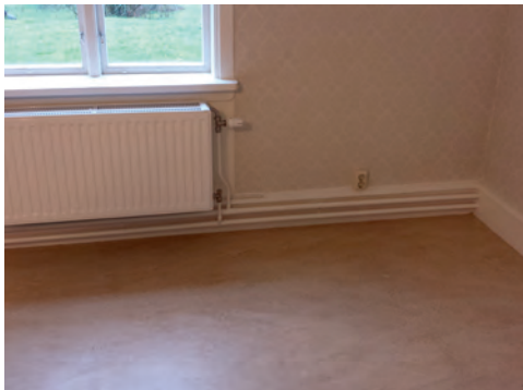
Figur 14. Värmerör dragna längs den bögre modellen av gohlüst. Foto: Harakers bygg.
