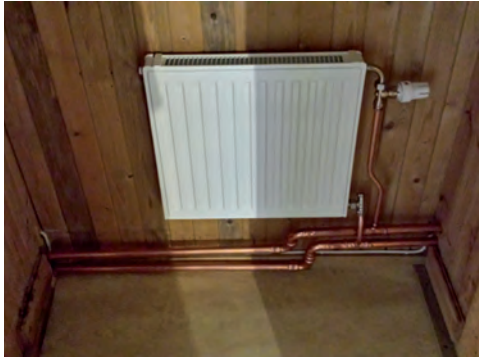
Figur 16. Radiator sattes upp även i ett förvaringsutrymme. Foto: Harakers bygg.
