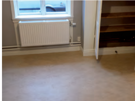
Figur 16. Radiator sattes upp även i ett förvaringsutrymme. Foto: Harakers bygg.
