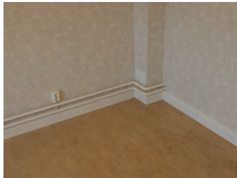
Figur 14. Värmerör dragna längs den bögre modellen av gohlüst. Foto: Harakers bygg.
