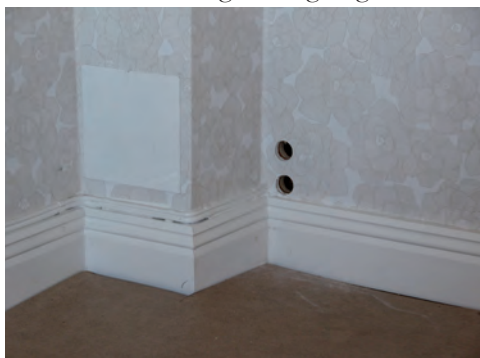
Figur 4. Håltagning i vägg, över golvlist. Foto: Tobias Mårud.
