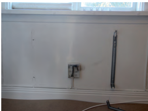
Figur 18. Fästpunkterna för de tidigare radiatorerna kunde återanvändas. Foto: Tobias Mårud.
