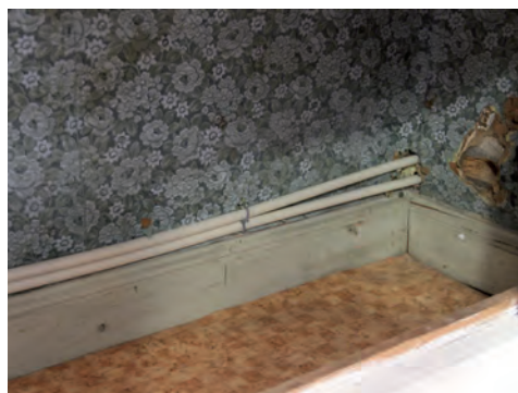
Figur 10. Timmerväggarna är lerklinade under de många lagren av tapeter. Foto: Tobias Mårud.
