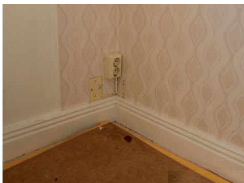
Figur 8. Exempel på flyttat eluttag, markeringar för håltagning syns på den bögra cäggen. Foto: Tobias Mårud.
