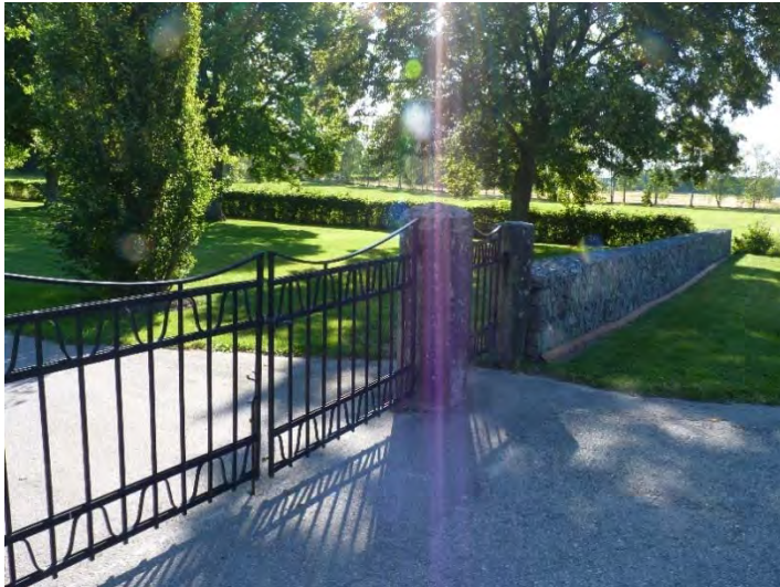
Figur 9. Cortenplåt utmed muren mot söder. Foto: Helén Sjökvist
