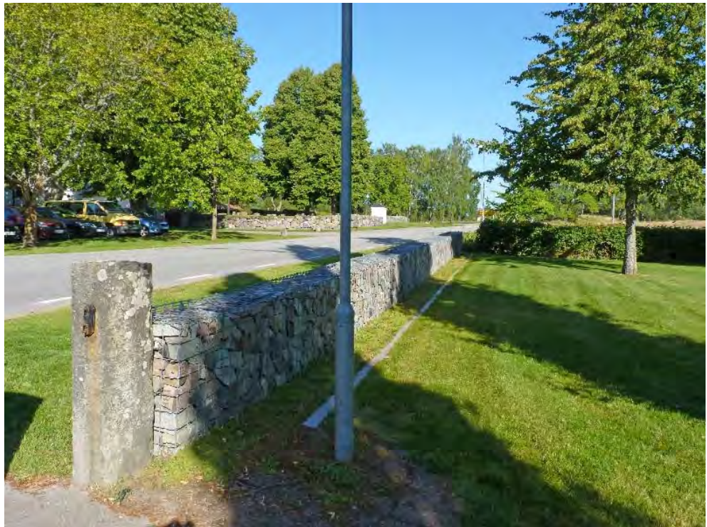
Figur 6. Ny gabionmur mot norr. Foto: Helén Sjökvist.
