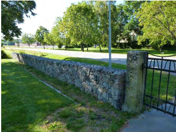
Figur 7. Ny gabionmur mot söder. Foto: Helén Sjökvist
