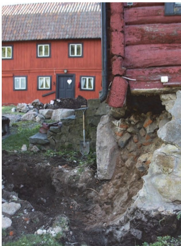
Figur 9. Schakt 2 under framgrävning. Fotograferat från norr av Jonas Ros.
