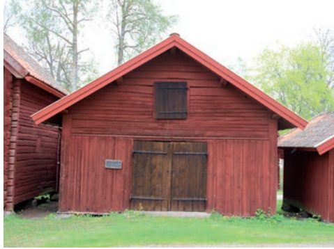
Figur 90. Södra gaveln innan åtgärd. Foto: Tobias Mårud.
