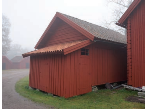
Figur 97. Byggnaden sedd från nordväst efter åtgärd. Foto: Tobias Mårud.
