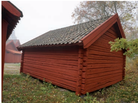
Figur 70. Södra fasaden efter åtgärd. Foto: Tobias Mårud.
