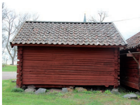
Figur 7. Östra fasaden innan åtgärd. Foto: Tobias Mårud.
