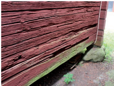
Figur 104. Östra fasadens timmer är delvis i ganska dåligt skick. Foto: Tobias Mårud.
