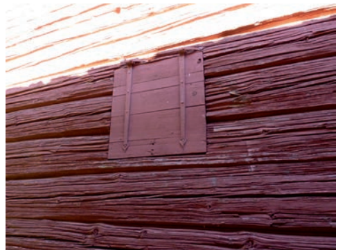
Figur 104. Östra fasadens timmer är delvis i ganska dåligt skick. Foto: Tobias Mårud.
