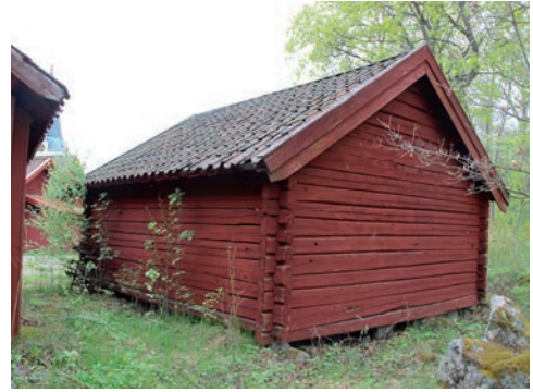
Figur 65. Byggnaden sedd från sydöst innan åtgärd. Foto: Tobias Mårud.
