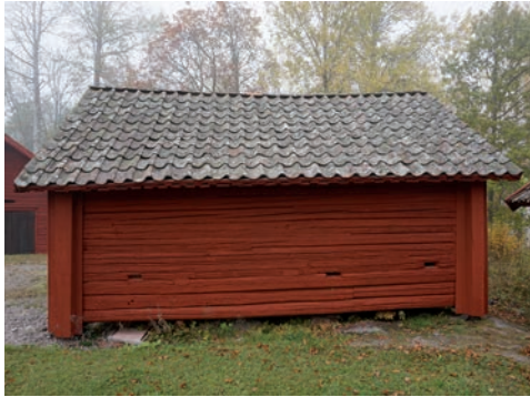
Figur 58. Södra fasaden efter åtgärd. Foto: Tobias Mårud.
