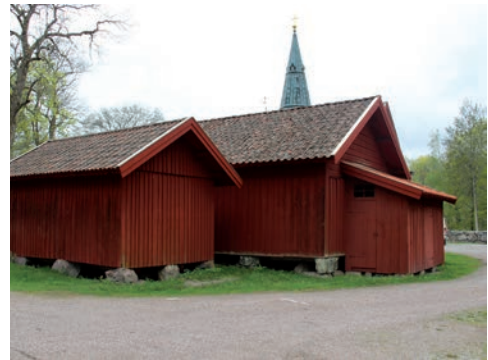
Figur 92. Byggnaden sedd från nordväst innan åtgärd. De omålade täckskivorna syns tydligt på tillbyggnaden. Foto: Tobias Mårud.
