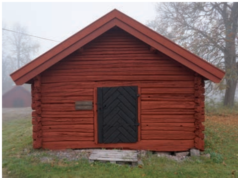
Figur 11. Södra gaveln efter åtgärd, bl.a. syns nya vindskivor. Foto: Tobias Mårud.
