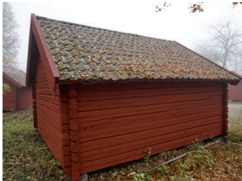
Figur 68. Norra fasaden efter åtgärd. Foto: Tobias Mårud.
