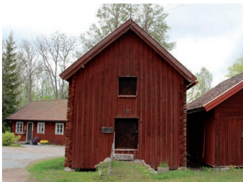
Figur 100. Södra gaveln innan åtgärd. Foto: Tobias Mårud.
