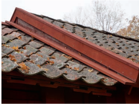
Figur 41. Norra delen av västra takfallet efter åtgärd, täckbräda ersatt. Foto: Tobias Mårud.
