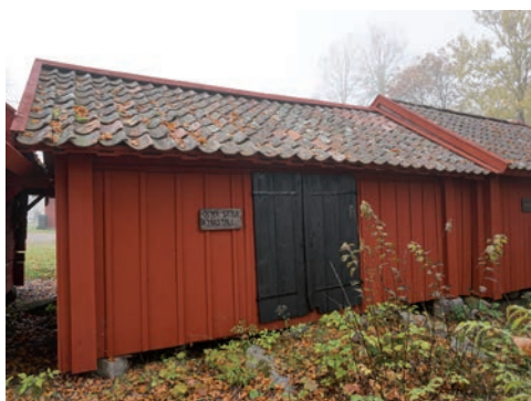
Figur 39. Östra fasaden efter åtgärd. Foto: Tobias Mårud.
