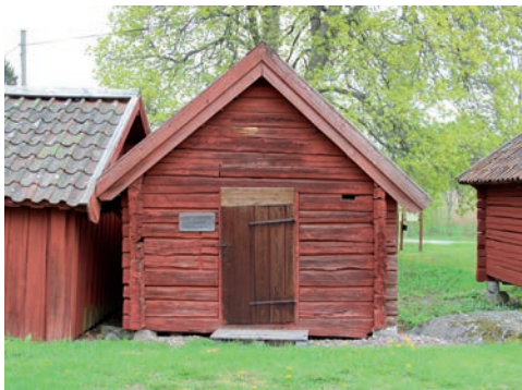
Figur 27. Västra gaveln innan åtgärd. Foto: Tobias Mårud.
