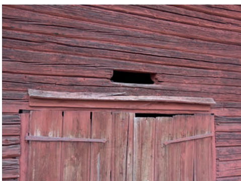
Figur 76. Dropplisten över porten innan åtgärd. Foto: Tobias Mårud.
