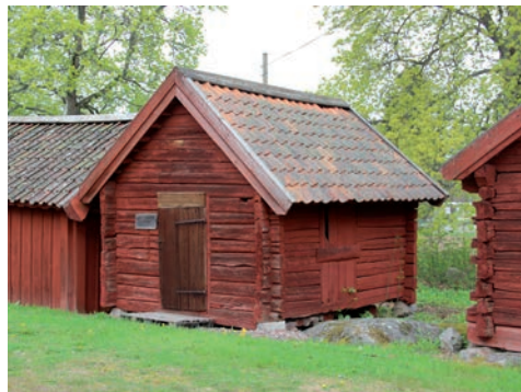
Figur 28. Byggnaden sedd från sydväst innan åtgärd. Foto: Tobias Mårud.
