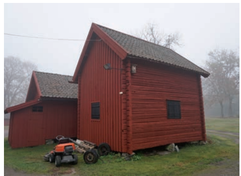
Figur 107. Byggnaden sedd från nordväst efter åtgärd. Foto: Tobias Mårud.
