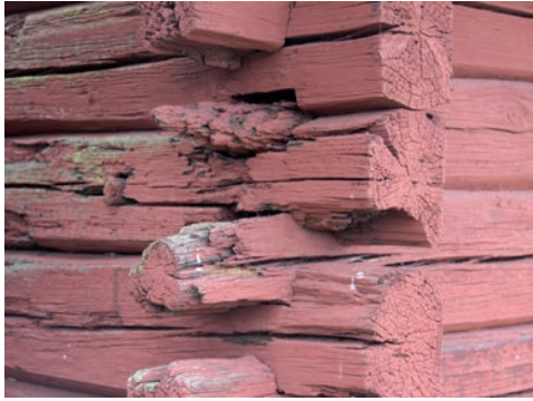
Figur 9. Nordvästra knutkedjan är delvis i dåligt skick, fyra knutskallar saknar helt eller delvis låsande funktion. Foto: Tobias Mårud.
