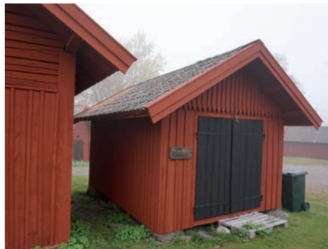
Figur 89. Byggnaden sedd från sydväst efter åtgärd. Foto: Tobias Mårud.
