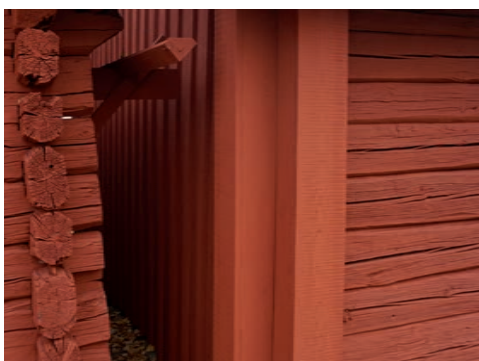
Figur 15. Nordvästra knutkedjan har skyddats med en knutlåda. Foto: Tobias Mårud.
