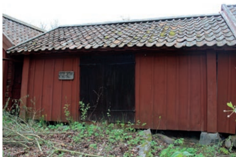
Figur 35. Östra fasaden innan åtgärd. Foto: Tobias Mårud.
