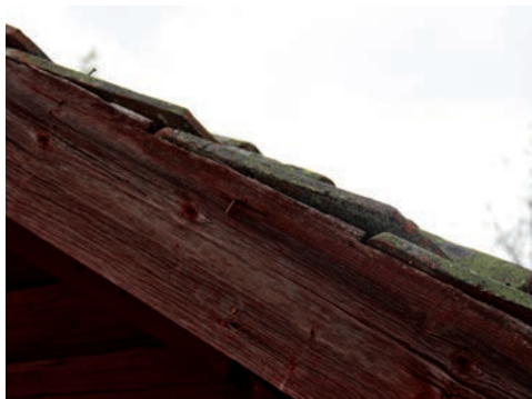
Figur 56. Detalj av vindskiva, med urtag för takteglan. Foto: Tobias Mårud.
