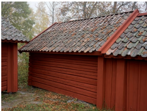
Figur 51. Västra fasaden efter åtgärd. Foto: Tobias Mårud.
