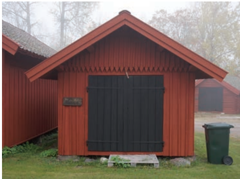
Figur 86. Södra gaveln efter åtgärd. Foto: Tobias Mårud.
