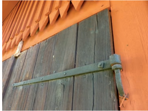
Figur 85. Detalj av porten, ena bandhångjärnet innan rotskyddsmålning. Foto: Helén Sjökvist.
