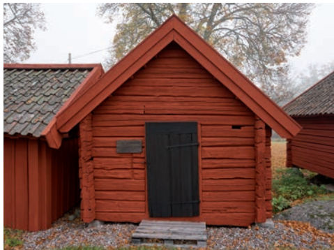
Figur 31. Västra gaveln efter åtgärd. Foto: Tobias Mårud.
