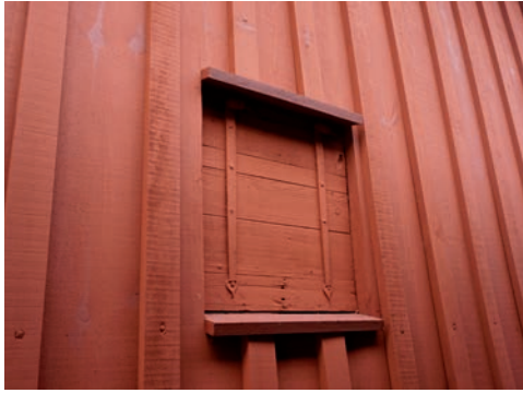
Figur 110. Luckan i östra fasaden efter åtgärd. Foto: Tobias Mårud.
