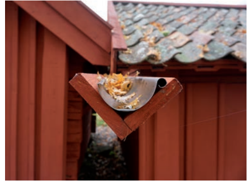
Figur 41. Norra delen av västra takfallet efter åtgärd, täckbräda ersatt. Foto: Tobias Mårud.
