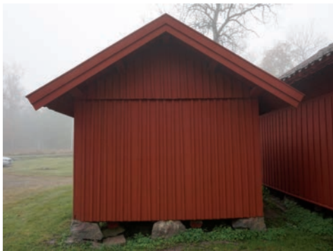
Figur 88. Norra gaveln efter åtgärd. Foto: Tobias Mårud.
