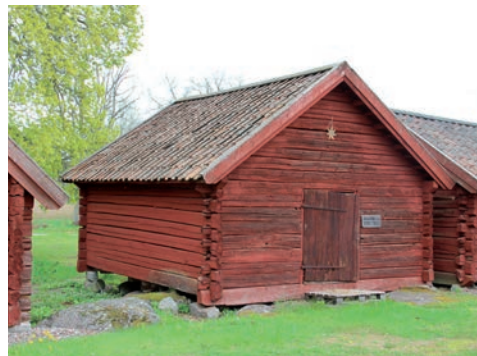
Figur 18. Byggnaden sedd från nordväst innan åtgärd. Foto: Tobias Mårud.
