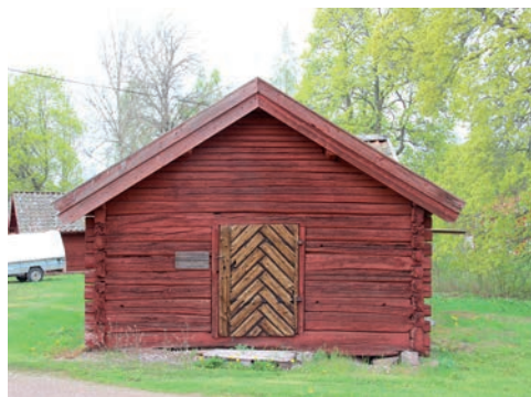
Figur 5. Södra gaveln innan åtgärd. Foto: Tobias Mårud.
