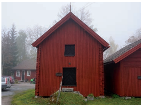
Figur 106. Södra gaveln efter åtgärd. Foto: Tobias Mårud.
