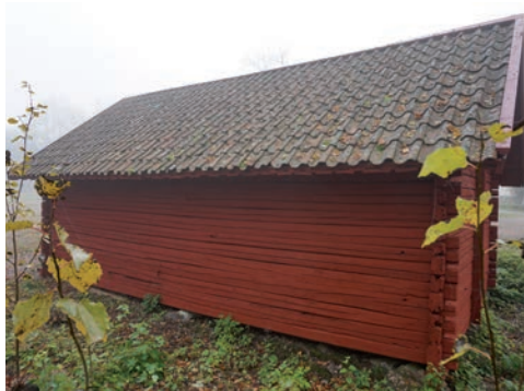
Figur 80. Nordöstra fasaden efter åtgärd. Foto: Tobias Mårud.
