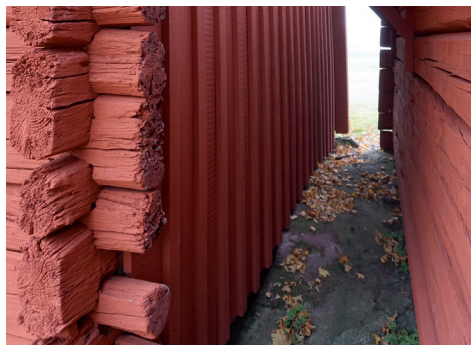
Figur 14. Norra gaveln har täckts med en skyddande panel. Foto: Tobias Mårud.
