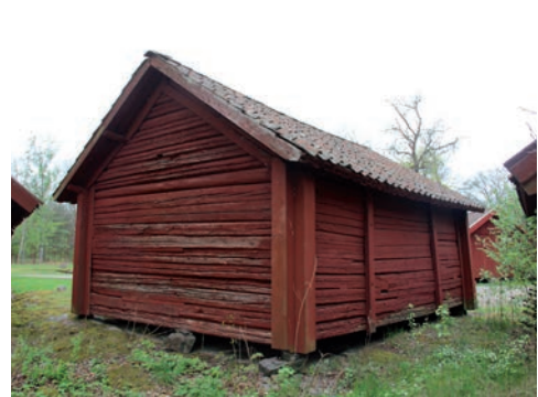
Figur 55. Byggnaden sedd från nordöst innan åtgärd. Foto: Tobias Mårud.
