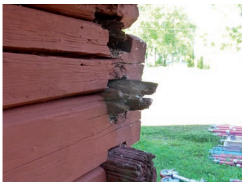
Figur 21. Del av nordvästra knutkedjan. Foto: Helén Sjökvist.
