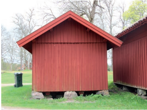
Figur 84. Norra gaveln innan åtgärd. Foto: Tobias Mårud.
