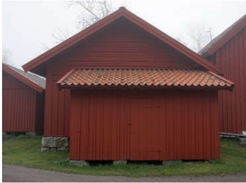
Figur 96. Norra gaveln efter åtgärd. Foto: Tobias Mårud.
