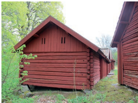
Figur 45. Norra gaveln innan åtgärd. Foto: Tobias Mårud.
