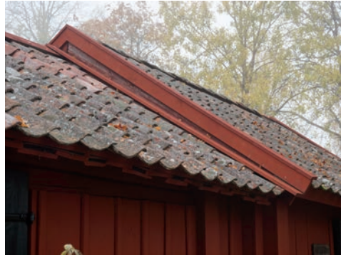
Figur 47. Östra takfallets vindskiva och täckebräda vid södra gaveln innan åtgärd. Foto: Tobias Mårud
