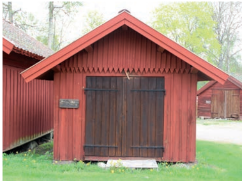
Figur 82. Södra gaveln innan åtgärd. Foto: Tobias Mårud.
