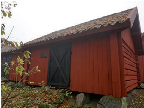
Figur 49. Östra fasaden efter åtgärd. Foto: Tobias Mårud.
