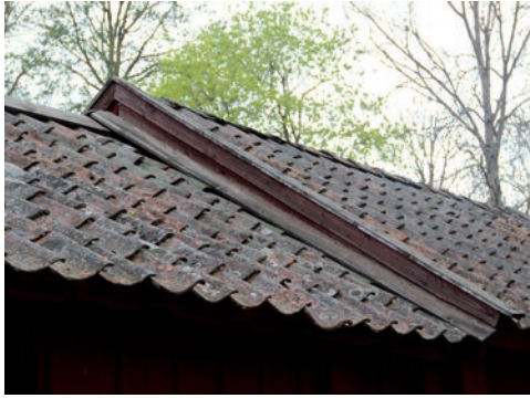
Figur 47. Östra takfallets vindskiva och täckebräda vid södra gaveln innan åtgärd. Foto: Tobias Mårud
