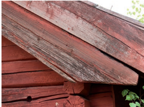
Figur 66. Detalj av vindskiva innan åtgärd. Vindskivorna ersattes. Foto: Tobias Mårud.
