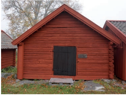
Figur 23. Västra gaveln efter åtgärd. Foto: Tobias Mårud.
