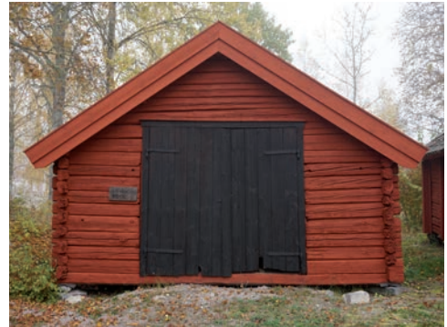
Figur 66. Detalj av vindskiva innan åtgärd. Vindskivorna ersattes. Foto: Tobias Mårud.
