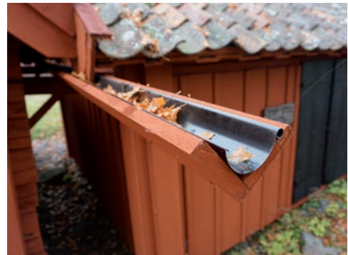
Figur 34. Ny ränna för regnvatten ersatte befintlig. Foto: Tobias Mårud.
