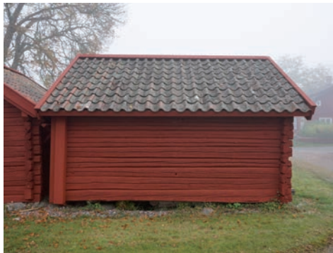
Figur 11. Södra gaveln efter åtgärd, bl.a. syns nya vindskivor. Foto: Tobias Mårud.
