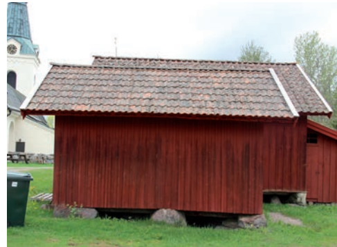
Figur 83. Östra fasaden innan åtgärd, täckbrädorna från 2014 är ännu omålade. Foto: Tobias Mårud.
