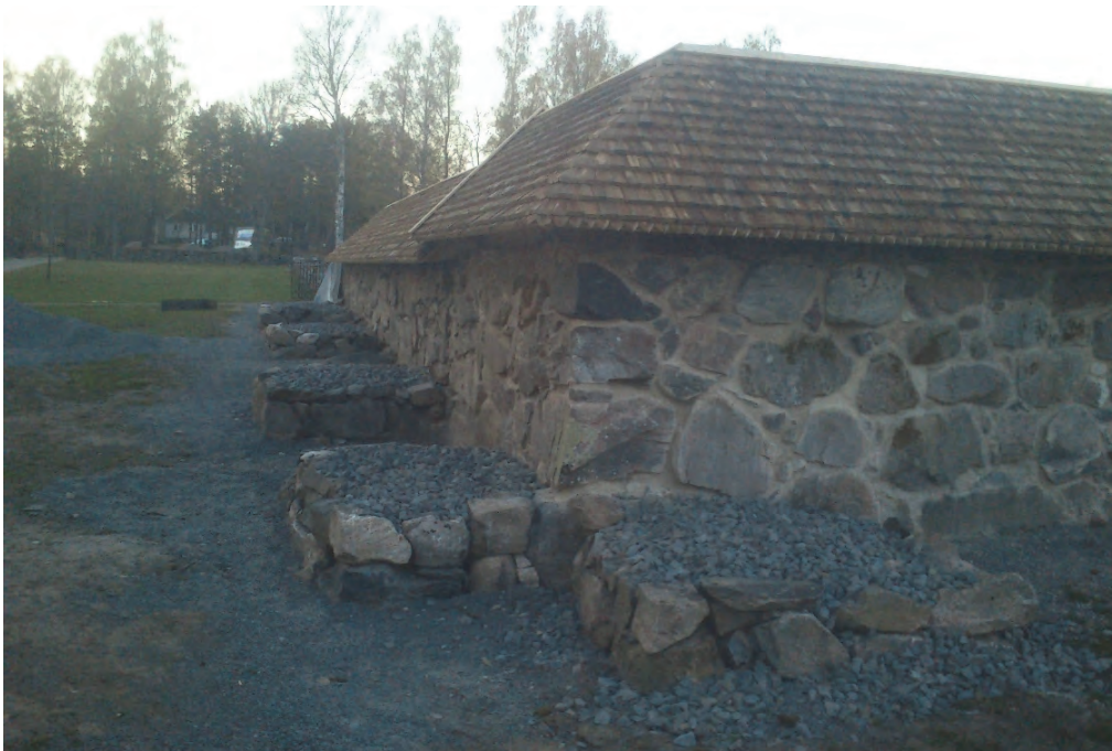
Figur 31. Kontreforer under uppbyggnad efter att murarna har restaurerats. Fotograferat från söder av Jonas Ros.
