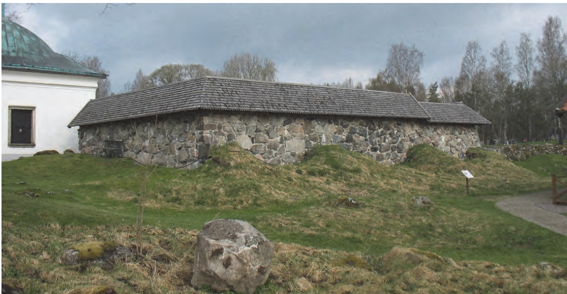
Figur 26. På den östra sidan av byggnaden finns det fyra synliga kontreforer som är övervuxna med gräs. Fotograferat från sydöst av Jonas Ros.
