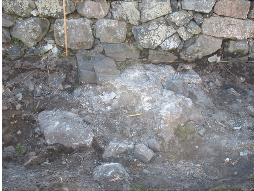
Figur 9. Kontrefor 6. Vidares ses delar av byggnadens västra mur. Fotograferat från väster av Jonas Ros.
