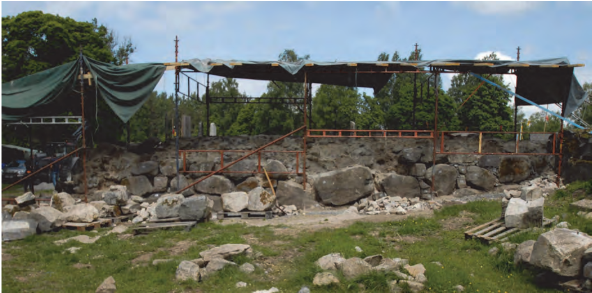
Figur 28. Delar av den södra muren plockades ned och murades sedan upp igen Fotograferat från söder av Janusz Grenberger.
