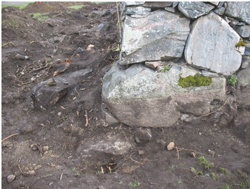
Figur 7. Rester av kontrefor 4 ses till vänster. Vidare ses byggnadens sydvästra hörn. Fotograferat från söder av Jonas Ros.
