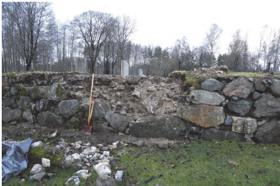
Figur 16. En av skadorna i den södra muren. Murbruket i murkärnan var mycket hårt. Fotograferat från söder av Jonas Ros.
