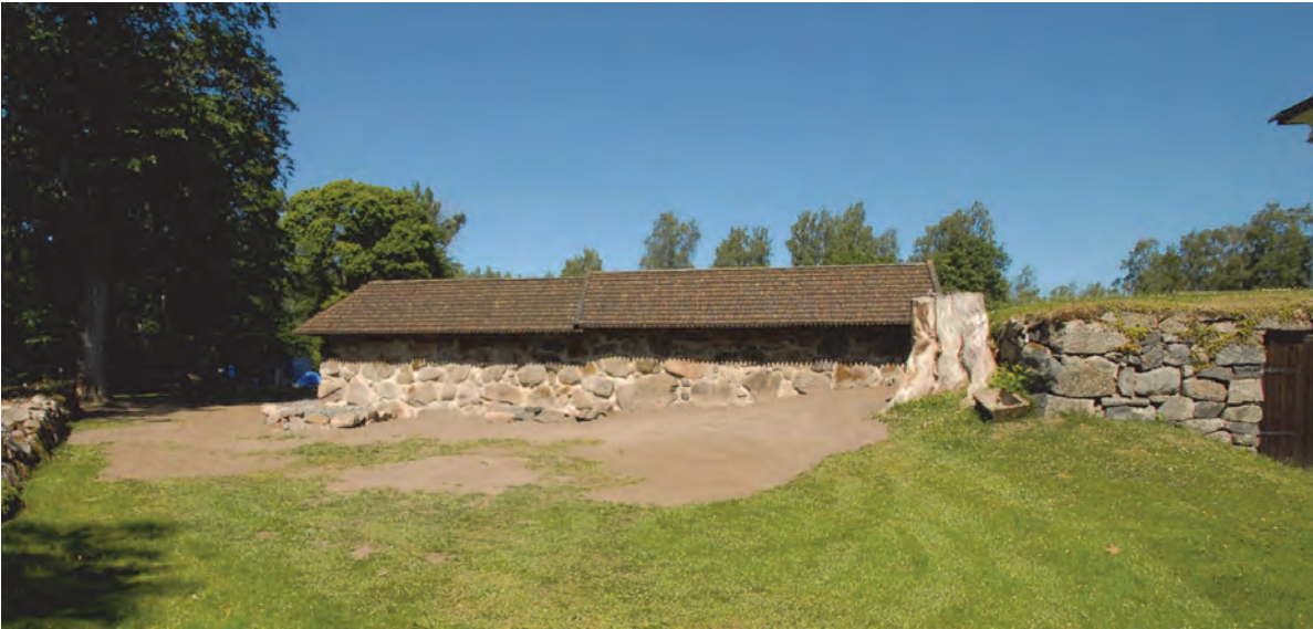
Figur 30. Den södra muren har restaurerats och fått ett tak. Vidare är kontreforena markerade. Fotograferat från söder av Janusz Grenberger.
