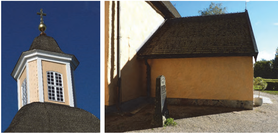
Figur 82. Lanternintaket efter omtjärning sett från sydöst. Foto: Helén Sjökvist.
