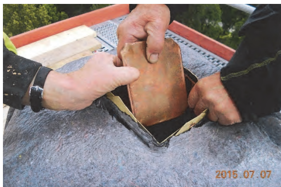
Figur 77. Nedläggning av nytt kroppåsbrev. Foto: Hedemora Byggplåt.
