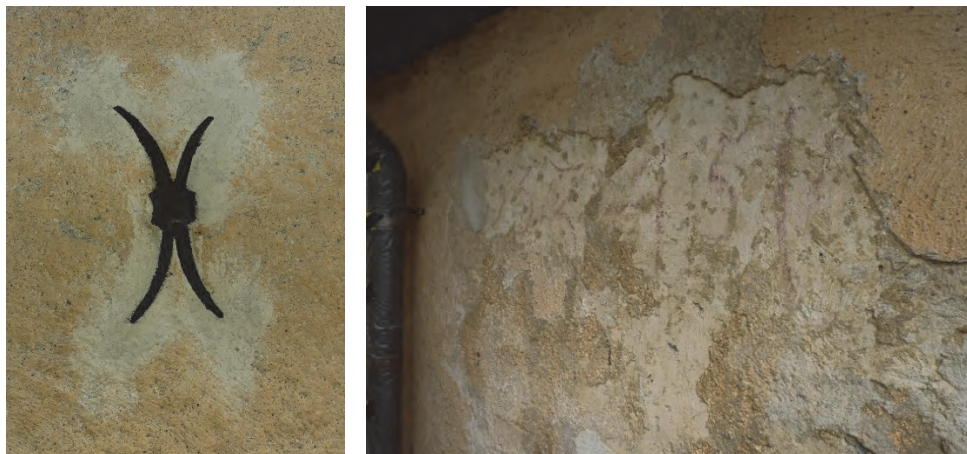
Figur 17. Ankarjärn målat med isotrol, putslagningar, norra sidan på tornet. Foto: Helén Sjökvist.
