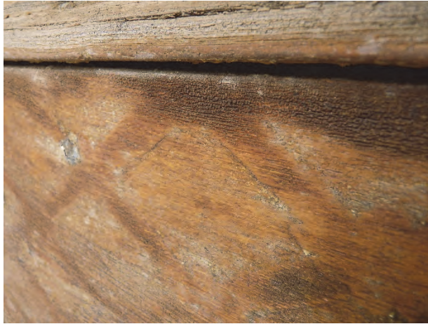
Figur 42. Romberna ligger något djupare i träet än nätmönstret. Träet vittrat. Foto före åtgärd. Foto: Helén Sjökvist.
