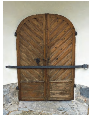
Figur 43. Dörrens yta täcktes tidigare av någon form av lack som släppte i flagor. Foto före åtgärd. Foto: Helén Sjökvist.
