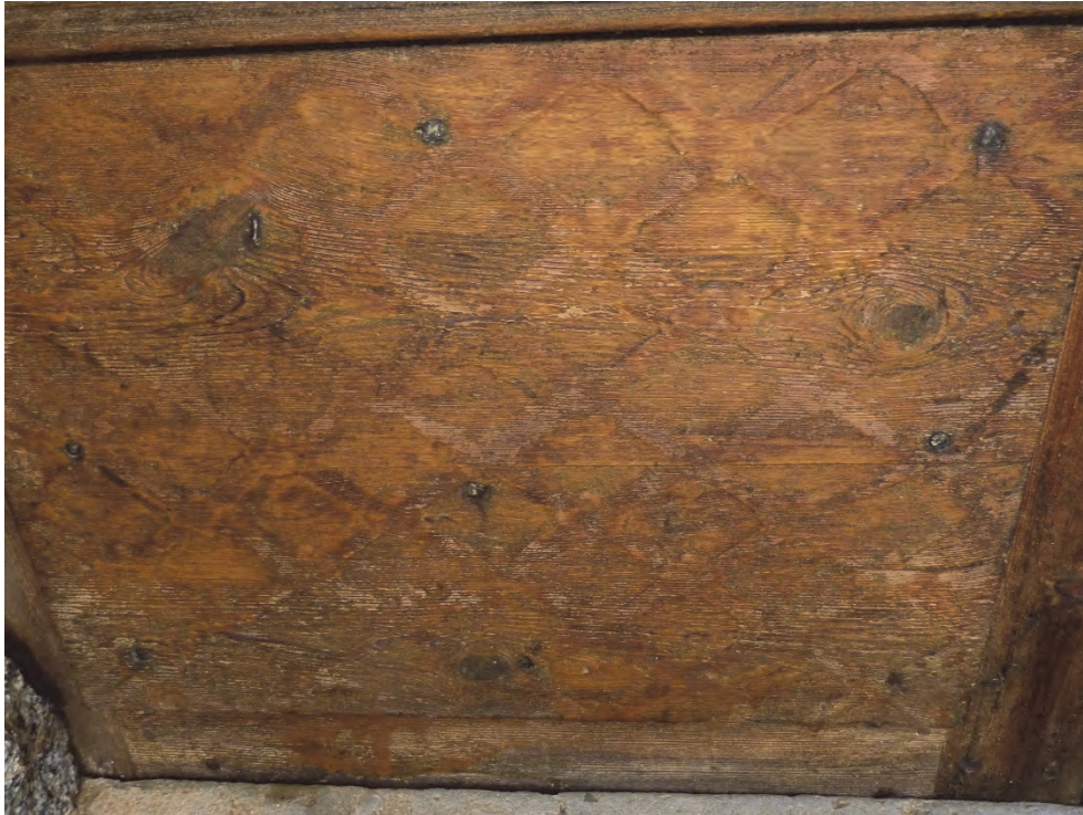
Figur 47. Det rombformade nätmönstret har hanterats extra varsamt. Foto efter åtgärd. Foto: Helén Sjökvist.
