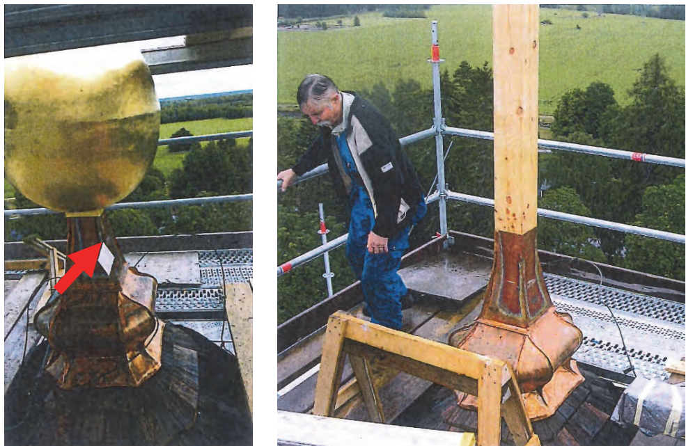
Figur 69. Ny koppartäckning under kulan. Vid den röda pilen sitetr den fals markerad som skall kunna öppnas vid framtida nedmontering av korset. Foto: Bengt Andersson.
