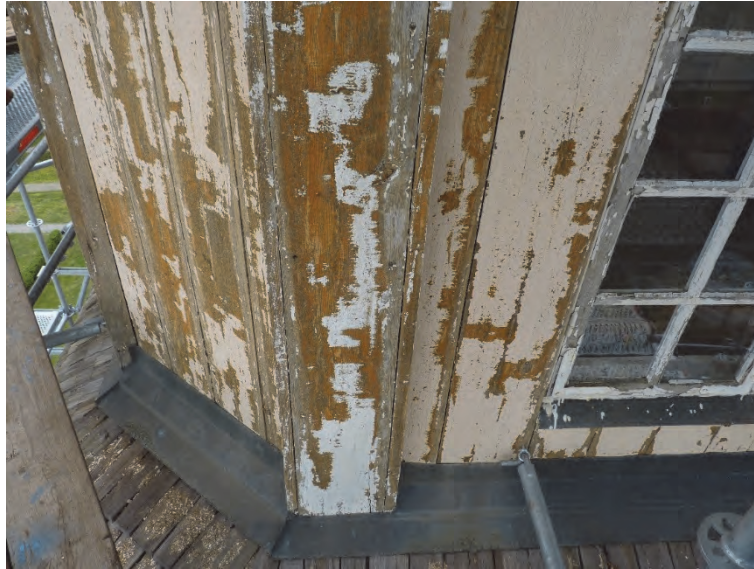
Figur 31. Lanternin, nordöstra hörnet. Skrapning av panelen pågår. Foto: Helén Sjökvist.
