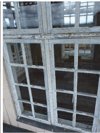
Figur 26. Färgen på lanterninen uppvisar likheter med en åldrande linoljefärg. Foto: Helén Sjökvist. Figur 27. Färgskiktet på lanterninen var före åtgärder i dåligt skick. Foto: Helén Sjökvist.
