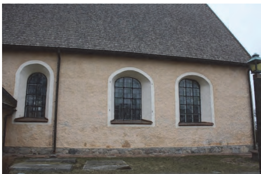
Figur 12. Södra fasaden före åtgärder. Foto: Helén Sjökvist.
