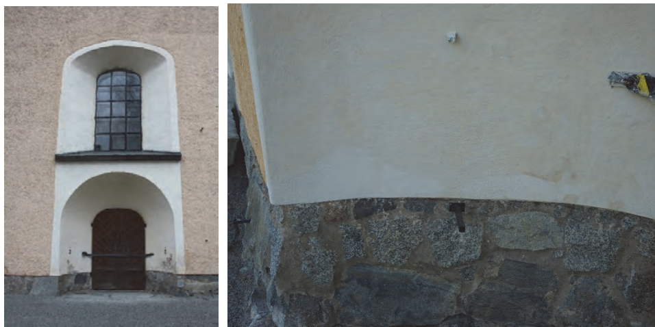
Figur 24. Putssläpp kring västporten. Foto: Helén Sjökvist.
