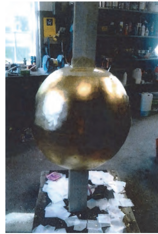
Figur 71. Kulan rengjord inför grundning. Foto: Astrum förgyllning & måleri. Figur 72. Kulan är omsförgylld. Foto: Astrum förgyllning & måleri.
