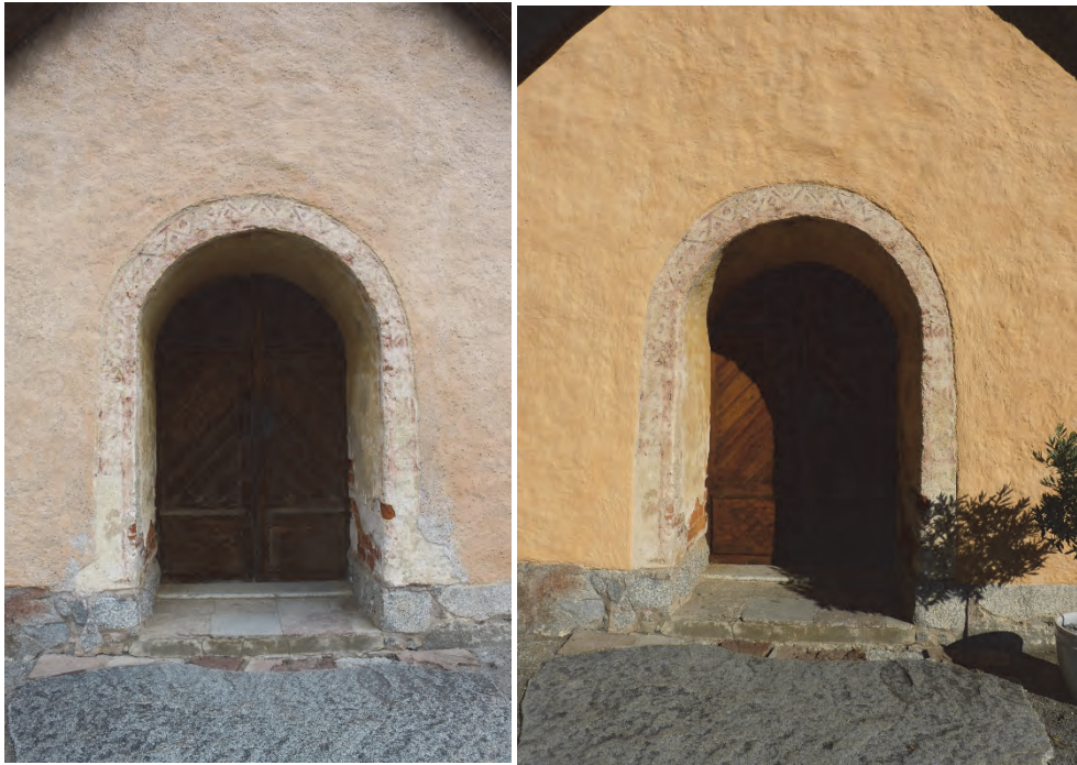
Figur 20. Vapenhusets sydentré före åtgärder. Foto: Helén Sjökvist.
