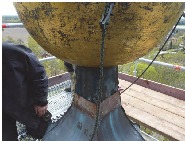
Figur 65. Det tidigare korset sett från väster. Förgyllningen är till stora delar bortnött. Foto: Helén Sjökvist.
