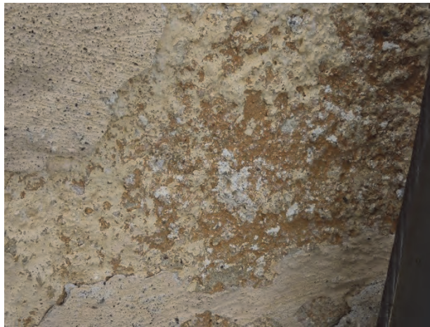
Figur 9. Tornets östra sida, putsläpp med underliggande färglager. Den mörkögula ligger under en ljusare gul kulör. Över dessa ligger nuvarande putslager. Möjligen dålig rengöringsgrad av underliggande färgskikt vid tidigare renovering. Foto: Helén Sjökvist.
