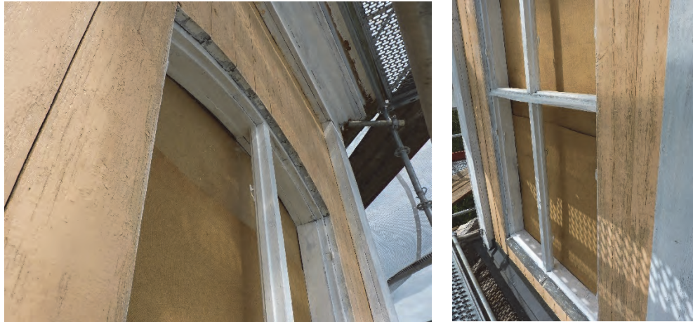
Figur 37. Södra fönstret sponten tillbakalagen. Panelen grundad och mellanstruken. Foto: helén Sjökvist
