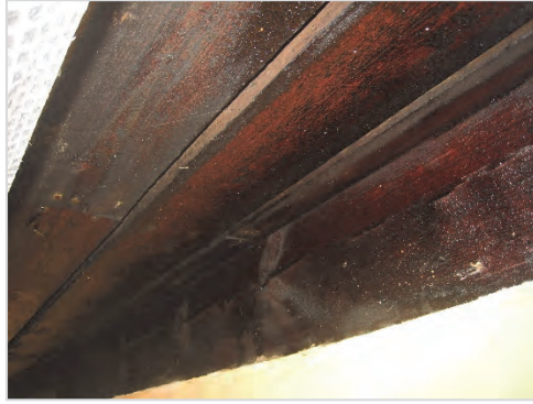
Figur 86. Tjärad takfot. Foto: Helén Sjökvist.
