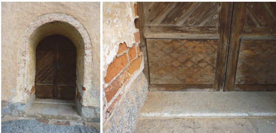
Figur 40. Södra vapenbusentrén före åtgärder. Foto: Helén Sjökvist.
