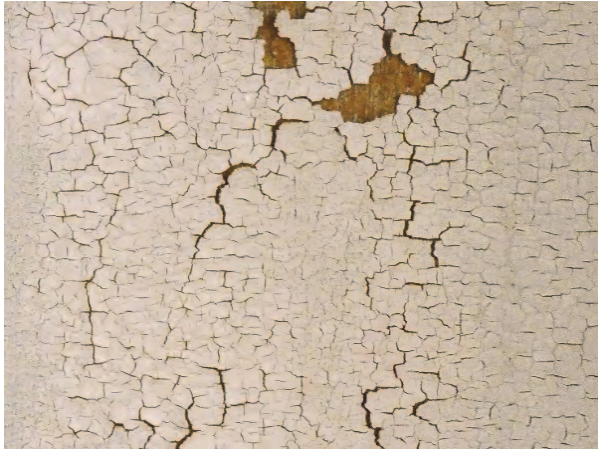
Figur 26. Färgen på lanterninen uppvisar likheter med en åldrande linoljefärg. Foto: Helén Sjökvist. Figur 27. Färgskiktet på lanterninen var före åtgärder i dåligt skick. Foto: Helén Sjökvist.
