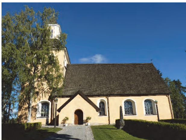
Figur 89. Kyrkan sedd från söder efter renovering. Foto: Helén Sjökvist.
