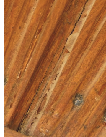
Figur 42. Romberna ligger något djupare i träet än nätmönstret. Träet vittrat. Foto före åtgärd. Foto: Helén Sjökvist.
