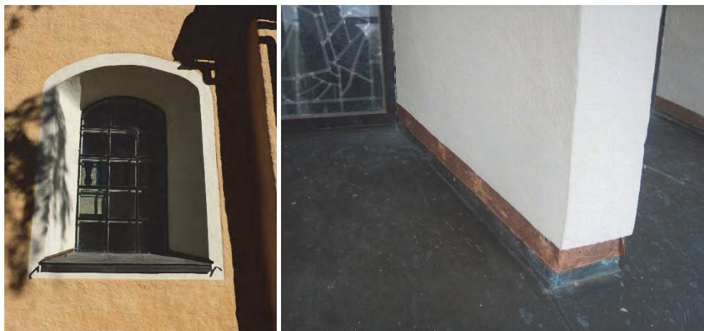
Figur 63. Södra tornfönstret efter åtgärder. Foto: Helén Sjökvist.
