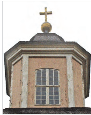
Figur 26. Färgen på lanterninen uppvisar likheter med en åldrande linoljefärg. Foto: Helén Sjökvist. Figur 27. Färgskiktet på lanterninen var före åtgärder i dåligt skick. Foto: Helén Sjökvist.
