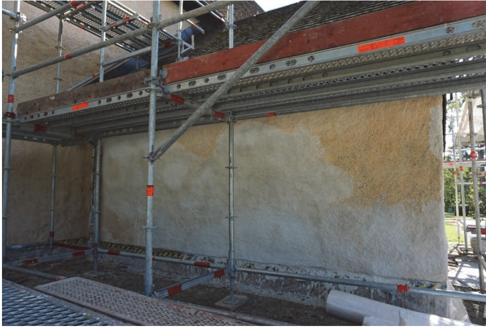
Figur 19. Omputsning av vapenhusets västra fasad. Foto: Tobias Mårud.
