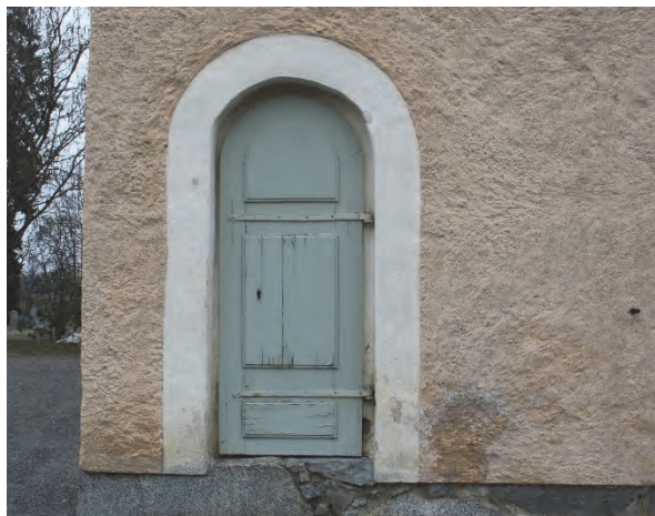
Figur 51. Torntrappan före åtgärder. Foto: Helén Sjökvist.
