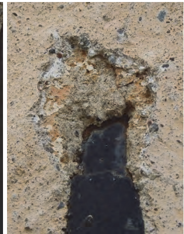
Figur 9. Tornets östra sida, putsläpp med underliggande färglager. Den mörkögula ligger under en ljusare gul kulör. Över dessa ligger nuvarande putslager. Möjligen dålig rengöringsgrad av underliggande färgskikt vid tidigare renovering. Foto: Helén Sjökvist.
