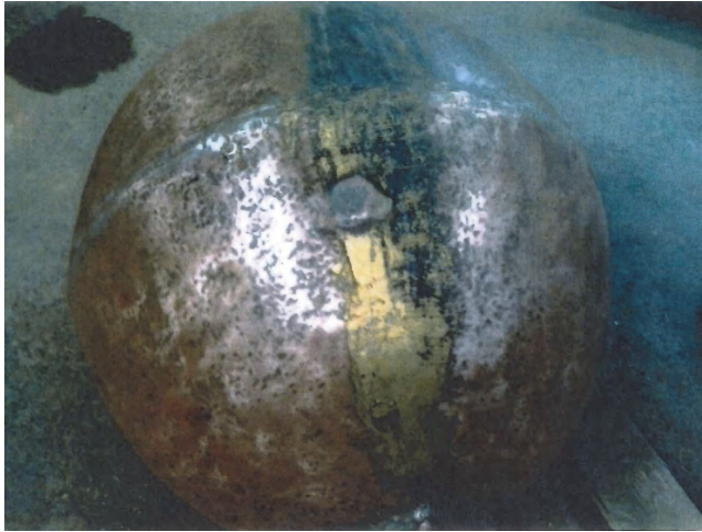
Figur 71. Kulan rengjord inför grundning. Foto: Astrum förgyllning & måleri. Figur 72. Kulan är omsförgylld. Foto: Astrum förgyllning & måleri.
