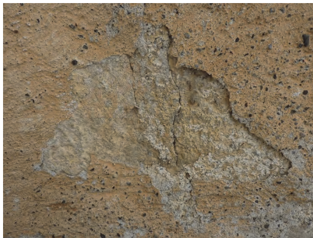
Figur 11. Äldre, underliggande puts på vapenhusets västra sida. I den nyare putsen avtecknar sig de mörka ballastkornen tydligt, medan den underliggande putsen har en slätare karaktär. Foto: Helén Sjökvist.
