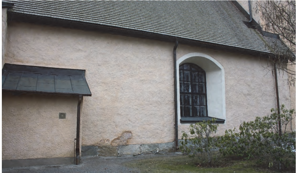
Figur 14. Norra fasaden före åtgärder. Foto: Helén Sjökvist.
