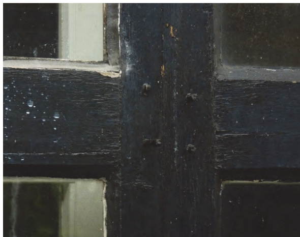
Figur 53. Fönster på norra långhusväggen före åtgärder. Utkrypande plugg. Foto: Helén Sjökvist.
