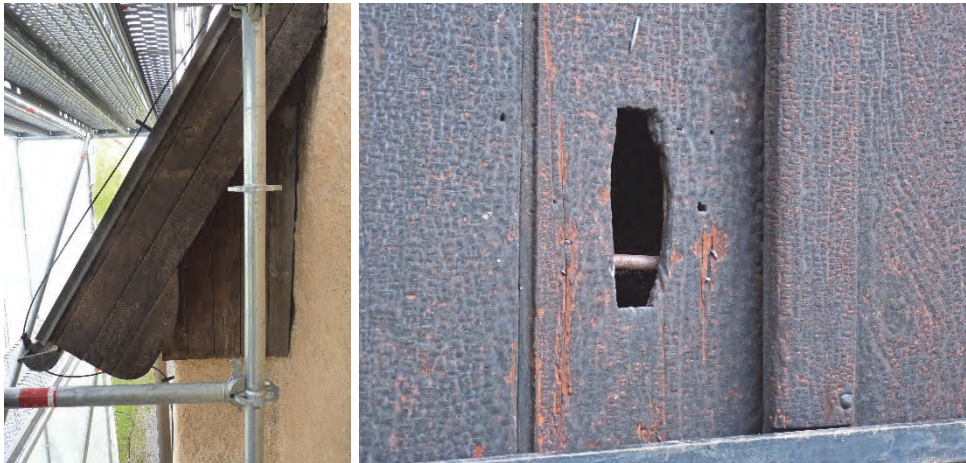
Figur 84. Vindskivor och takfot tjärades. Foto före åtgärd. Foto: Helén Sjökvist.
