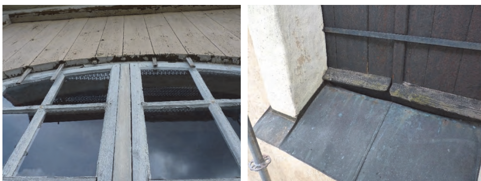
Figur 57. Lanterninfönster södra sidan. Den lösa spanten i panelen släpper ovan fönstret. Foto: Helén Sjökvist.
