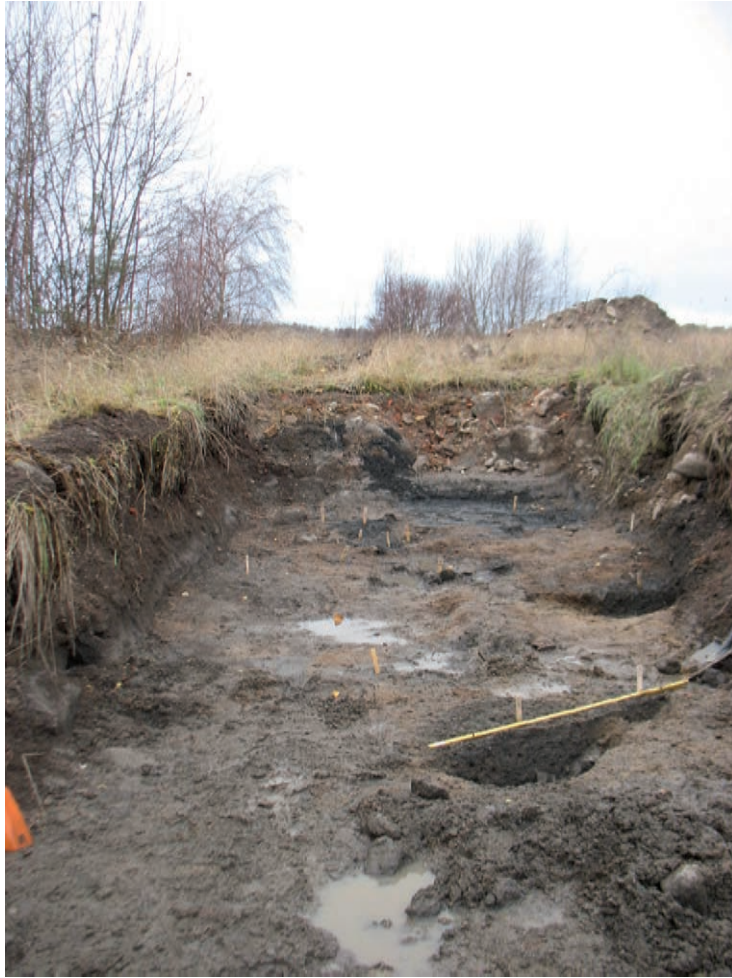
Figur 8. Den västra änden av schaket 862. I schaktrüggen i änden av schaketet syns de påförda massorna som är rödaktiga till färgen p.g.a. stort inslag av tegel. Foto Jan Ahlström (KM13102_39).
