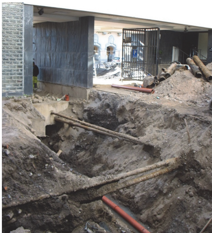
Figur 6. Det fanns omfattande störningar i området. Kulturlager fanns bevarat till höger om mellanväggen där sektion 2 upprättades (se figur 4 och 5). Fotograferat från sydöst av Jonas Ros.
