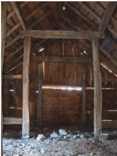
Figur 6b. Interiör i långhuset. Här ses ett inre stolppar som bär delar av taket. Gaveln var uppförd i skiftesverksteknik. Fotograferat av SAU. Fotograf Markus Andersson.
