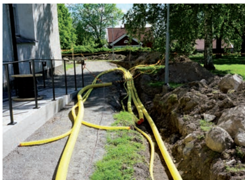
Bild 8. Schaktet med pågående nedläggning av kabelrör, här söder om långhuset. Foto: Tobias Mårud.
