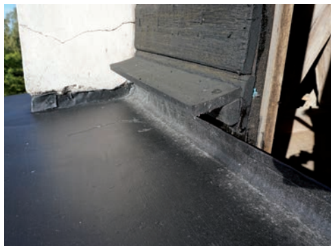
Bild 54. På södra och östra luckorna monterades en djupare droppnäs över de befintliga. Foto: Tobias Mårud.
