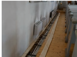
Bild 29 (vänstra bilden). Kabelkanalerna i långhuset var tidigare täckta med lackad board. Foto: Tobias Mårud.
