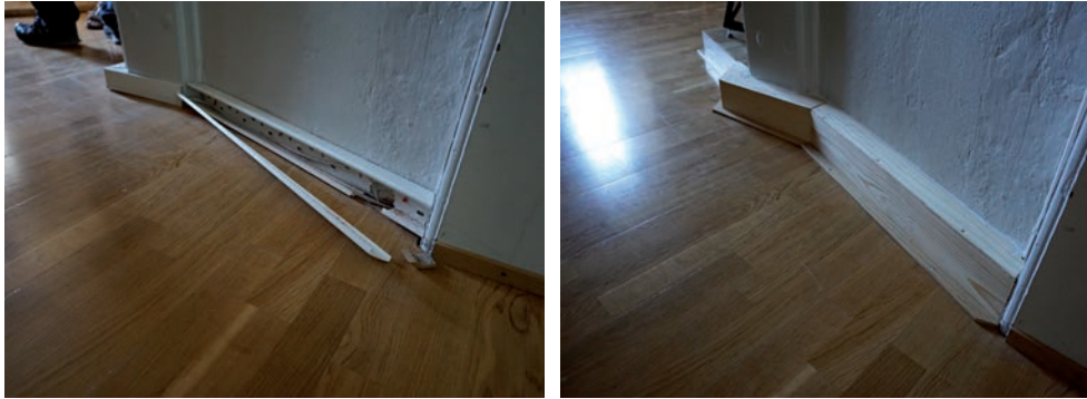
Bild 40. Den tidigare plastkanalen på södra sidan av passagen mellan sakristia och kor togs bort. Foto: Tobias Mårud.
