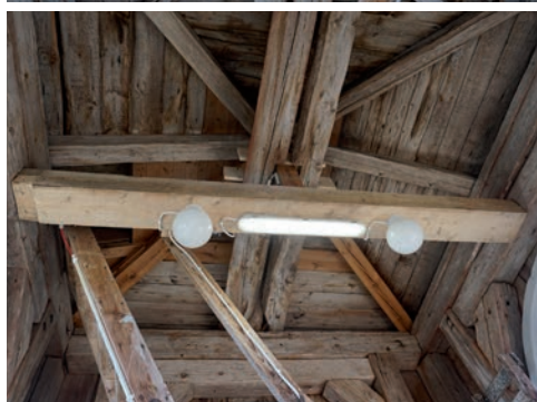
Bild 55 (övre vänstra). Mittstolpen har placerats i tvärbjälken. Foto: Tobias Mårud.
