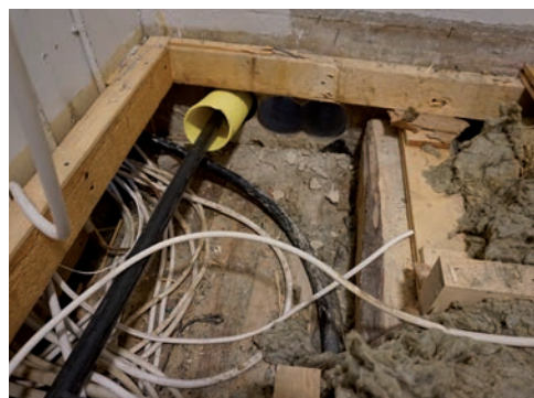
Bild 10. Håltagning i västra delen av långhusets södra fasad, tre hål med 13 cm diameter. Foto: Tobias Mårud.
