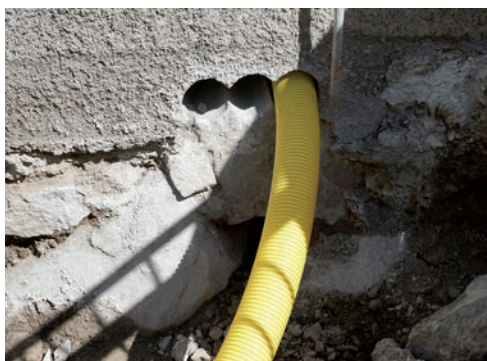
Bild 10. Håltagning i västra delen av långhusets södra fasad, tre hål med 13 cm diameter. Foto: Tobias Mårud.
