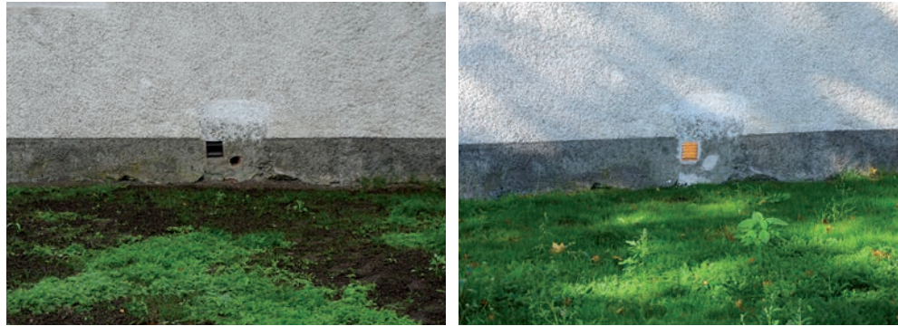
Bild 59. Östra fasaden innan åtgärd, en plåtkåpa har dock avlägsnats. Foto: Tobias Mårud.
