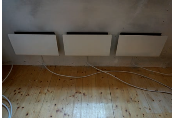
Bild 26 (överst till vänster). Äldre radiatorer under östra fönstret i långhusets södra vägg. Foto: Tobias Mårud.
