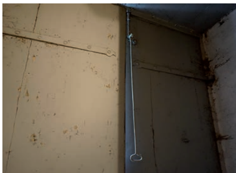
Bild 18. Dörren invändigt innan åtgärd. Foto: Tobias Mårud.
