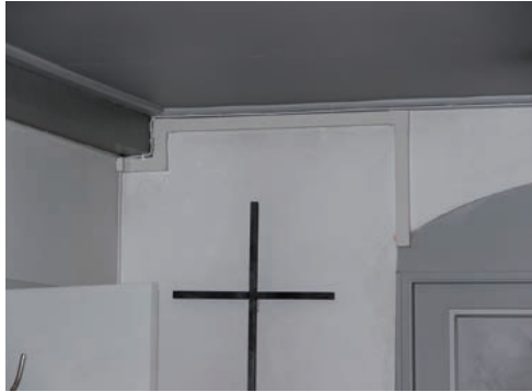
Bild 34. Plastkanalen på västra väggen i långhuset togs bort. Foto: Tobias Mårud.
