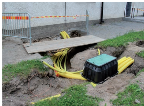
Bild 8. Schaktet med pågående nedläggning av kabelrör, här söder om långhuset. Foto: Tobias Mårud.
