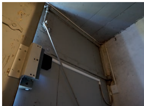
Bild 19. Efter montering av motorlås och larmmagnet. Foto: Tobias Mårud.
