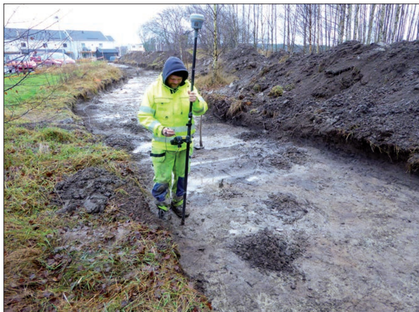
Figur 5. Inmätning av anläggningar med RTK-GPS i schaktets västra del. Projektledaren Mats Nelson försöker hålla god min i novemberrusket. Bilden tagen från väst. Foto Reidar Magnusson.
