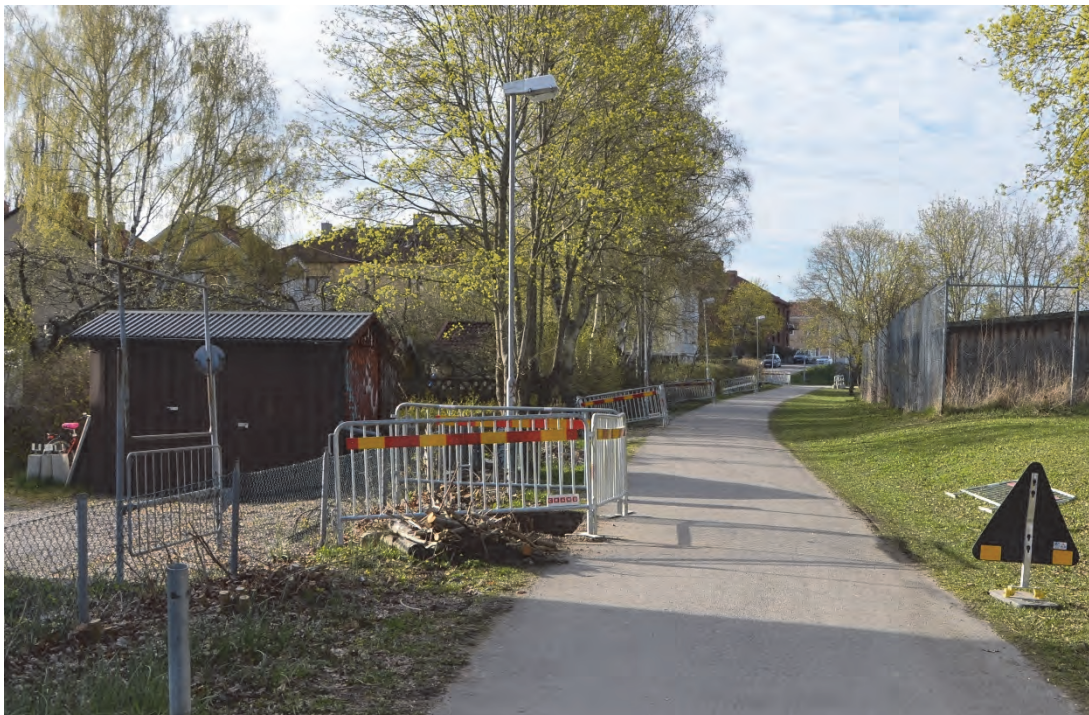
Figur 2. Schakten togs upp längs med S:t Johannesgatan, som tidigare varit ett industrispår som tillhört Bolinder-Munktell. I förgrunden ses schakt 6 och därbakom schakt 5, 4, 3 och 2. Fotograferat från nordväst av Jonas Ros.
