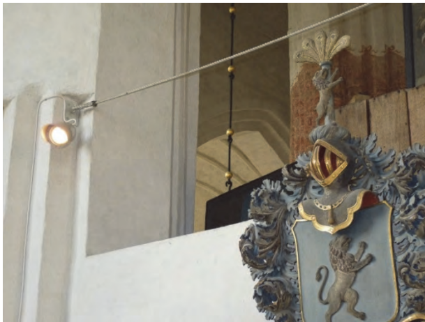
Figur 12. Befintliga infästningar mot pelarna Foto: Helén Sjökvist.
