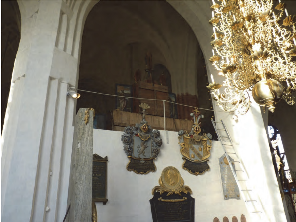
Figur 11. Förutvarande konstruktion sedd från öster. Räcknet hade endast ett vertikalt järn och ett rep mellan pelarna. Befintlig infästning i muren, centralt i bild, ersattes av två infästningar bakom epitafierna. Observera stege. Foto: Helén Sjökvist.
