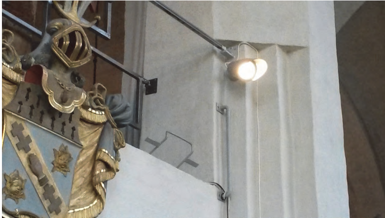
Figur 18. Norra rücket. Främre infästningen har återanvänts. Observera fästnanordning för stege samt handtag som kvarstår lika befintligt. Foto: Helén Sjökvist.
