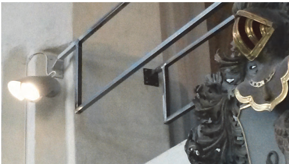
Figur 17. Södra delen av räcket. Den främre infästningen har kunnat återanvändas och ny har endast tillkommit för de bakre räcket. Foto: Helén Sjökvist.
