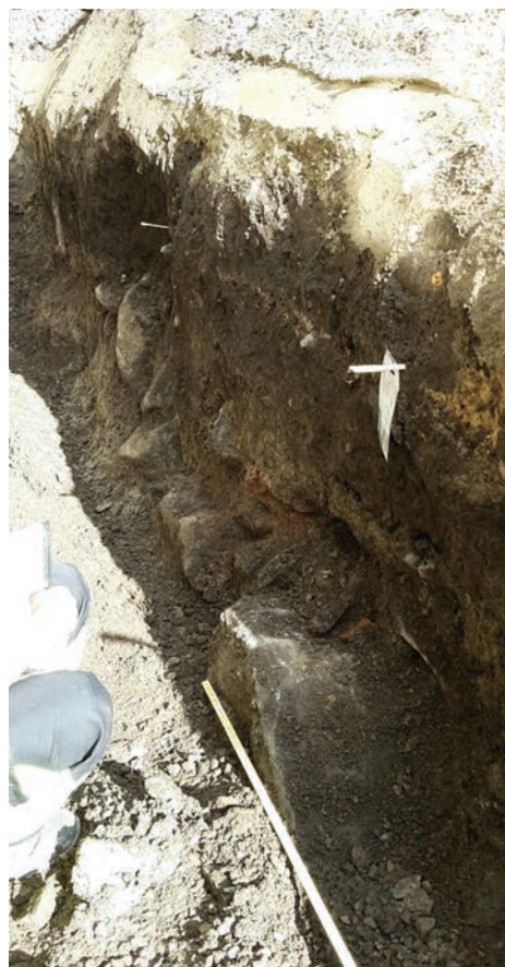
Figur 12. Stenraden i schakt 2 ses på botten av schaktet. Foto mot norr av Britta Kihlstedt.
