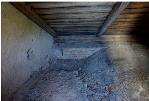
Figur 9 (övre, vänster). Södra korsarmens vind innan isolering. Foto: Tobias Mårud.
