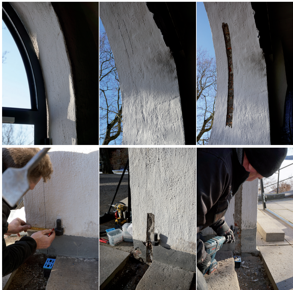
Figur 27–32. Inpassningen av dörrpartiet i öppningen krävde flera mättagningar med dörr på plats och efterföljande bortbilning av puts. Foto: Tobias Mårud.
