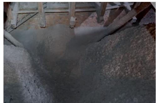
Figur 18. Isoleringen täcker inte bara valven utan i princip hela vindsytan med resultatet att konstruktionsdetaljer och historiskt ”byggskräp” inte längre är synligt. Här en del av vindens norra sida innan isolering. Foto: Tobias Mårud.
