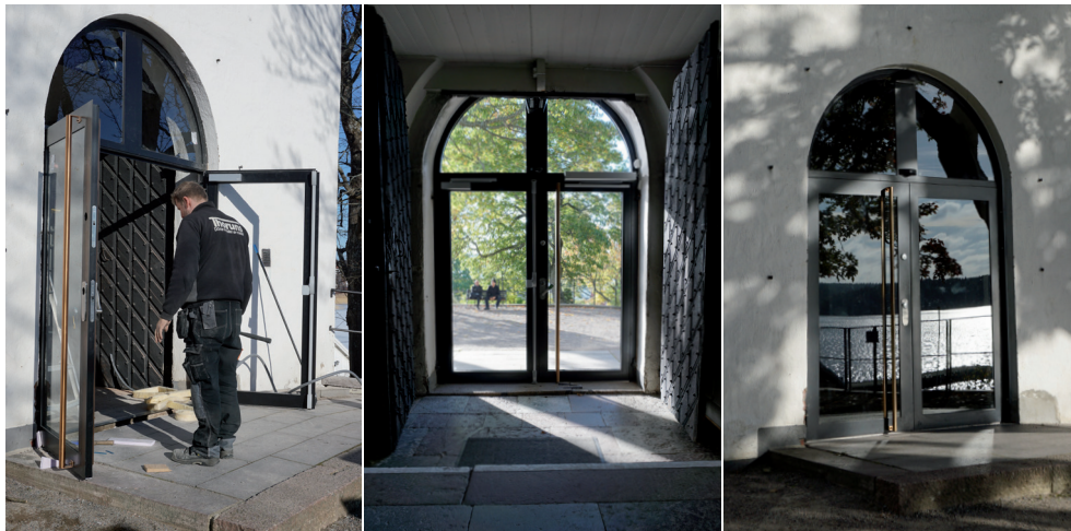
Figur 33. Pågående arbete efter att dörrpartiet kommit på plats. Foto: Tobias Mårud.
