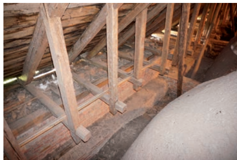
Figur 18. Isoleringen täcker inte bara valven utan i princip hela vindsytan med resultatet att konstruktionsdetaljer och historiskt ”byggskräp” inte längre är synligt. Här en del av vindens norra sida innan isolering. Foto: Tobias Mårud.
