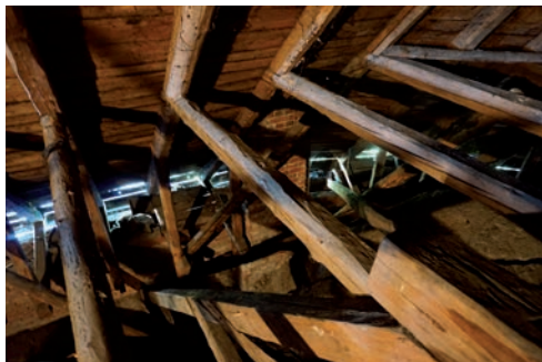
Figur 20. Norra delen av vinden över koret innan isolering. Foto: Tobias Mårud.
