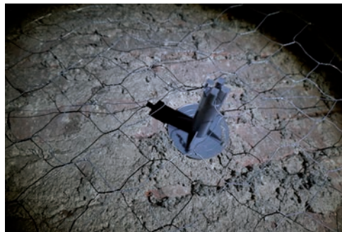
Figur 14. Den första travéens valv med isolering från 1994. Foto: Tobias Mårud.
