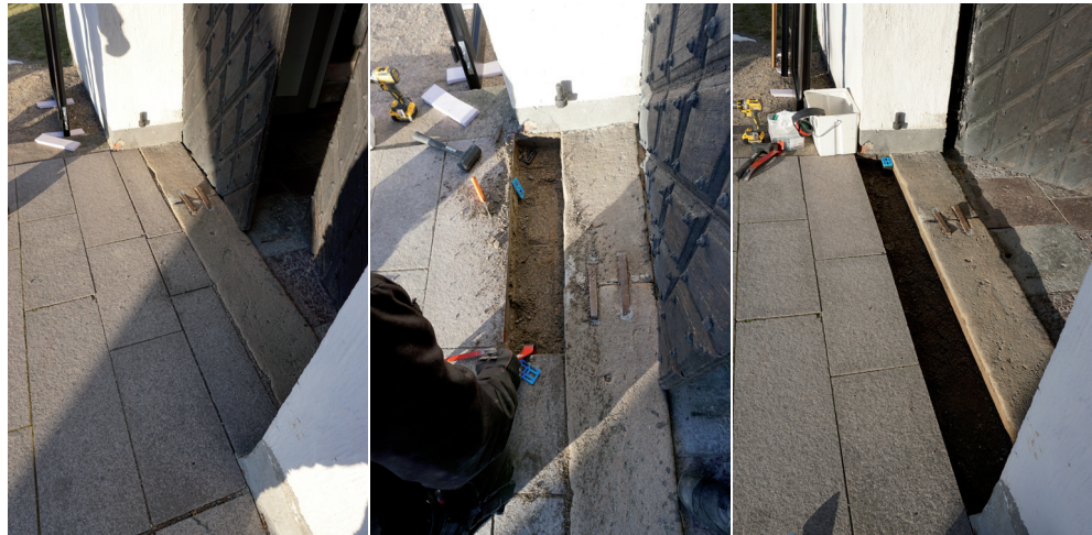
Figur 24. Stenraden närmast dörröppningen i södra fasaden lyftes temporärt bort. Foto: Tobias Mårud.
