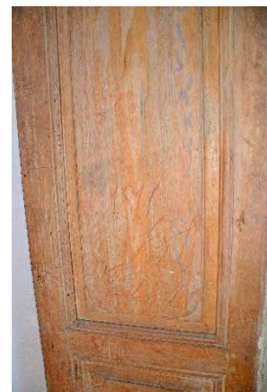
Figur 16. Baksidan till en av dörrarna till garderoben/tidigare handkammaren. Baksidan har endast en tunn fernissa eller ett mycket tunt bemålat ytskikt som gulnat kraftigt. Foto Helén Sjökvist.
