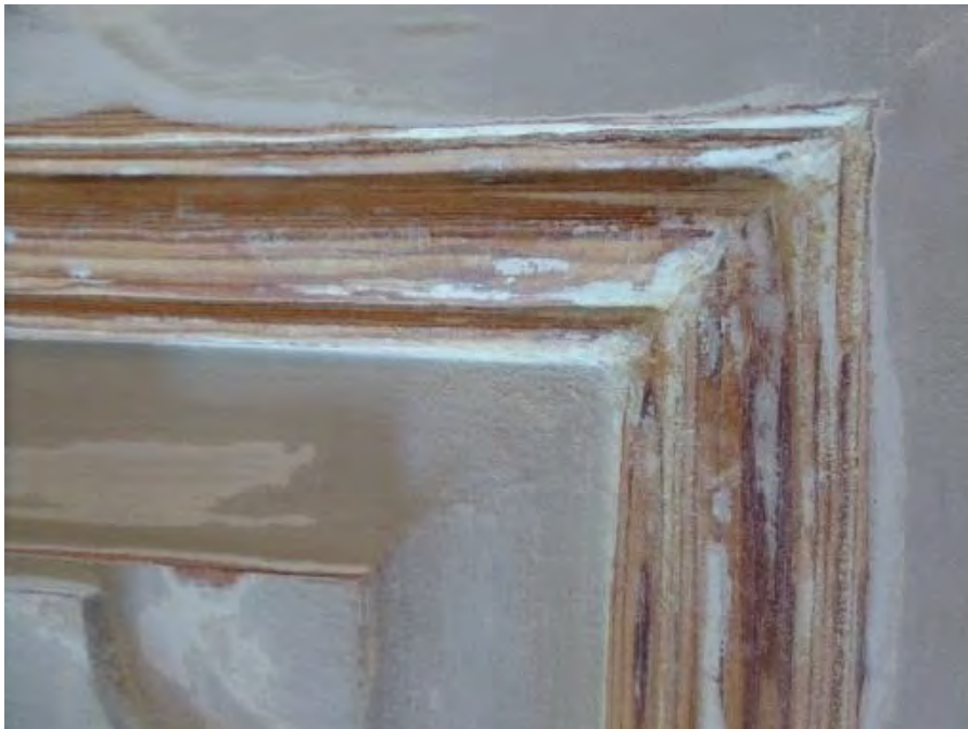
Figur 22. Framskrapad profil som tidigare var delvis igenmålad. Foto Helén Sjökvist.
