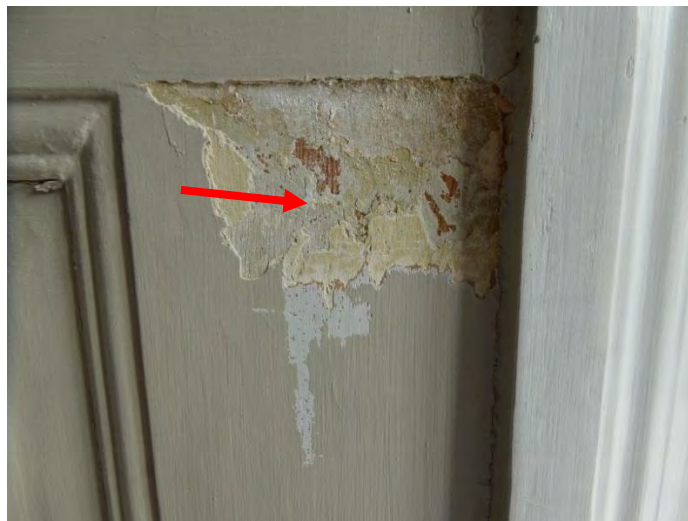
Figur 11. Framskrapat prov på östra panelen vid dörröppning. Äldre grå kulör vid pilen. Foto Helén Sjökvist.
