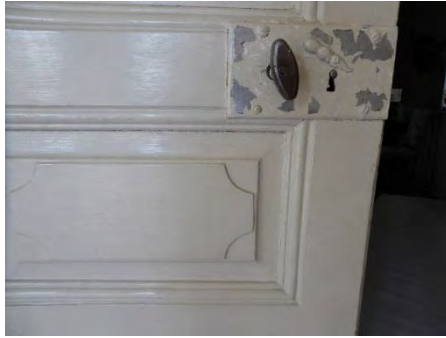
Figur 25. Dörrbladet mot trapphallen. Profilerna delvis igenmålade. Foto Helén Sjökvist. Figur 26. Arbete pågår. Rummet sett mot väster. Foto Helén Sjökvist.
