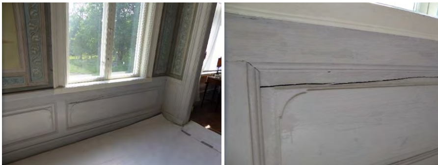
Figur 23. Södra panelen skrapad och grundmålad. Foto Helén Sjökvist.
