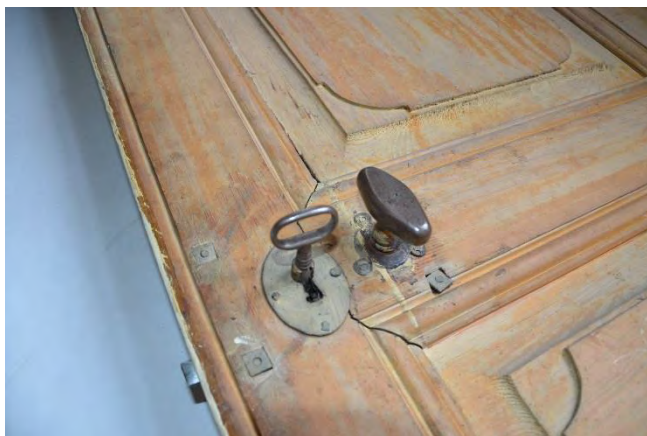
Figur 16. Baksidan till en av dörrarna till garderoben/tidigare handkammaren. Baksidan har endast en tunn fernissa eller ett mycket tunt bemålat ytskikt som gulnat kraftigt. Foto Helén Sjökvist.
