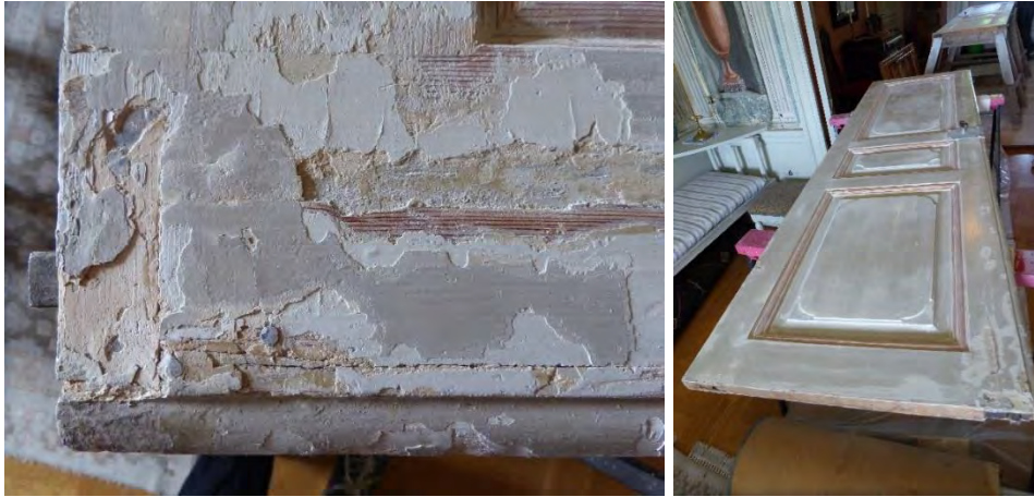
Figur 20. Pågående skrapning av dörrblad som vanligtvis sitter i öppningen mellan salen och serveringsrummet. Denna saknar underliggande bruna lager eftersom den är flyttad i ett senare skede. Foto Helén Sjökvist.
