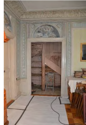
Figur 15. Salen sedd mot norr före åtgärder. Dörrarna till den gamla serveringsgången avbakade. Foto Helén Sjökvist.
