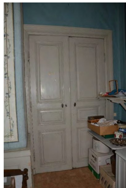
Figur 18. Detalj av färgbortfall. Dörrblad sedda från salongen. Foto Helén Sjökvist.
