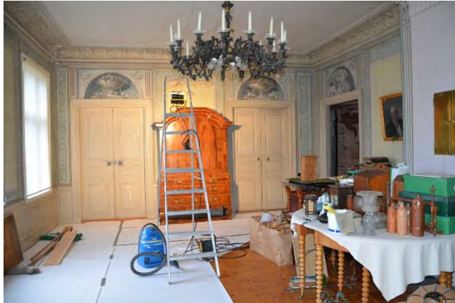
Figur 14. Salen sedd mot väster före åtgärder. Foto Helén Sjökvist.
