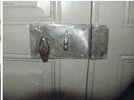
Figur 27. Dörrar mot serveringsrum till vänster och handkammare/garderob till höger efter åtgärder. Foto Helén Sjökvist. Figur 28. Låsen har lämnats obehandlade efter rengöring. Foto Helén Sjökvist.
