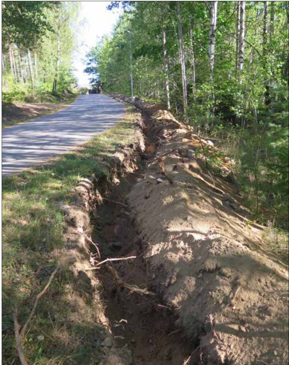
Figur 3. Södra delen av schaktet. Foto från SSV av Josefina Kennebjörk.
