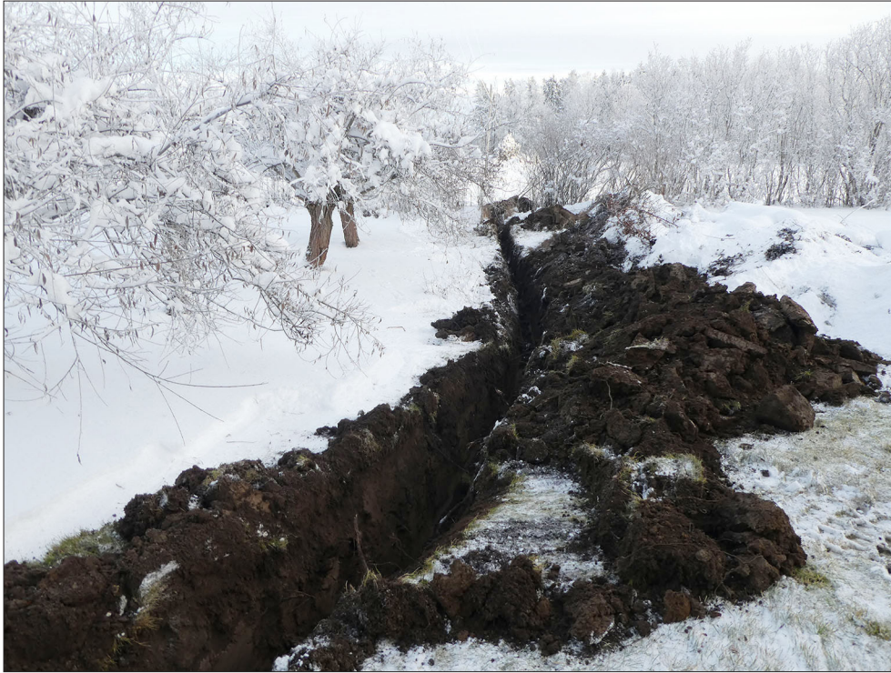
Figur 5. Schaktet sett från väster. Schaktet fortsatte någon meter på andra sidan av syrenbäcken. Foto Maud Emanuelsson.
