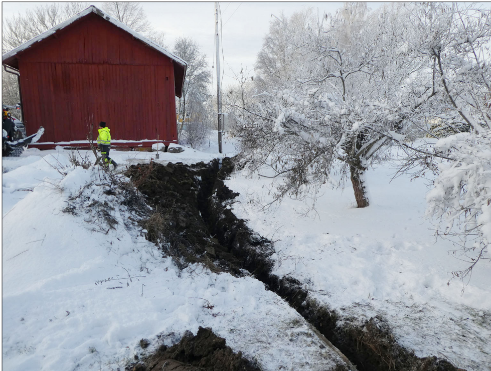
Figur 6. Schaktet sett från öster. Den kerosotbehandlade elstolpen vid schaktets slut kommer ersättas med en mindre stolpe med elskåp. Foto Maud Emanuelsson.
