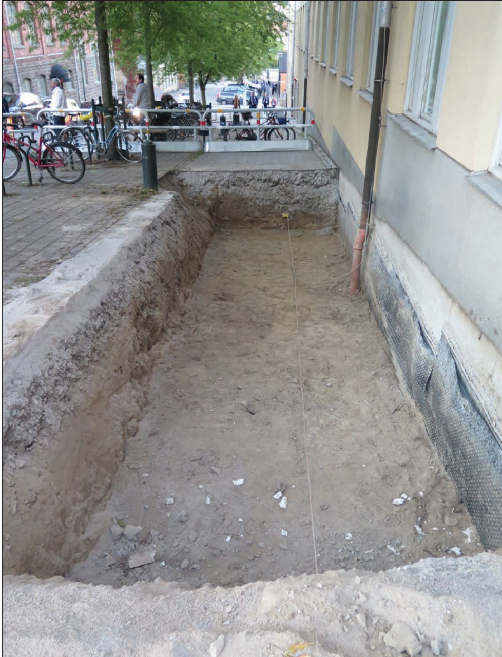
Figur 4. Den nord-sydligt orienterade delen av schaktet som grävdes intill husväggen i trottoaren på Korsgatan. Foto från söder av Josefina Kennebjörk.
