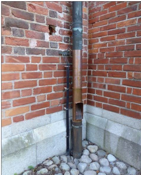
Figur 5. Ny lövsil. Kopparröret utbytt till delar.
