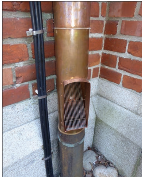
Figur 6. Ny konstruktion där löven silas bort medan vattnet fortsätter ner i röret.
