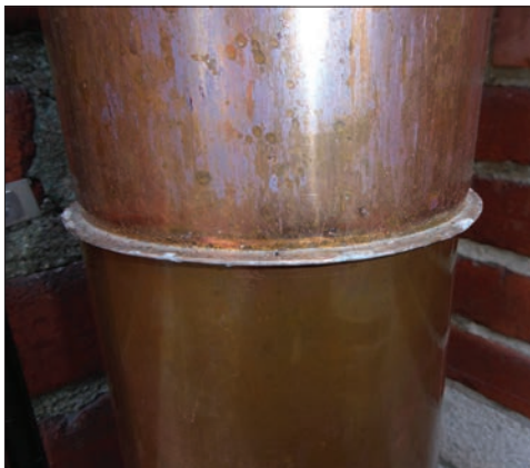
Figur 7. Falsade kopparrördelar.
