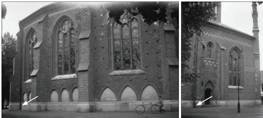
Figur 1. Bilder från 1929 visar att det även då fanns markbundna stuprör på kyrkan. Foto Berit Wallenberg, ATA.
