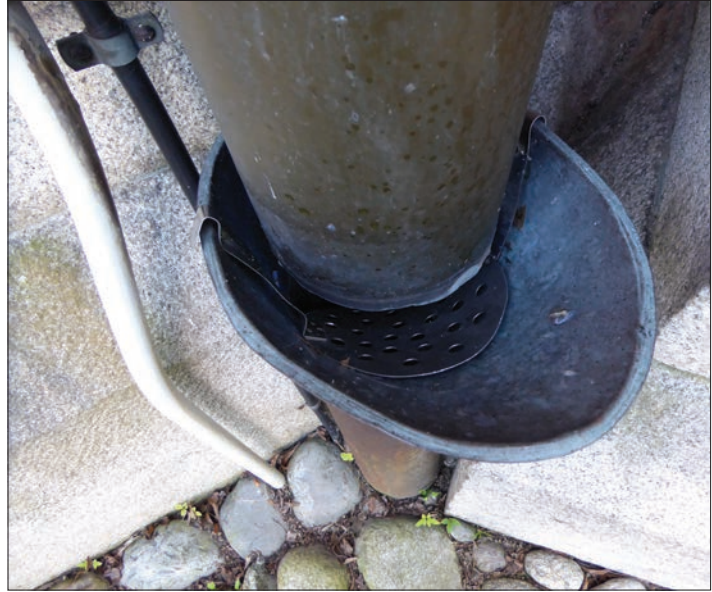
Figur 4. Närbild på lövuppsamlande trutt och sil i tidigare avvattningsystem.
