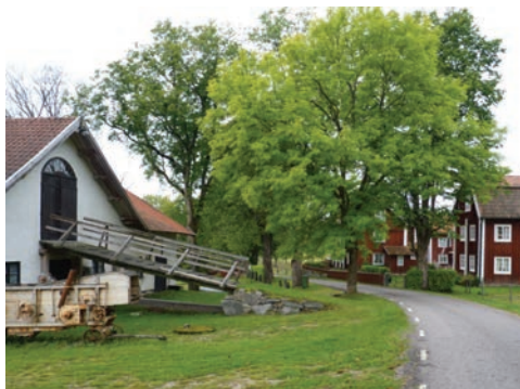
Figur 5. Skullbron sedd från öster innan åtgärd. Foto Tobias Mårud.
