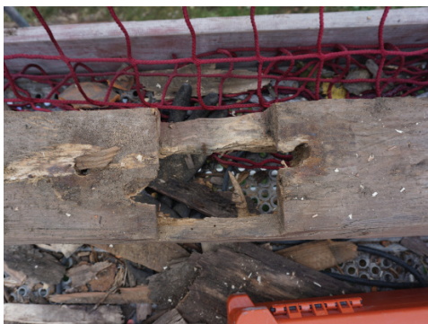
Figur 23. Del av äldre hammarband där man kan se raket igenom virket vid uttag för sparre. Foto Tobias Mårud.
