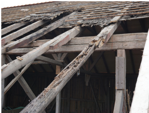
Figur 21. Exempel på sparre med rötskadad översida. Foto Tobias Mårud.
