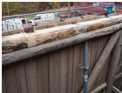
Figur 23. Del av äldre hammarband där man kan se raket igenom virket vid uttag för sparre. Foto Tobias Mårud.
