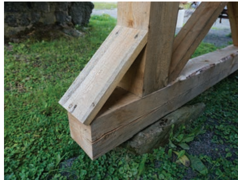
Figur 11. Bocken är försedd med skyddande bleck på de övre utskjutande ändarna. Foto Tobias Mårud.
