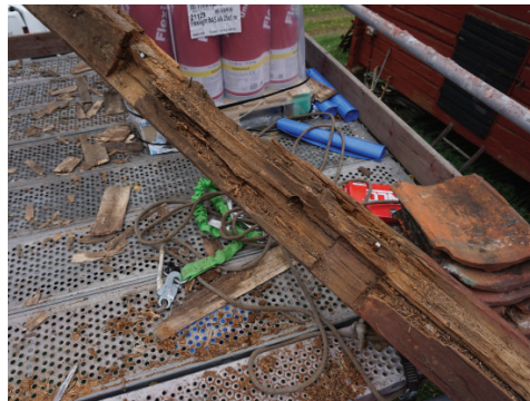
Figur 21. Exempel på sparre med rötskadad översida. Foto Tobias Mårud.
