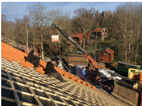
Figur 30. Läggnig av taktegel. Foto Erik Brate.
