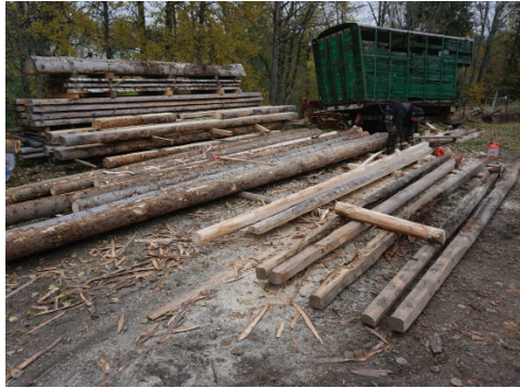
Figur 25. Arbetsplats för nytillverkning av sparrar med mera. Foto Tobias Mårud.
