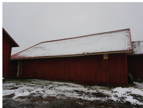
Figur 18. Östra takfallet efter åtgärd, tyvärr snötäckt. Foto Tobias Mårud.
