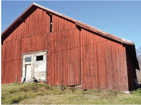
Figur 19. Södra gaveln innan åtgärd. Foto Tobias Mårud.
