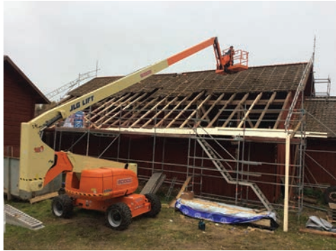
Figur 27. Mobilkran användes för att byta sparrarna på plats. Foto Erik Brate.
