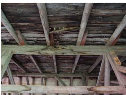
Figur 32. Rötskada i undertak och ursprungligt hammarband. Foto Tobias Mårud.
