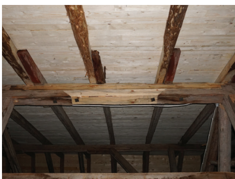
Figur 32. Rötskada i undertak och ursprungligt hammarband. Foto Tobias Mårud.
