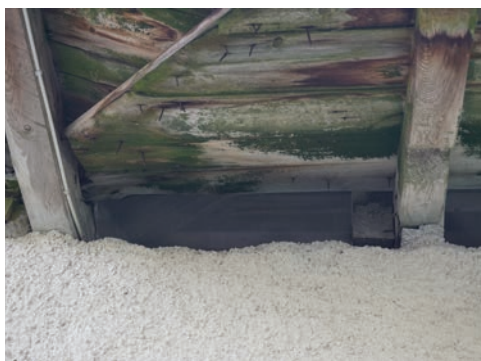
Figur 15. Nätning av takfot sedd utifrån. Foto Tobias Mårud.
