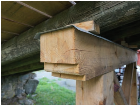
Figur 11. Bocken är försedd med skyddande bleck på de övre utskjutande ändarna. Foto Tobias Mårud.
