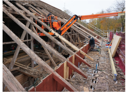
Figur 25. Arbetsplats för nytillverkning av sparrar med mera. Foto Tobias Mårud.
