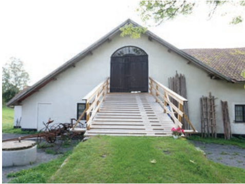
Figur 9. Ny trallbeläggning och nya räcken. Foto Tobias Mårud.
