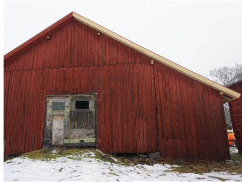
Figur 20. Södra gaveln efter åtgärd. Observera längden på åsarnas ändar. Foto Tobias Mårud.
