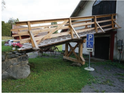
Figur 10. Skullbron efter åtgärd, med ny trall, räcke och bockrygg. Foto Tobias Mårud.
