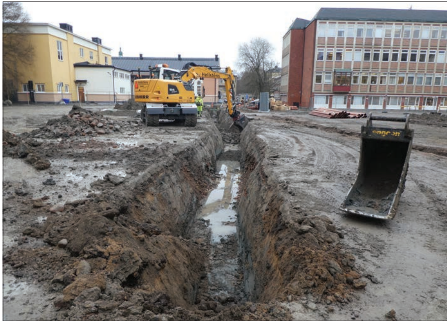
Figur 5. Centralt schakt för VA. Foto från söder av Maud Emanuelsson.
