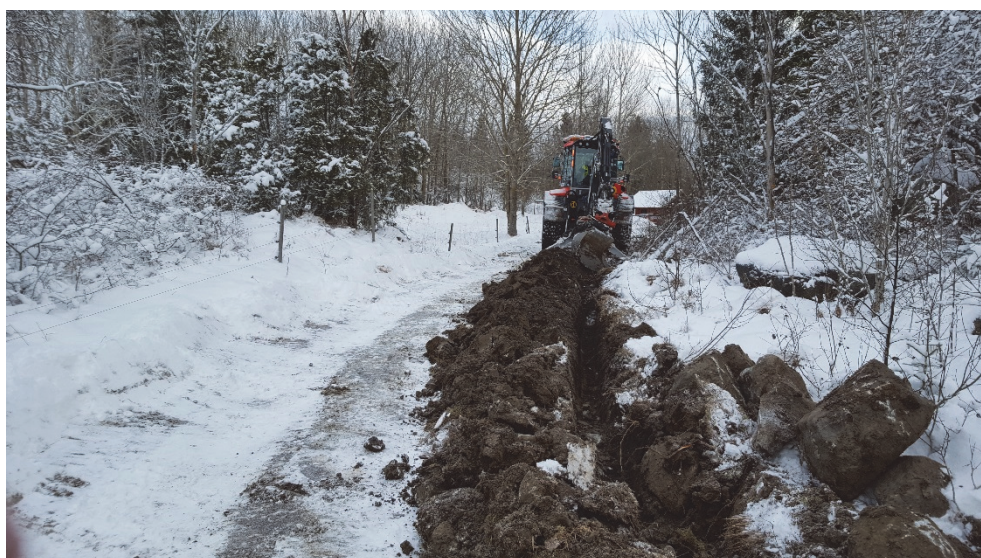
Figur 2. Schaktning i den stenigaste marken. Skärvtenshögen Gryta 135:1 ligger vid buskarna och enarna till vänster i bild. Foto från sydväst av Jan Åblström.
