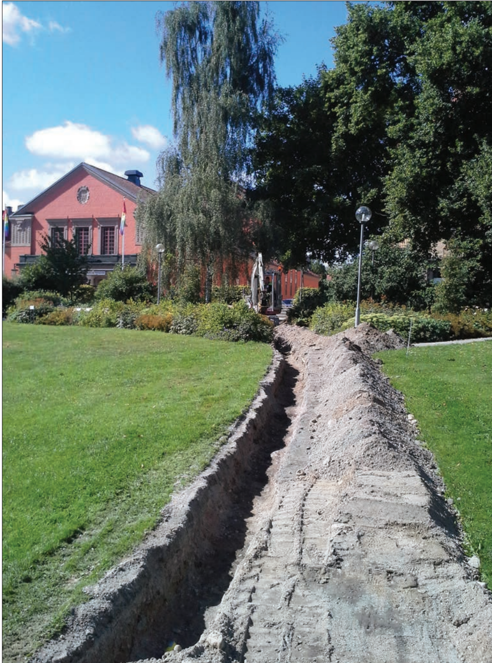
Figur 19. Schakt för elkabel. Foto från öster av Jonas Ros.
