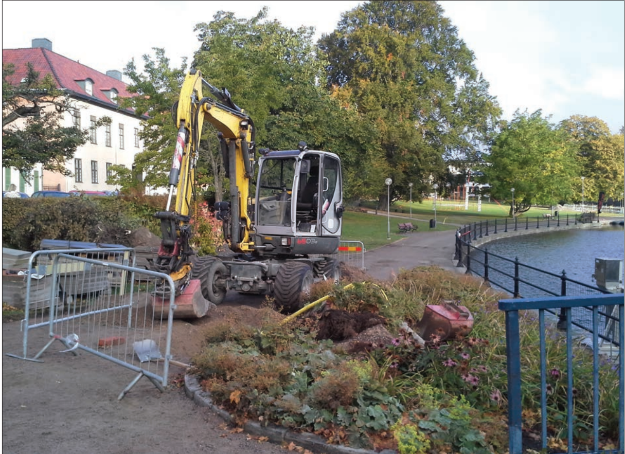
Figur 2. Stadsparken sedd från söder. Schaktning för ny elkabel har just påbörjats. Foto Jonas Ros.
