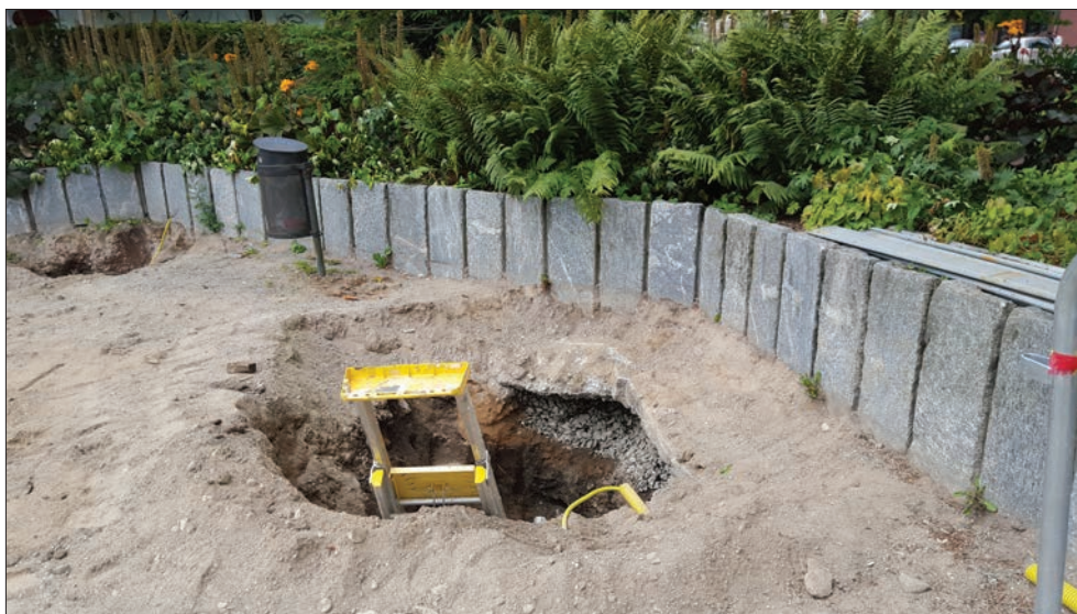
Figur 7. Schakt 1 gjordes för en ny belysningsstolpe i norra delen av Stadsparken. Foto från öster av Maud Emanuelsson.
