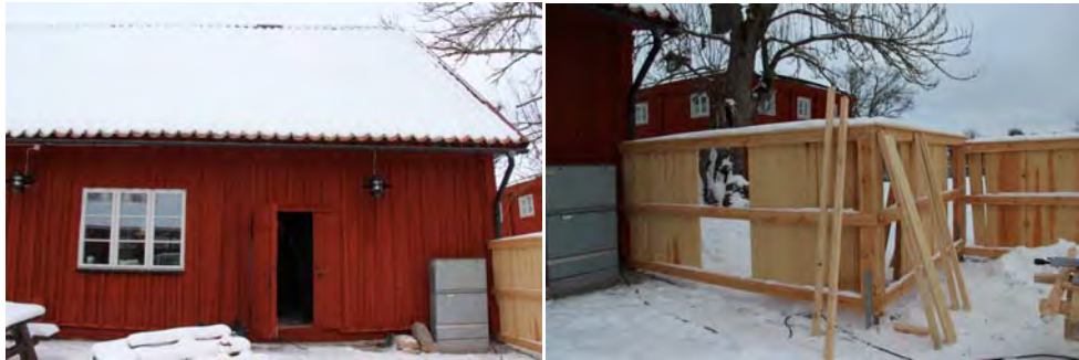
Figur 32. Befintlig ekonomibygnad i norra delen har försetts med ett nytt fönster utan fönsterfoder. Foto. Helén Sjökvist.
