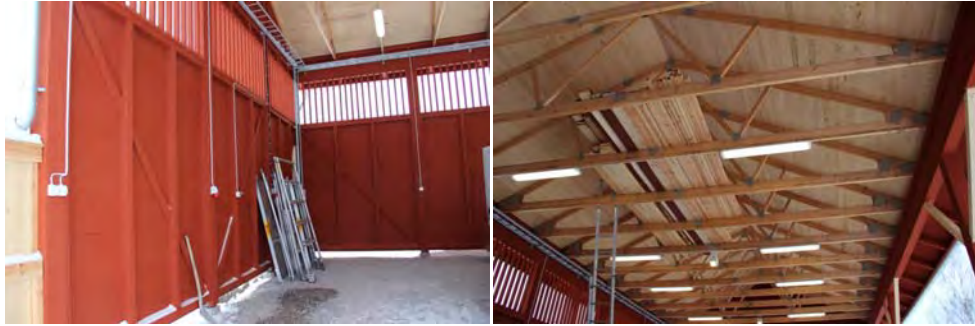
Figur 30. Insidan av regelstommen på den nya ekonomibygnaden. Foto. Helén Sjökvist.
