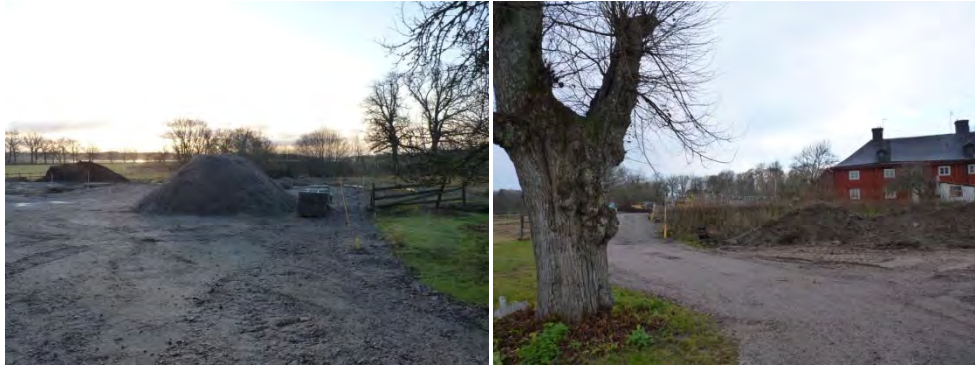
Figur 17. Yta för nybyggnad. Foto. Helén Sjökvist.
