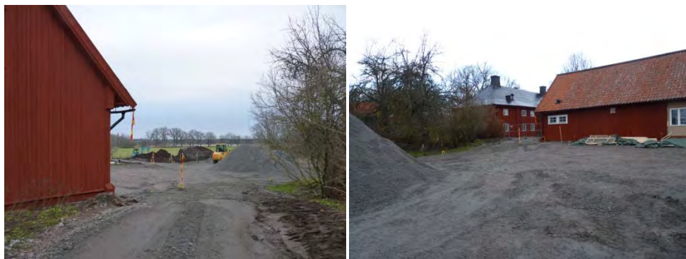
Figur 15. Aktuellt område sett mot sydöst under pågående markarbeten. Foto. Helén Sjökvist.
