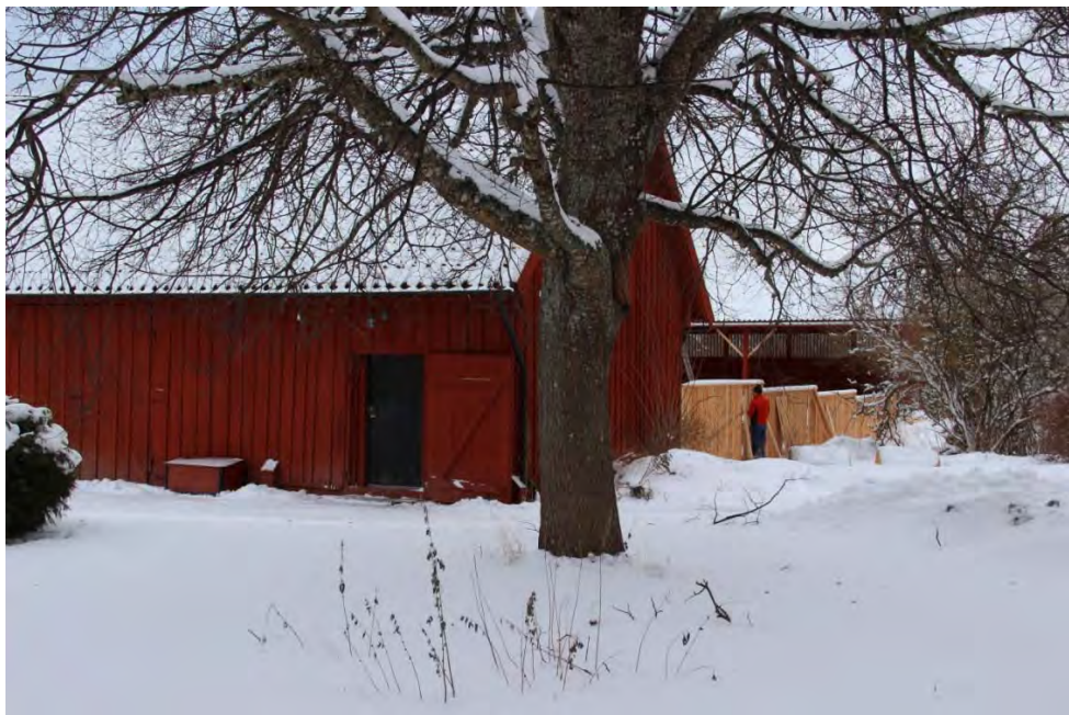
Figur 21. Ekonomibygnaden i förgrunden med den plankomgärdade ekonomigården i bakgrunden. Sett mot söder. Foto. Helén Sjökvist.
