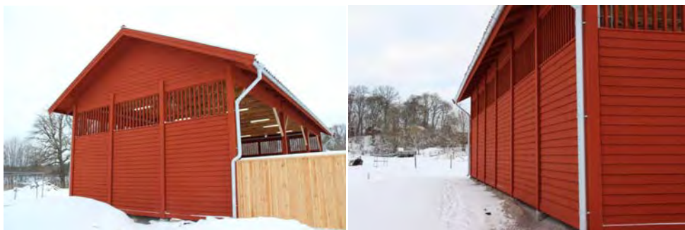
Figur 24. Den nya ekonomibyggnaadens östra fasad med anslutande plank och specialanpassat stuprör. Foto. Helén Sjökvist.
