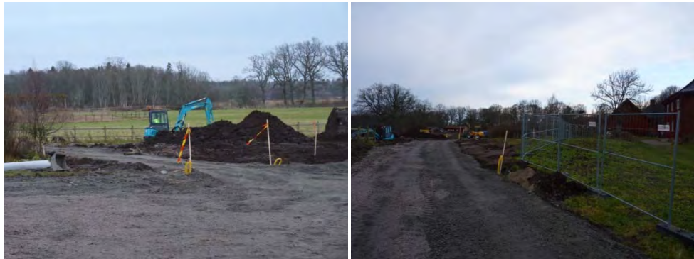
Figur 19. Ny anslutningsväg. Foto. Helén Sjökvist.
