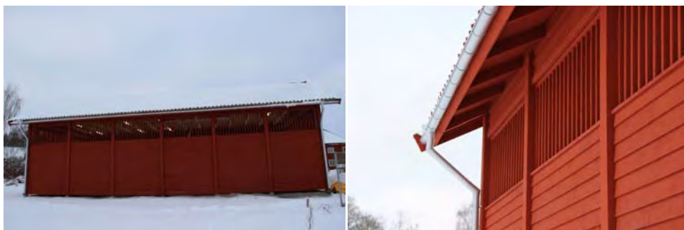
Figur 26. Södra fasaden på den nya ekonomibyggnaaden. Foto. Helén Sjökvist.
