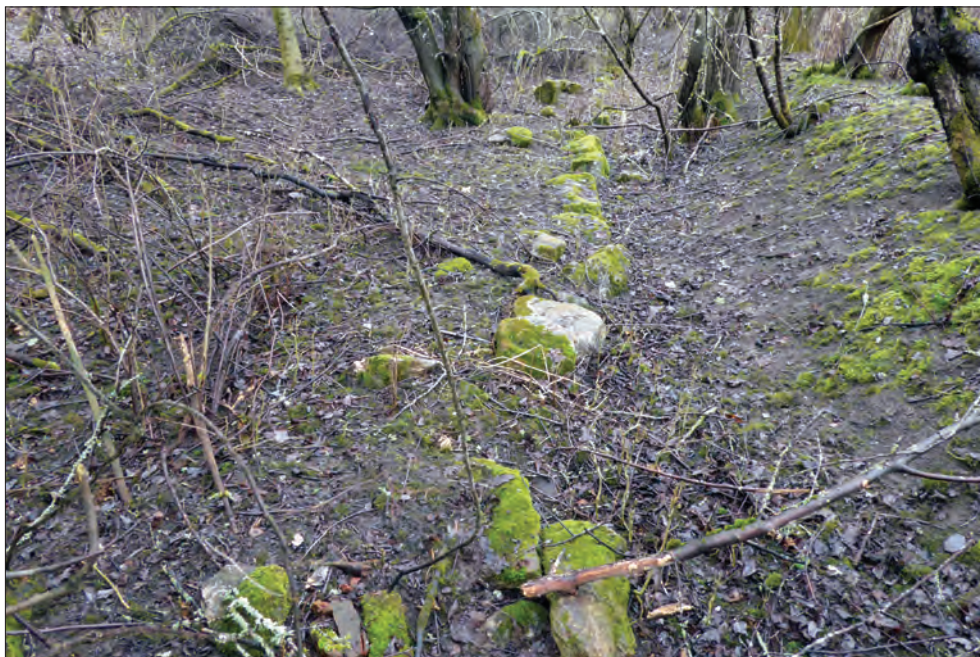
Figur 10. En av de två synliga grunderna (objekt 2) till torkladorna som ligger i skogen nordöst om Botkyrka 379:1. Foto från sydväst av Ellinor Sabel.
