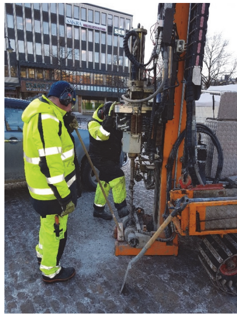
Figur 5. Närbild som visar borren i borrbandvagnen. Foto från sydväst av Jonas Ros.
