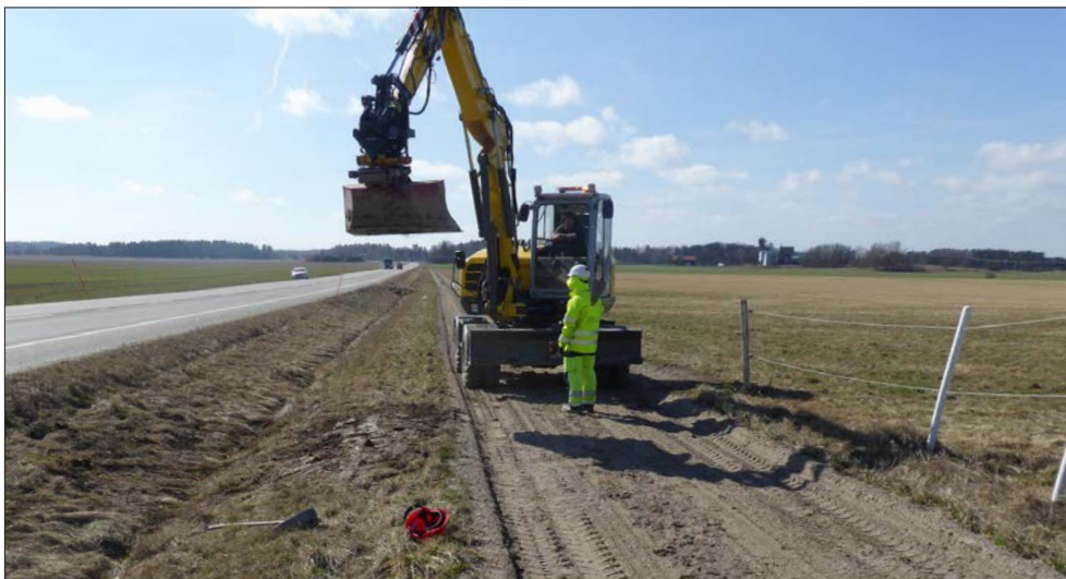
Figur 9. Schaktning inom objekt 6. Foto från norr av Reidar Magnusson.
