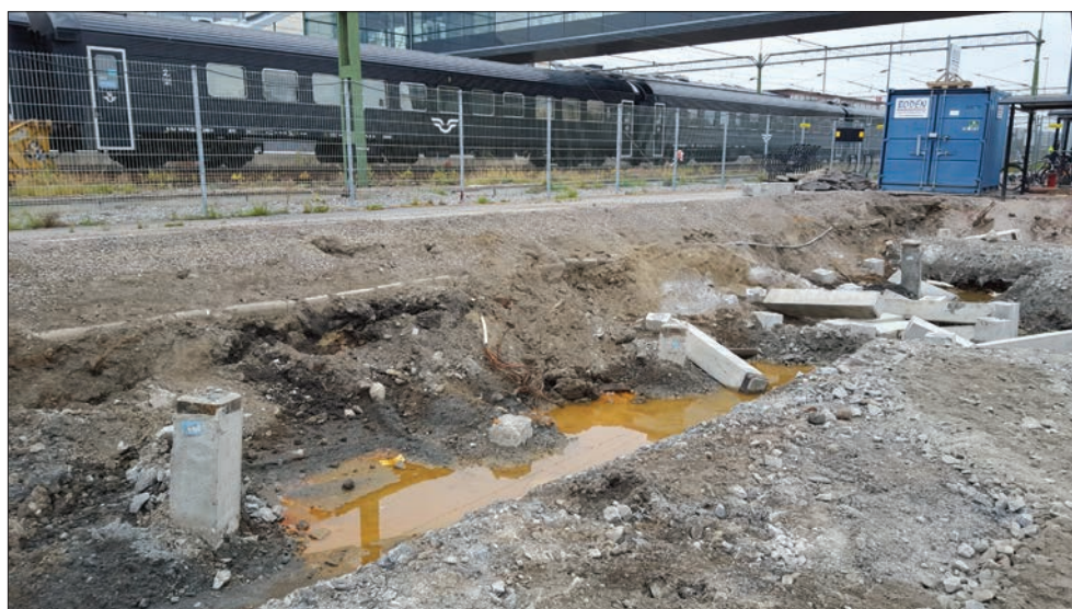
Figur 3. Schakt A. Foto från sydväst av Jan Äblström (KM16135_01).
