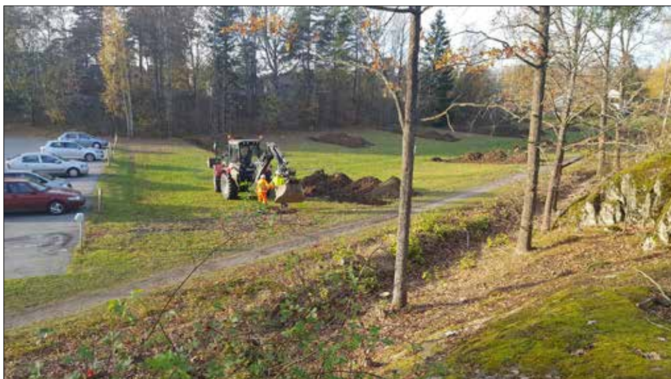
Figur 5. Arbetsbild efter att sökschaktningen i gräsmattan var klar. Foto från östsydost.
