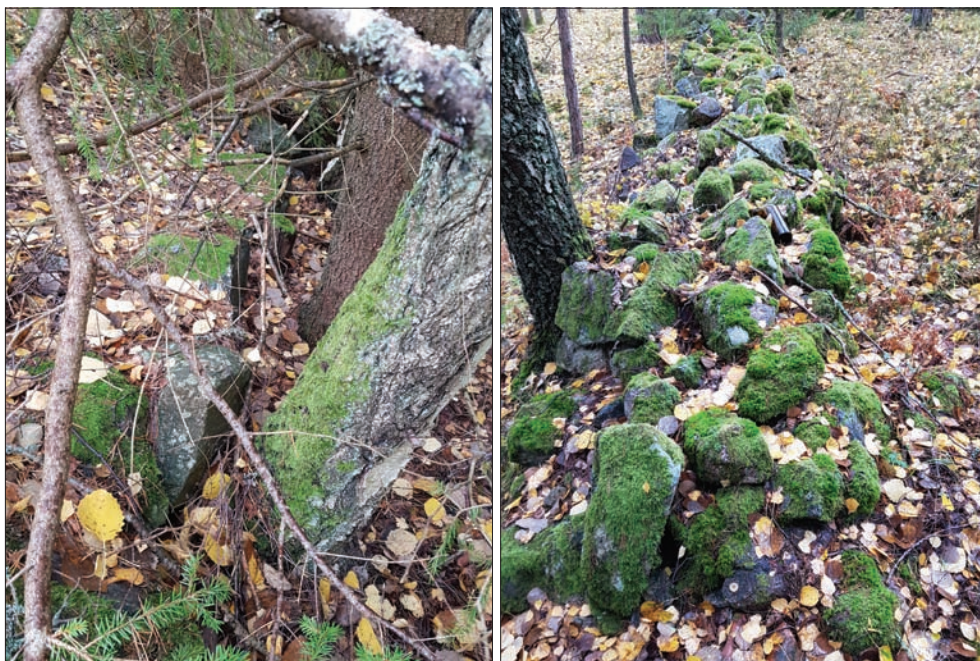
Figur 25–26. Den södra kanten av husgrunden inom objekt 17 (t.v.) och stenmuren inom objekt 17 (t.h.). Foto från öster respektive väster.
