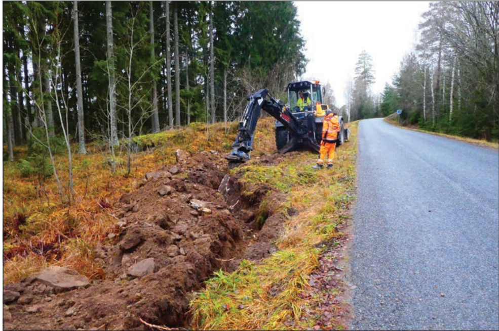
Figur 4. På ett par ställen fick schaktet grävas runt stora stenblock. Foto från östsydöst av Jenny Holm.
