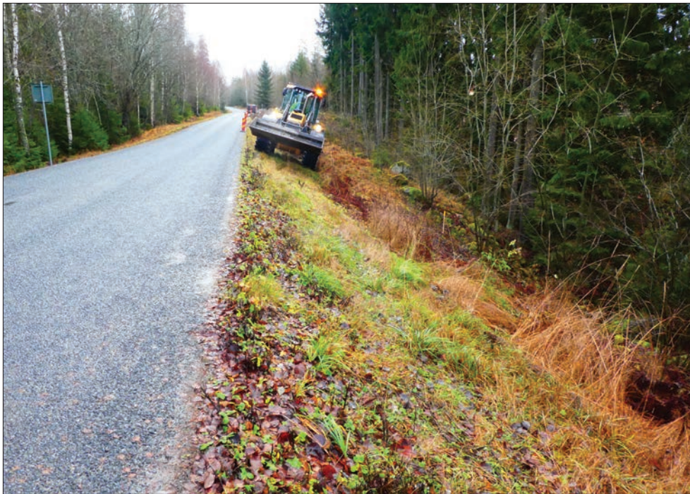
Figur 5. Marken sluttade tvärt ner åt söder och var uppfylld för vägen så att schaktet till stor del kom att grävas i påförda massor. Foto från västnordväst av Jenny Holm.
