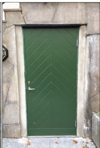
Figur 36 (nedre, höger). Ny dörr i slutligt läge. Sidoshusets betongglas har försvunnit och dörren centrerats. Foto Mathias Nordin.
