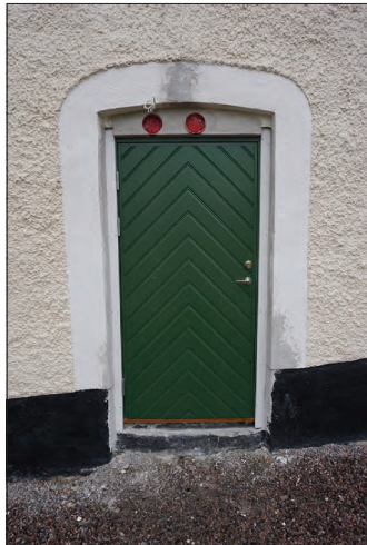
Figur 18 (vänster). Den nya dörrens utsida, tillverkad med den föregående som förlaga.
