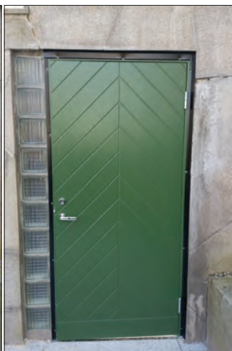
Figur 36 (nedre, höger). Ny dörr i slutligt läge. Sidoshusets betongglas har försvunnit och dörren centrerats. Foto Mathias Nordin.
