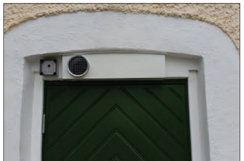
Figur 21 (övre, vänster). De nya ventilationskanalernas öppningar monterades i ytterdörrens överstycke.
