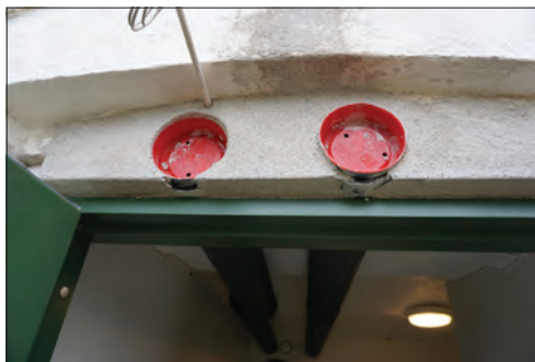
Figur 20 (höger). Inre rummets östra vägg efter åtgärd.
