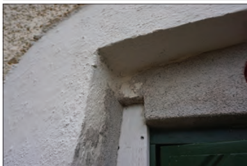
Figur 21 (övre, vänster). De nya ventilationskanalernas öppningar monterades i ytterdörrens överstycke.
