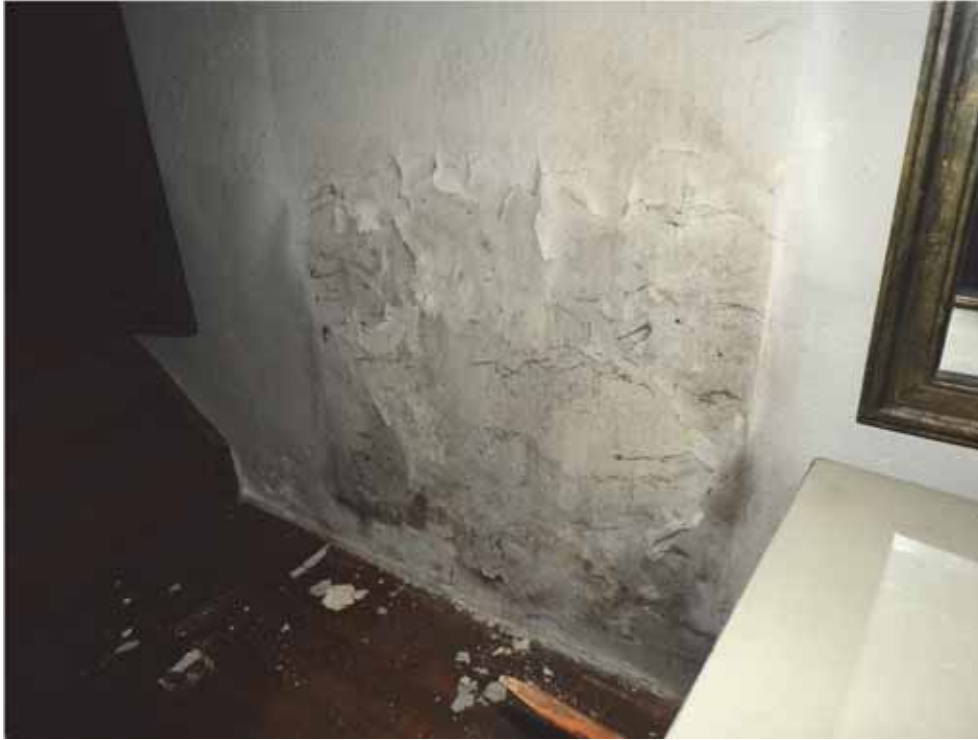
Figur 55. Bakom skåpen i sakristian fanns stora problem med färgsläpp.
