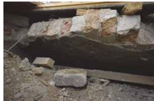
Figur 15. I sakristians öppning syns resterna av en valvslagning tillhörande ytterligare ett varmluftsschakt, eller kanal, i övrigt utfyllnadsmaterial och en sekundär valvslagning eller täckning av tidigare upptaget hål i taket till värmecentralen under sakristian. Foto: Tobias Mårud.
