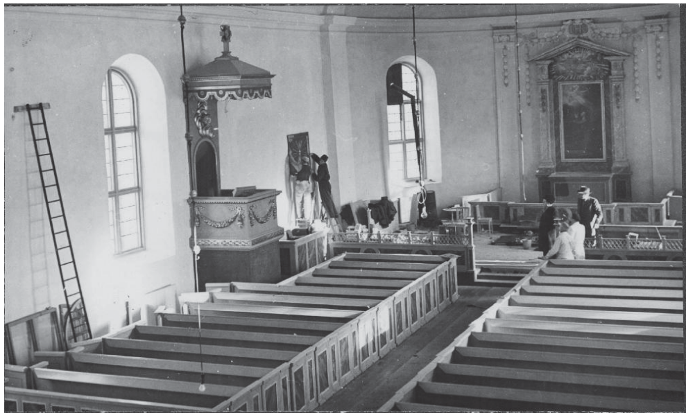
Figur 7. Vid renoveringen 1949–1950 återskapades de slutna bänkkvarteren. Foto: Torsten Hjelm. ATA.
