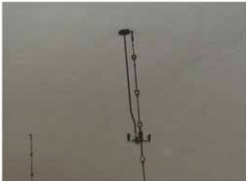
Figur 73. Spotlights monterade i pendeln före åtgärder.
