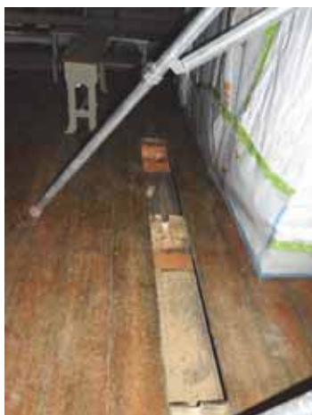
Figur 44. Upptaget golv på läktaren för att rymma elinstallationer.
