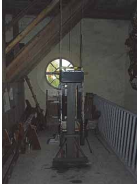
Figur 89. Ringverket efter åtgärder.
