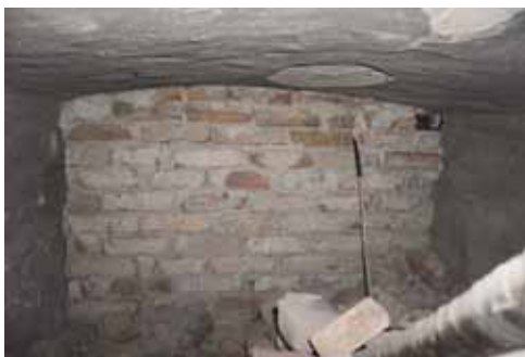
Figur 64. Del av det tidigare kalorifersystemet som utnyttjades för dragning av rör för den vattenburna värmen från källaren till långhuset.
