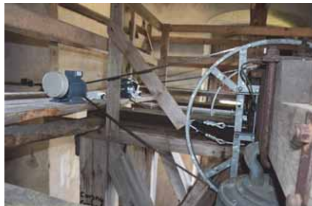
Figur 93. Motorer till elektrisk klockringning. Foto: Svensk Klimatstyrning.
