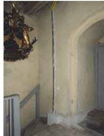
Figur 42. Passagen mellan torn och läktare. En slang för eldragningar har lagts in i väggen för att slippa göra synliga installationer.
