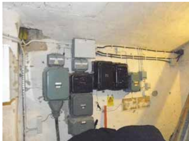
Figur 61. Tidigare befintlig elutrustning i källare samt befintlig håltagning i taket.
