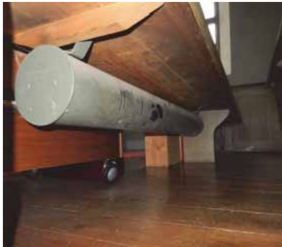
Figur 26. Äldre bänkvärmare.
