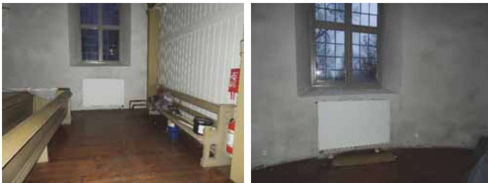
Figur 28. Ny konvektor i långhusets nordvästra del. Rören går in mot läktarunderbyggnaden. Då fotot togs var rören ännu inte inmålade i bakgrundskulör.
