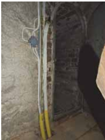
Figur 48. Befintliga kabelvägar mellan vapenhus och vind utnyttjades för nydragning av el.
