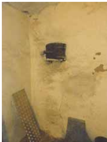
Figur 60. Lucka för äldre kaloriförsyning.
