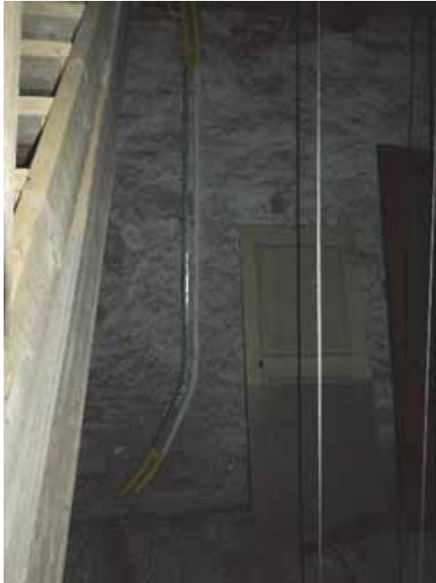
Figur 46. Påbörjad elinstallation i tornet.
