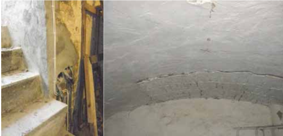
Figur 62. Äldre håltagningar från sakristians källare och ut vid trappa. Figur 63. Igenmurat parti i taket av källarens inre rum.
