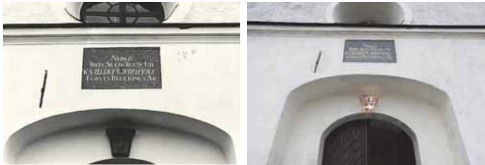
Figur 51. Tidigare armatur över porten. Foto: K. Kartaschew 1972. ATA. Figur 52. Ny armatur över porten.
