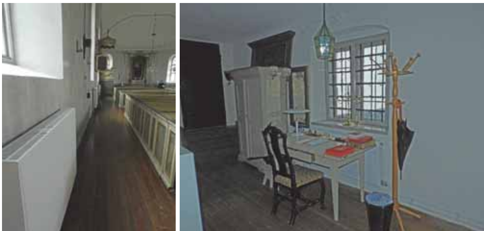
Figur 32. Nya konvektorer utefter östra långsidan.
