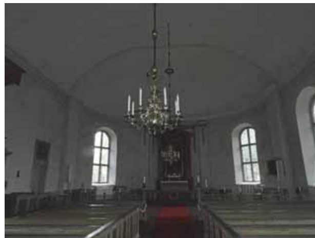
Figur 76. Nya runda spotlightkransar monterade i pendeln.
