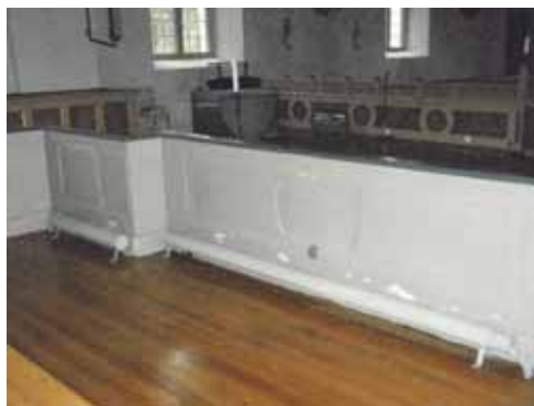
Figur 24. Äldre radiatorer innanför altarringen.
