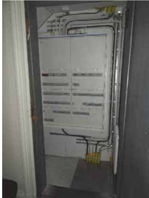
Figur 37. Den äldre elvärmecentralen under predikstolen fick vara kvar av antikvariska skäl, men kopplades ur.
