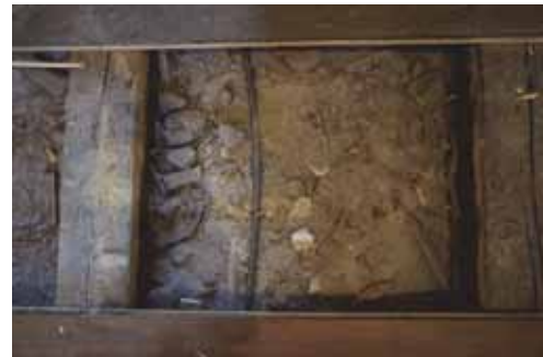
Figur 13. Fyllning i golvbjälklag, mittgången, EDIL-kabel och bit av målad puts. Foto: Tobias Mårud.
