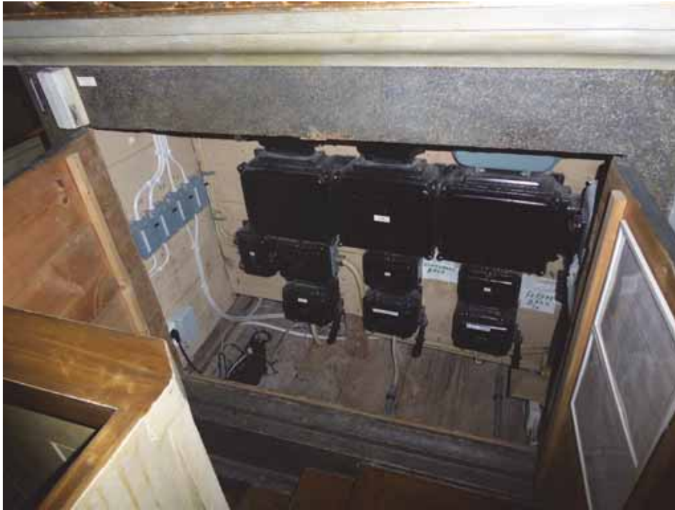
Figur 37. Den äldre elvärmecentralen under predikstolen fick vara kvar av antikvariska skäl, men kopplades ur.
