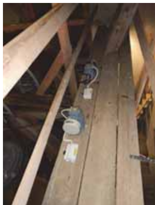
Figur 93. Motorer till elektrisk klockringning. Foto: Svensk Klimatstyrning.
