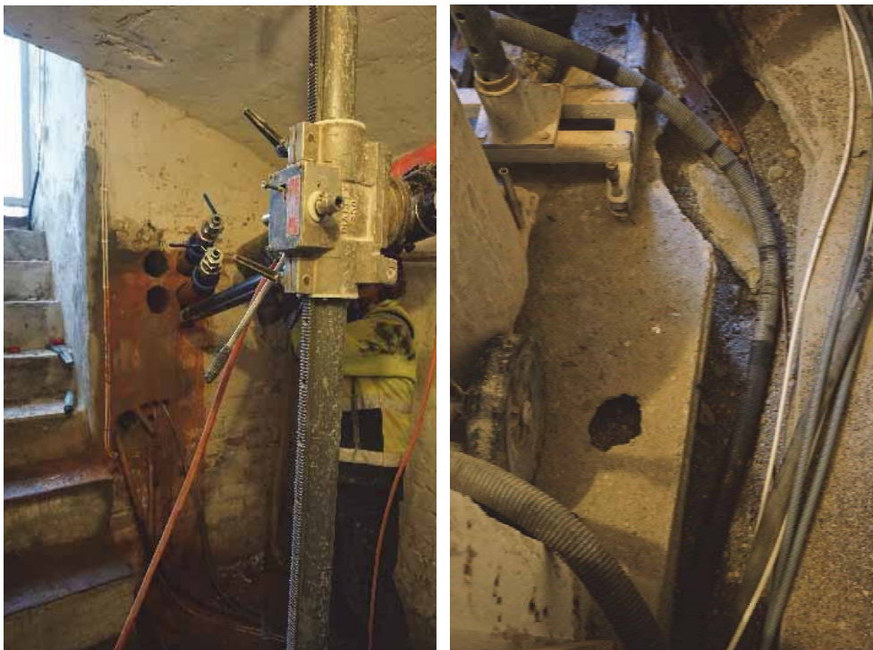
Figur 65. Nya håltagningar vid trappa för inkommande rör för bergvärme. Figur 66. Uppbilat spår i källargolv.
