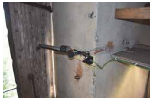
Figur 69. Elektrisk lucköppning installerad på ljudluckorna. Foto: Svensk Klimatstyrning.
