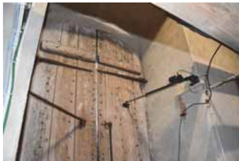
Figur 69. Elektrisk lucköppning installerad på ljudluckorna. Foto: Svensk Klimatstyrning.
