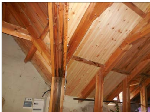
Lagningar i undertaket synliga på vinden.
