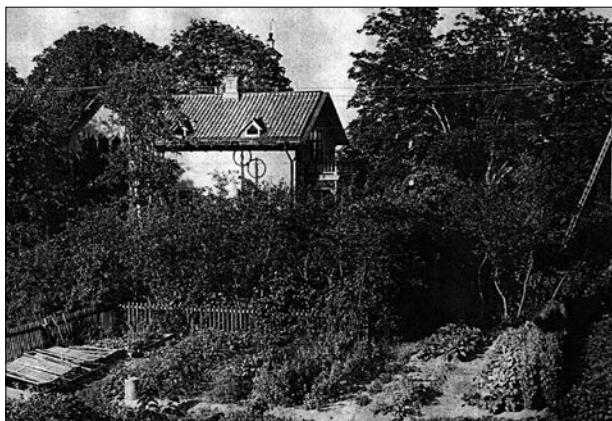
Byggnaden från sydväst. Stuprör är monterade. Bilden är troligtvis från tiden omkring sekelskiftet 1900. Fotot är tillhandahållet av Leif Berggren via e-post 2017-04-25.
