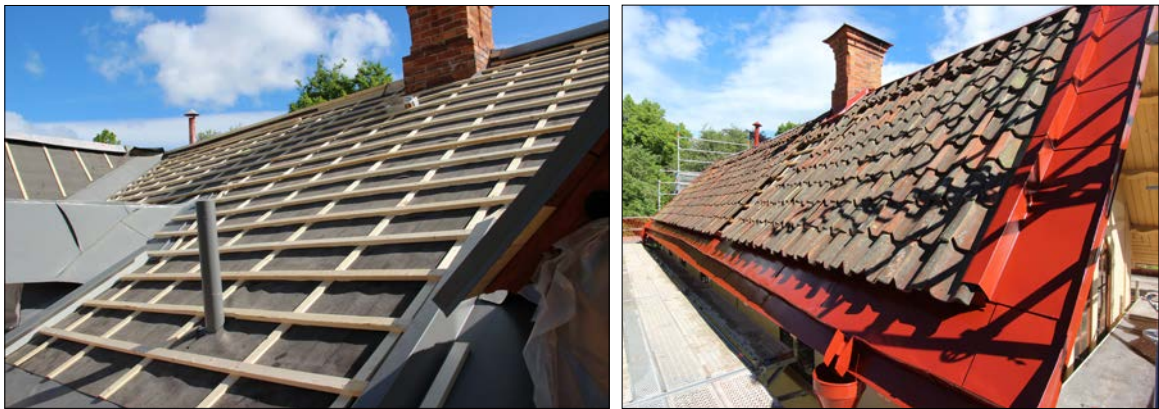
Foton från takomläggningen.
