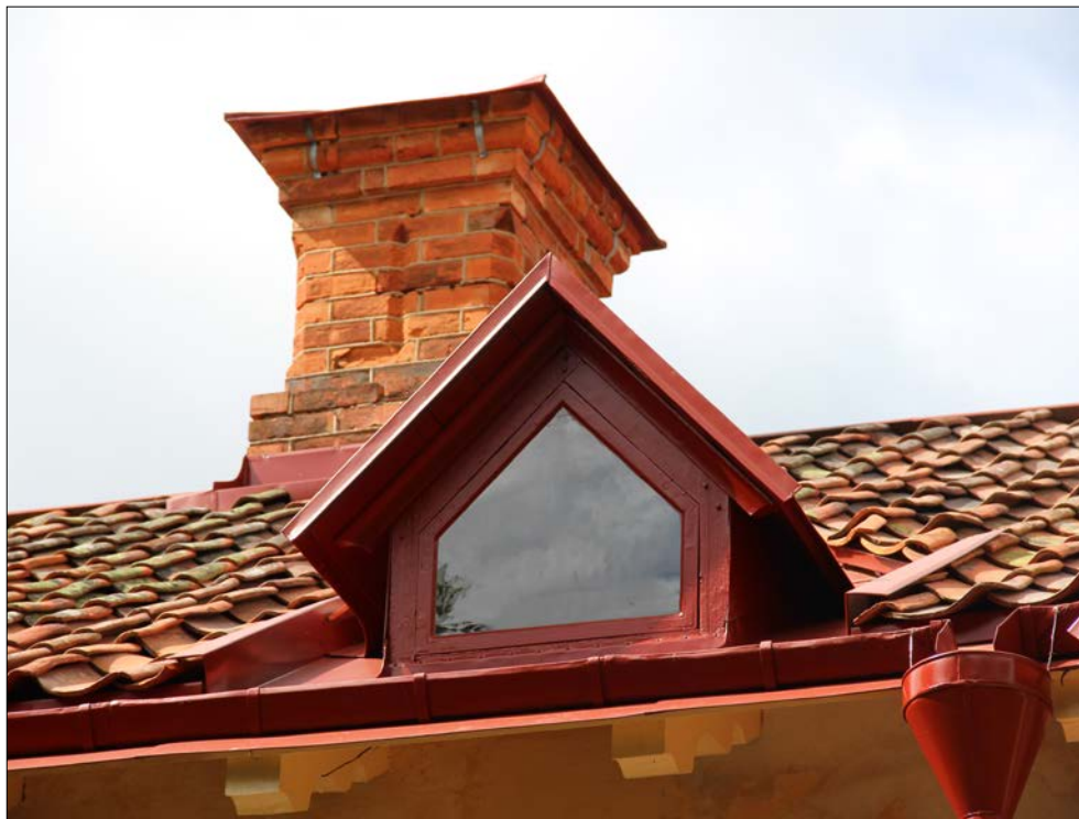
Rötskador fanns i takfönstrens virke. De renoverades och rötskadade delar böts ut. Fönsterrvirket målades med samma färg som användes till plåtmålningen, linoljafärg från Wibo i engelsket rött. Fotot visar fönster mot nordöst efter åtgärder.
