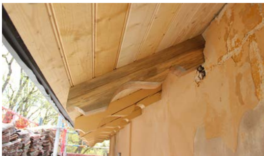
Taktass som bytts ut och parti med ny pärlspont i takutsprånget.
