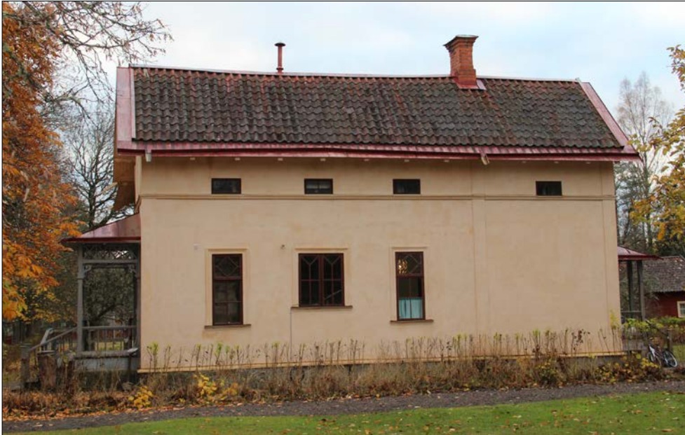
Ingenjörsbostaden sedd från nordväst före åtgärd.
