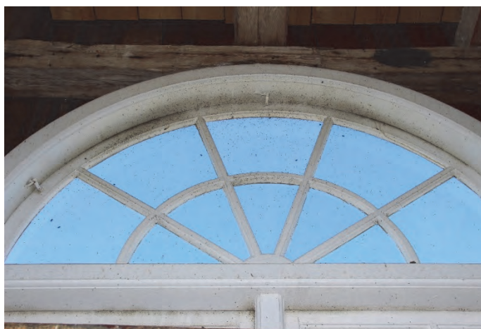
Figur 44. Fönster före åtgärder. Foto: Helén Sjökvist.
