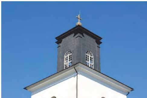
Figur 38. Lanterninen sedd från sydöst. Hängränna finns endast på tre sidor. Östra sidan som syns till höger saknar hängränna. Foto: Helén Sjökvist.
