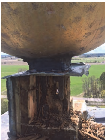
Figur 6. Korsstocken var allvarligt rötskadad. Foto: Lars Pernball.
