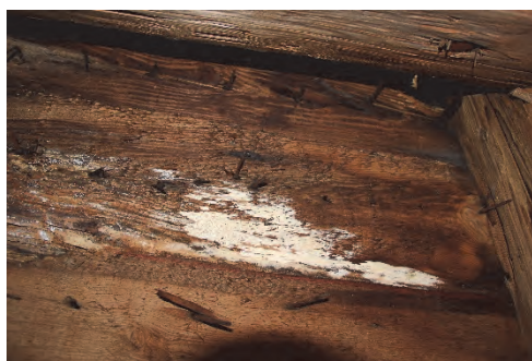
Figur 25. Svamp vid läckageställe. Foto: Helén Sjökvist.
