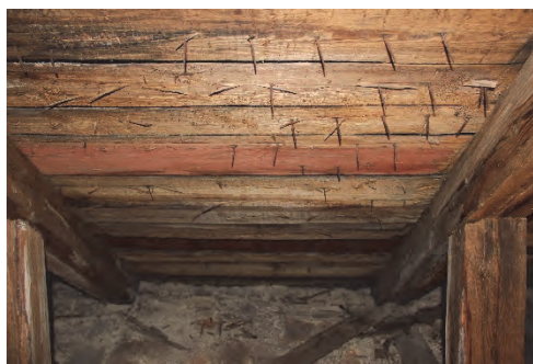
Figur 27. Äldre spikar som går genom panelen. Foto: Helén Sjökvist.
