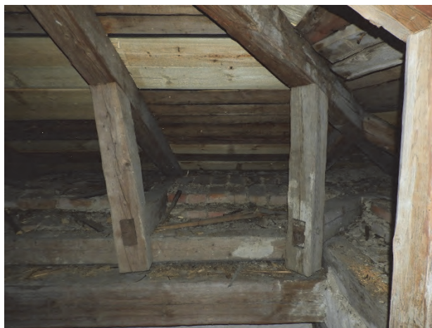
Figur 33. Utbytt bjälke och undertak. Foto: Helén Sjökvist.
