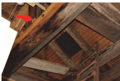
Figur 23. Korsstocken markerad med en pil. Den var intappad i den mörka stocken centralt i bilden, vilken hade rötskador. Foto: Helén Sjökvist.
