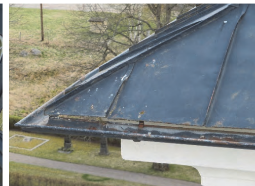
Figur 16. Lanternin och tornkrans före åtgärder. Till vänster, på tornkransens östra sida, syns några sedan tidigare utbytta plåtar. Foto: Lars Pernhall.
