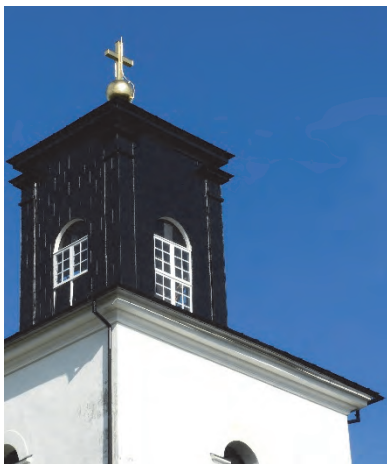
Figur 40. Hängränna uppsatt på östra sidan av tornet. Foto: Helén Sjökvist.
