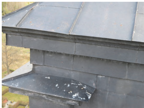
Figur 14. Lanternin, avtäckning av hörnpilaster före åtgärder. Foto: Lars Pernhall.
