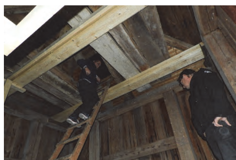
Figur 23. Korsstocken markerad med en pil. Den var intappad i den mörka stocken centralt i bilden, vilken hade rötskador. Foto: Helén Sjökvist.
