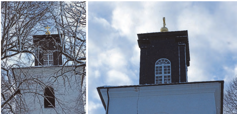
Figur 48. Västra lanterninfönstret efter åtgärder. Foto: Helén Sjökvist.
