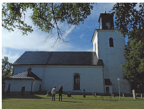
Figur 52. Norra takfallet efter åtgärder. Foto: Helén Sjökvist.
