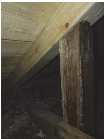
Figur 33. Utbytt bjälke och undertak. Foto: Helén Sjökvist.
