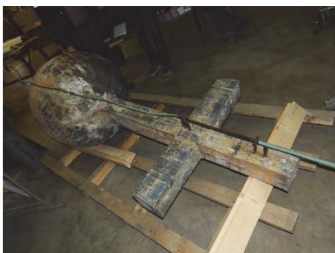
Figur 11. Åskeledarinfästning i korset med grova fästen. Foto: Helén Sjökvist.
