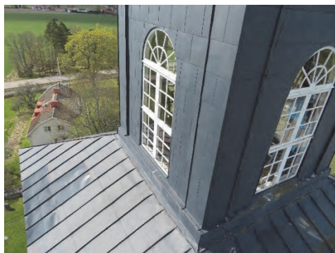
Figur 16. Lanternin och tornkrans före åtgärder. Till vänster, på tornkransens östra sida, syns några sedan tidigare utbytta plåtar. Foto: Lars Pernhall.
