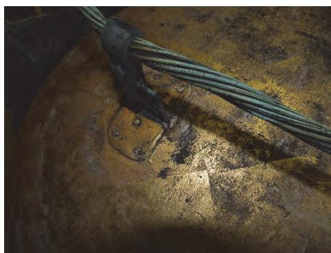
Figur 11. Åskeledarinfästning i korset med grova fästen. Foto: Helén Sjökvist.
