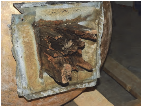
Figur 8. Röttskadad korsstock samt lagning med galvaniserad plåt som falsats samman med kopparplåten. Foto: Helén Sjökvist.
