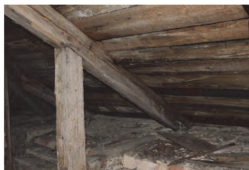
Figur 24. Två bjälkar måste bytas ut i lanterninens övre konstruktion jämför figur 23. Foto: Helén Sjökvist.
