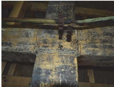
Figur 8. Röttskadad korsstock samt lagning med galvaniserad plåt som falsats samman med kopparplåten. Foto: Helén Sjökvist.
