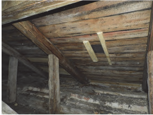
Figur 35. Bevarat undertak. Foto: Helén Sjökvist.
