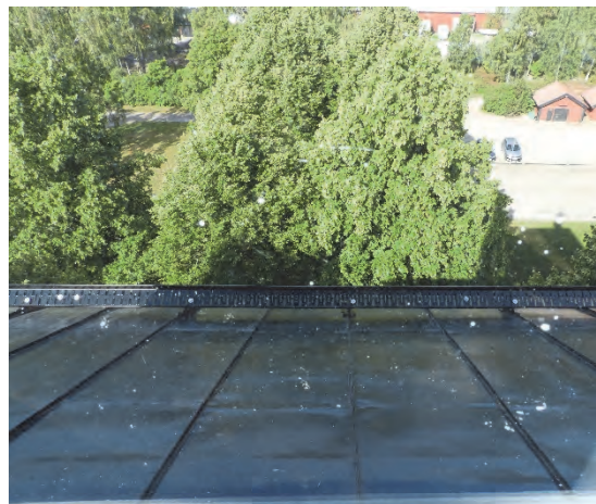
Figur 40. Hängränna uppsatt på östra sidan av tornet. Foto: Helén Sjökvist.
