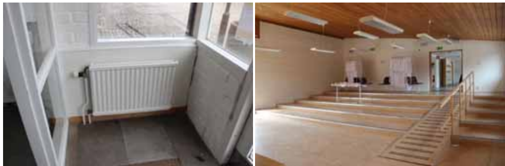
Figur 115. KM13026 Tomaskyrkan_0853 Vindfång 165 före åtgärd. Vägparti bakom radiator är gipsat, övriga delar av ytterväggar är målade tegelväggar.
