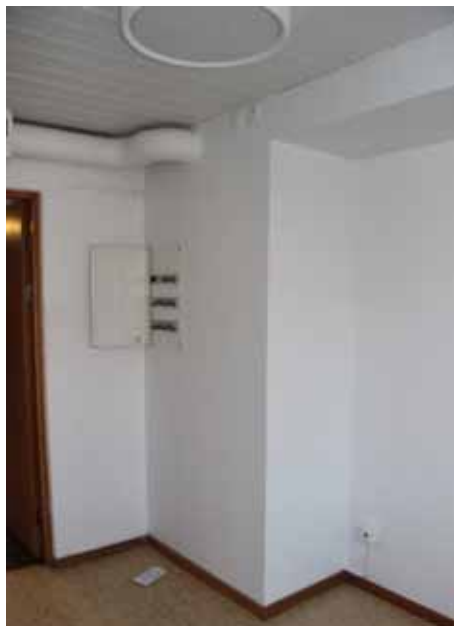
Figur 263. Rum 129. Ventilation inbyggd och elcentral flyttad. Foto: Helén Sjökvist.
