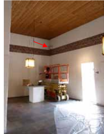
Figur 196. Västra väggen, linjedetektorer vid pilarna. Foto: Helén Sjökvist.
