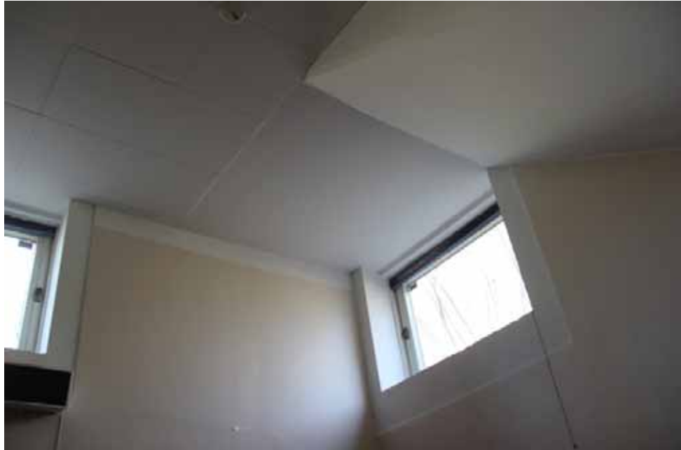
Figur 241. Före installation av ventilationsrör i tak. Foto: Lisa Skanser.
