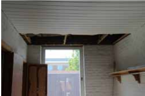
Figur 108. KM13026_0067 Paneltak öppnat för montering av ventilation, kapprum 161.
