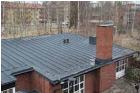
Figur 287. Taket före åtgärder. Foto: Lisa Skanser.
