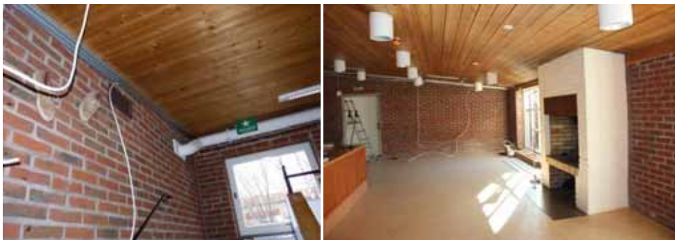
Figur 277. Eldragningar utmed västra och östra väggen, som ej kunde dras dolt i tak, har dragits i en aluminiumlist. Foto: Helén Sjökvist.
