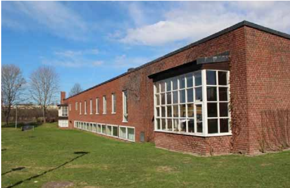
Figur 5. KM13026 Tomaskyrkan_1284. Södra längans södra fasad med burspråket i förgrunden.
