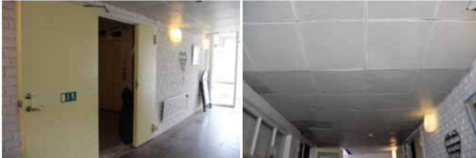
Figur 34. KM13026 Tomaskyrkan_1154 Trapphall 003 före åtgärd.
