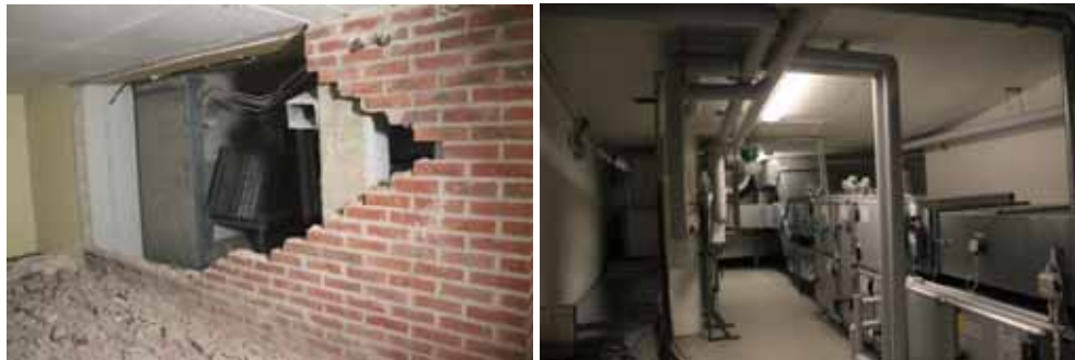
Figur 68. KM13026_0028 Rivning av tegelvägg
