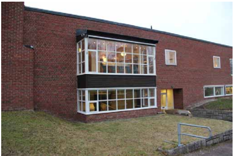
Figur 128. KM13026_0339 Burspråk i södra fasadens källarplan efter åtgärd.
