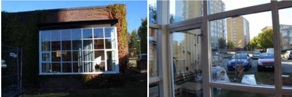
Figur 12. KM13026_0136 Burspråk södra fasaden efter åtgärd.
