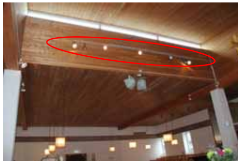
Figur 177. Befintliga spotlights med missprydande eldragningar avlägsnades.
