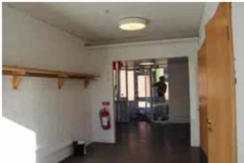
Figur 110. KM13026_0165 Kapprum 161 efter åtgärder. En vit kabelhylla har tillkommit på norra väggen under tak.
