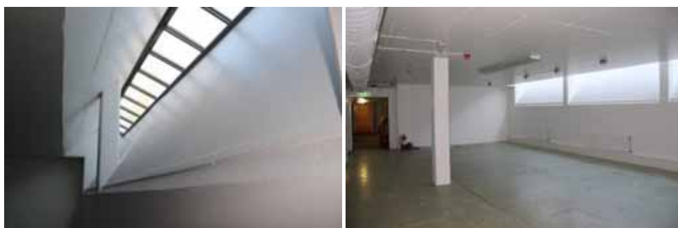
Figur 224. Ljusinsläpp efter åtgärder. Foto: Helén Sjökvist.
