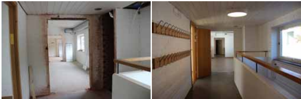
Figur 96. KM13026_0103 Hall 158, breddad dörröppning och öppnad ventilationskanal i nordvästra hörnet.
