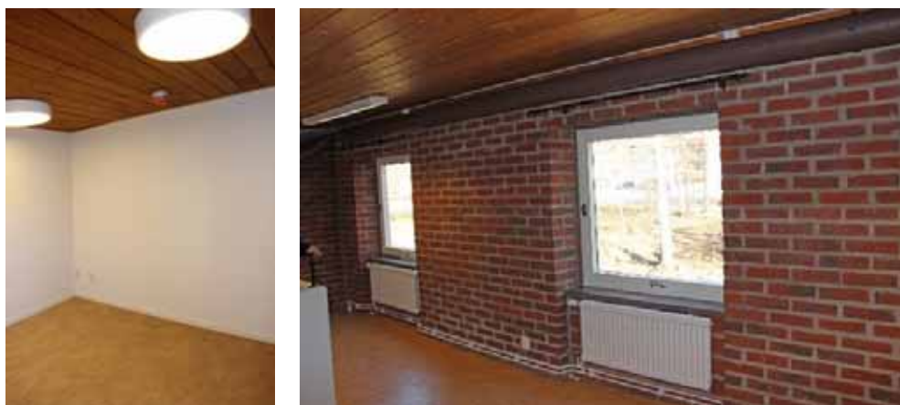
Figur 285. Rummet på entresolplanet är färdigställt med nya väggar. Ventilationsrören är inbyggda bakom väggen till vänster i bild. Foto: Helén Sjökvist.
