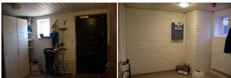
Figur 172. KM13026 Tomaskyrkan_0546. Del av inlastningsutrymme 136 före åtgärd. Figur 173. KM13026_0285. Del av inlastningsutrymme 136 efter åtgärd.
