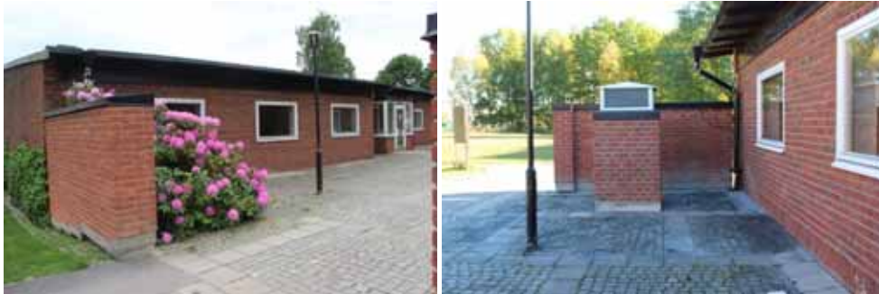
Figur 20. KM13026_0036 Rhododendronbuskaget fick ge plats åt ett av uteluftsdonen/kassunerna.
