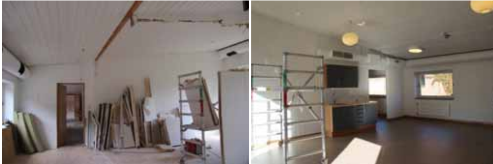
Figur 89. KM13026_0050 Rivna sekundära väggar blivande café 157, foto mot öster.
