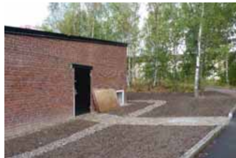
Figur 292. Ny utrymningsväg från ungdomscaféet, rum 135. Foto: Helén Sjökvist.
