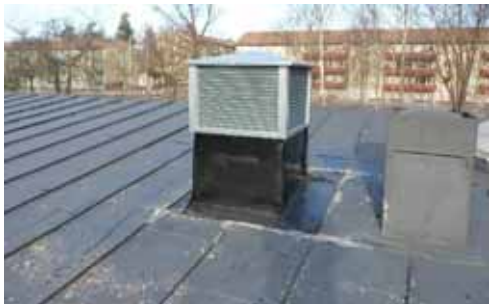
Figur 289. Ny ventilationshuv till vänster. Foto: Helén Sjökvist.
