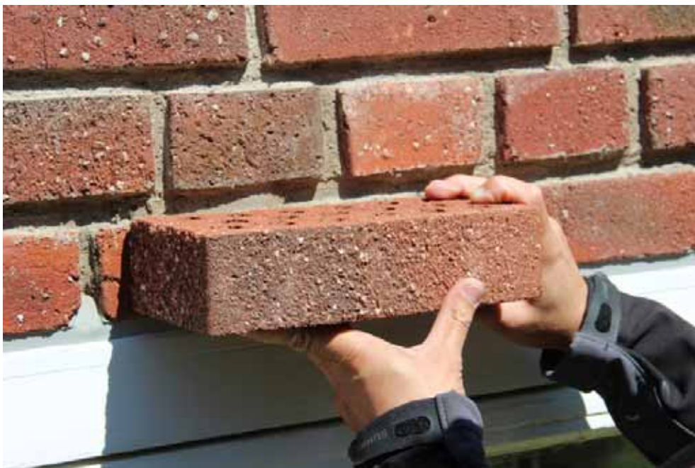
Figur 24. KM13026_0069 Ny tegelsten, en rödflammig sandad hålsten, från Wienberger Haga Tegelbruk jämförs med befintligt tegel från Lina tegelbruk. Nytt tegel användes för komplettering och bl. a. nymurning av uteluftsdon/kassuner.
