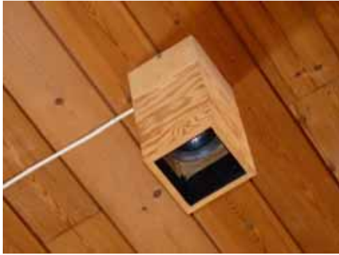
Figur 181. Befintlig armatur i taket över körgradäng. En förlängning av armaturen har gjorts tidigare i den övre delen.
