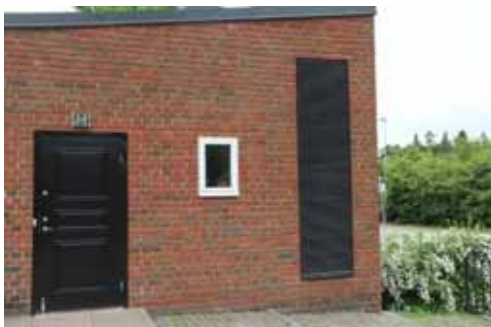
Figur 141. På södra längan finns ett befintligt galler med betydligt tunnare lameller. Foto: Helén Sjökvist.
