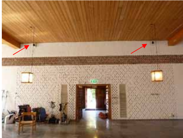
Figur 196. Västra väggen, linjedetektorer vid pilarna. Foto: Helén Sjökvist.
