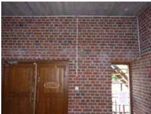
Figur 192. Dragningen av ny brandlarmskabel pågår. Foto: Helén Sjökvist.
