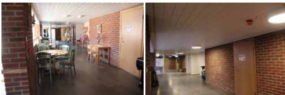
Figur 156. KM13026 Tomaskyrkan_0569 Korridor 140 före åtgärd.
