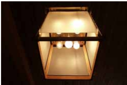
Figur 185. De pendlade armaturerna har endast försetts med en ny ljuskälla. Bild före åtgärd.
