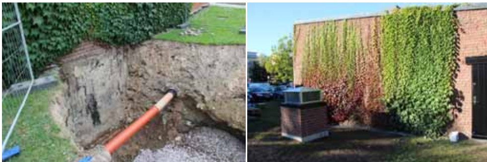
Figur 22. KM13026_0106 Grävd grop för håltagning i grundmuren på södra långans östra gavel.
