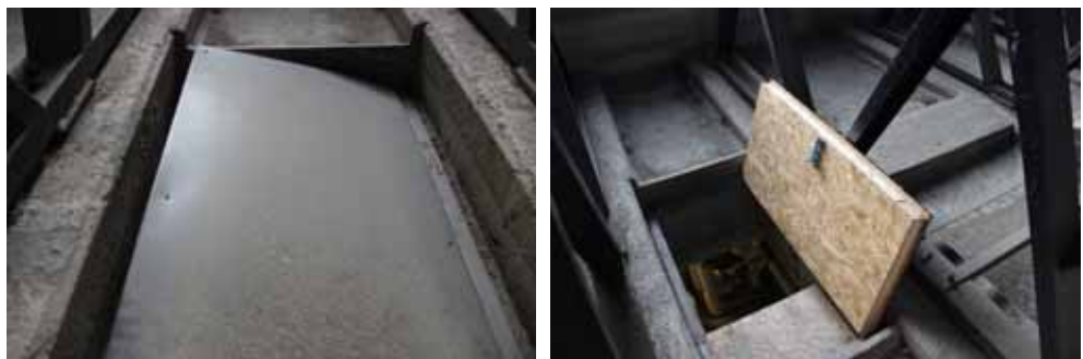
Figur 219 och 220. Taklucka efter åtgärder. Foto: Lisa Skanser.
