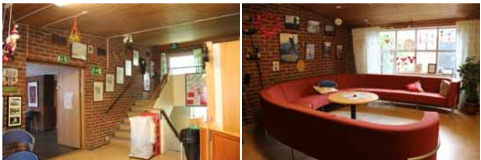
Figur 271. Rummets västra del med trappa upp till entresol, före åtgärder. Befintlig el delvis dragen synligt i taket. Foto: Lisa Skanser.
