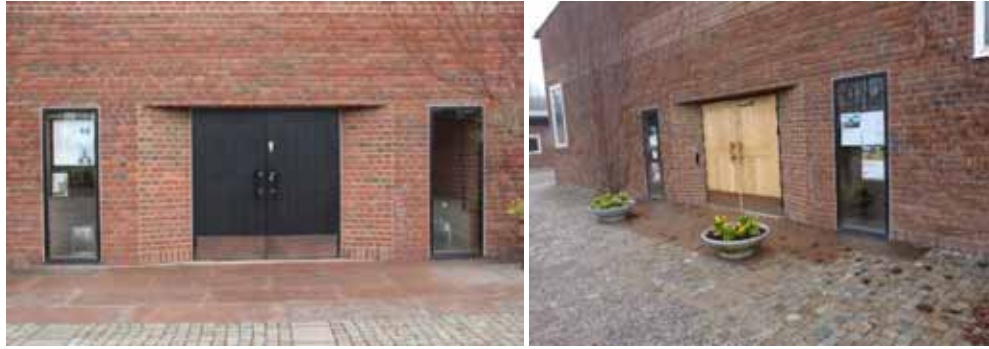
Figur 203. Dörrparti före åtgärder med svartmålade dörrblad och rektangulär stenläggning i röd granit. Foto: Helén Sjökvist.
