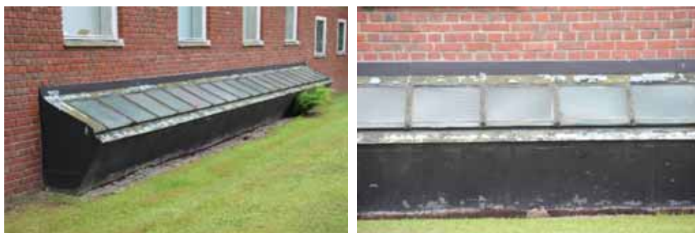
Figur 226 och 227. Ljusinsläpp sett utifrån före åtgärder. Foto: Lisa Skanser.
