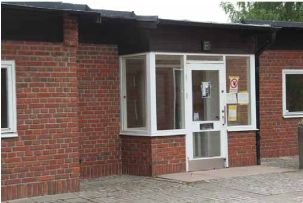
Figur 6. KM13026 _1742 Vindfång 165 i södra längans östra del och norra fasad.
