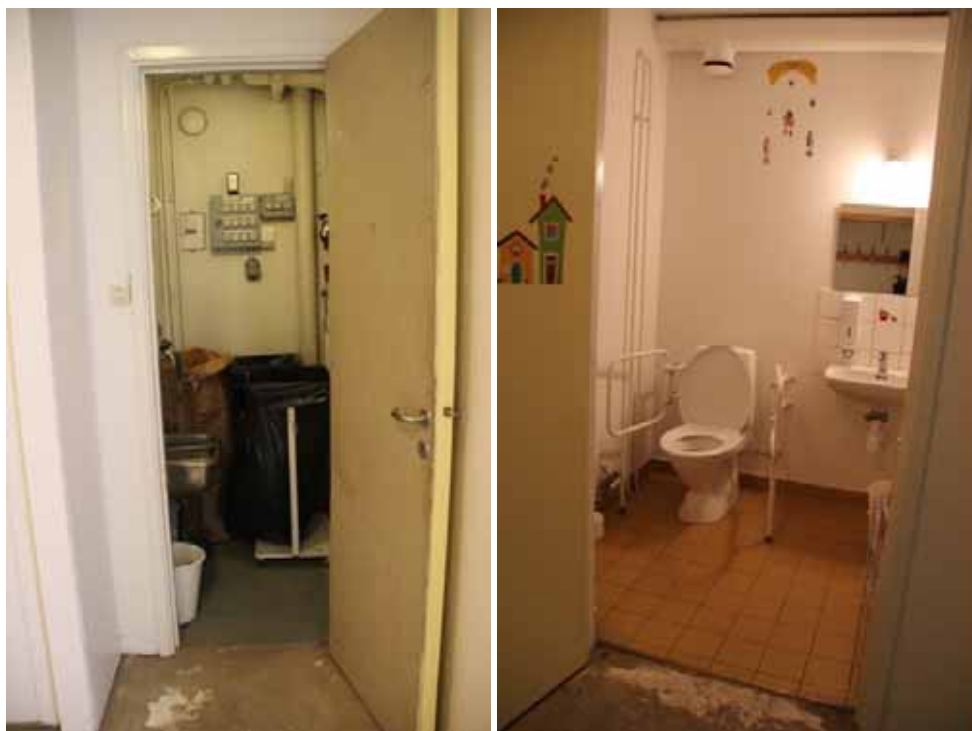
Figur 40. KM13026 Tomaskyrkan_1149 Intill hissen fanns en städskrubba som omvandlades till maskinrum.
