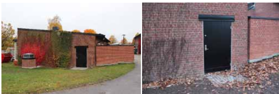
Figur 26. KM13026_0222 Södra längans östra gavel. Ny nödutgång från körsalen/musikrum 166 samt uteluftsdon/kassun.
