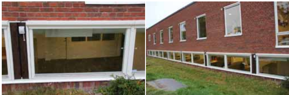
Figur 18. KM13026_0212 Fönster i södra fasadens källarvåning efter att solskyddsgardiner och tillhörande apparatur monterats. I källarvåningen ligger fönstren i liv med fasaden vilket gör att gardinerna sticker ut från fasadlivet. Figur 19. KM13026_0211 Södra fasadens fönster efter att solskyddsgardiner och tillhörande apparatur monterats.
