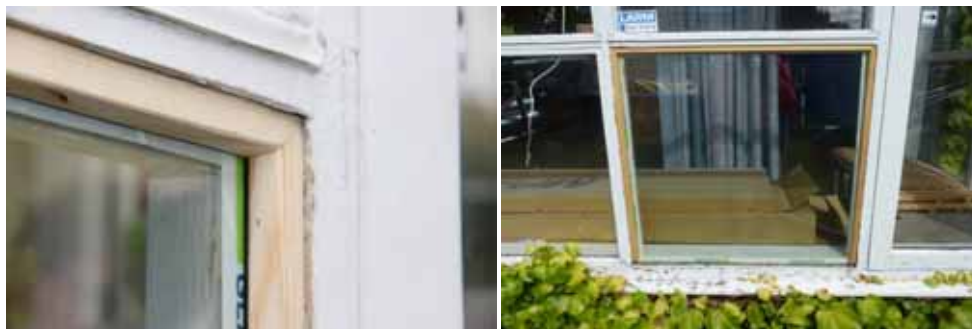
Figur 10. KM13026_0077 Provmontage av isolerglas och trälister.
