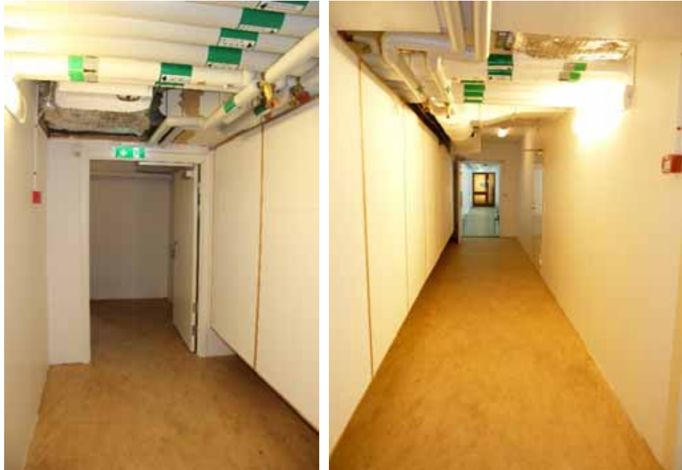
Figur 232. Korridoren sedd mot öster efter åtgärder. Nytt brandklassat dörrparti. Foto: Helén Sjökvist.
