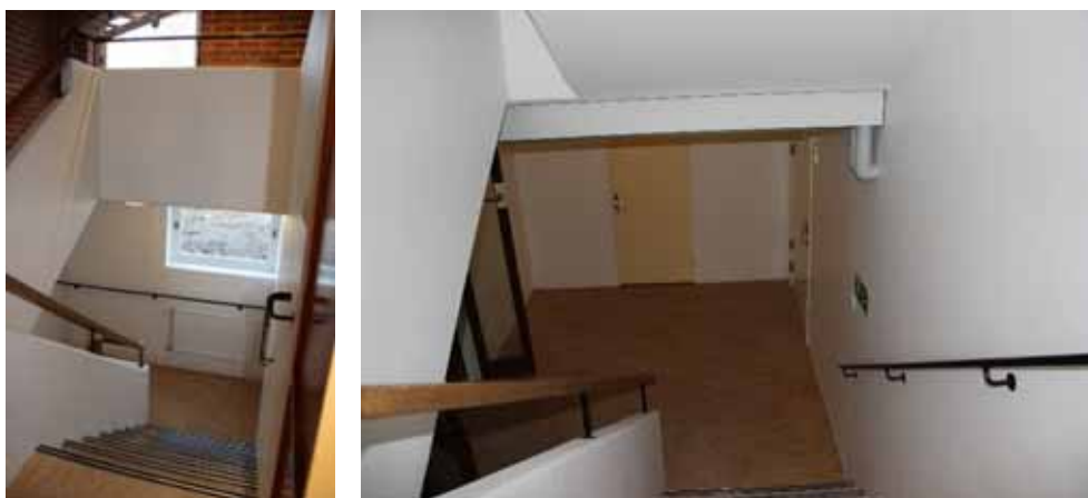
Figur 248. Imålade rör till radiator. Foto: Helén Sjökvist.
