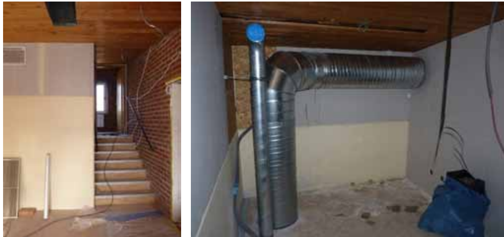
Figur 283. Arbete med att bygga in en del av entresolen påbörjad. Nedre ljusa delen är den befintliga bröstningen, övre delen ny gipsskiva. Foto: Helén Sjökvist.
