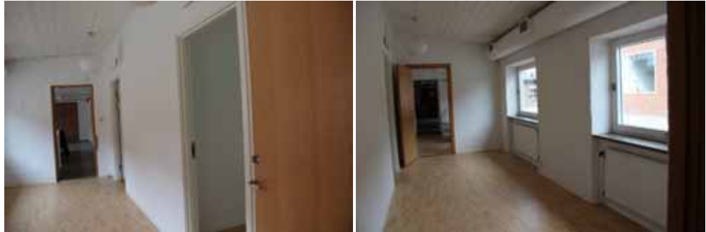
Figur 83 och 84. KM13026 Tomaskyrkan_0792 och -0799. Passage som ska bli del av café 157 innan åtgärd.
