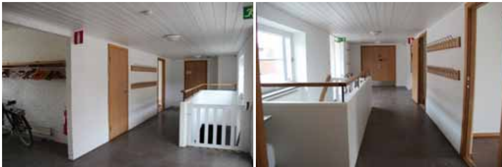
Figur 92. KM13026 Tomaskyrkan_0841 Hall 158 innan åtgärd, foto mot väster.
