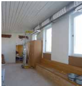
Figur 254. Igenmurade tidigare ventilationsöppningar. Foto: Helén Sjökvist.
