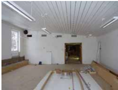
Figur 252. Ny, rund håltagning för ventilationsrör i övre högra hörnet. Foto: Helén Sjökvist.
