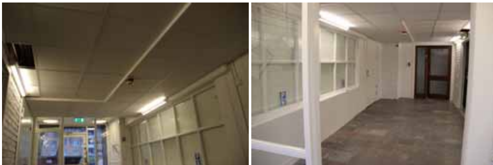
Figur 36. KM13026_0323 Nytt tak i trapphall 003.
