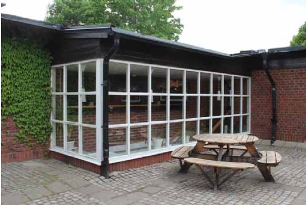
Figur 129. KM13026 Tomaskyrkan_1750 Burspråk mot gården i norra fasaden före åtgärd.
