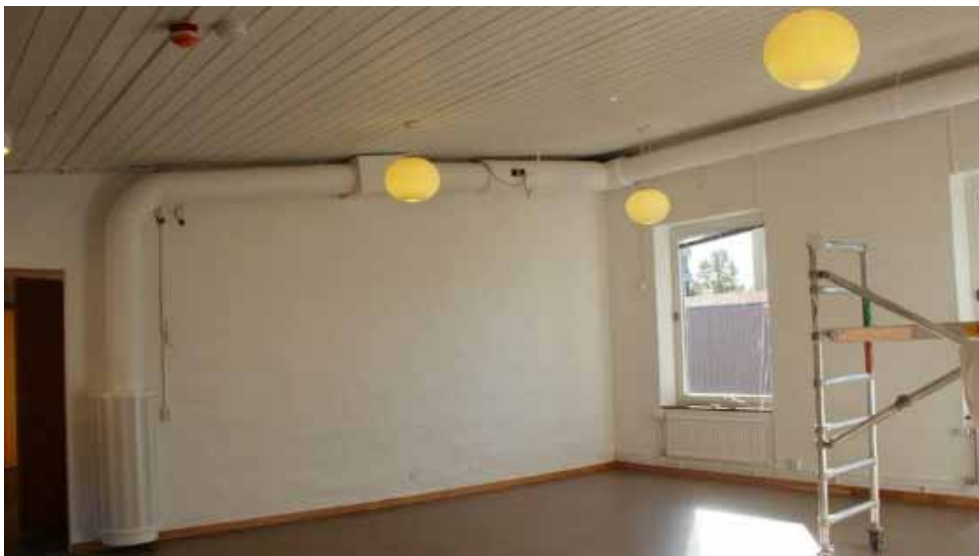
Figur 91. KM13026_0149 Café 157 efter åtgärd, foto mot sydöst.
