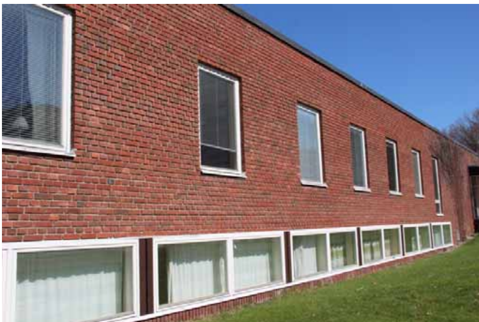
Figur 15. KM13026_1294 Södra längans södra fasad innan åtgärd.
