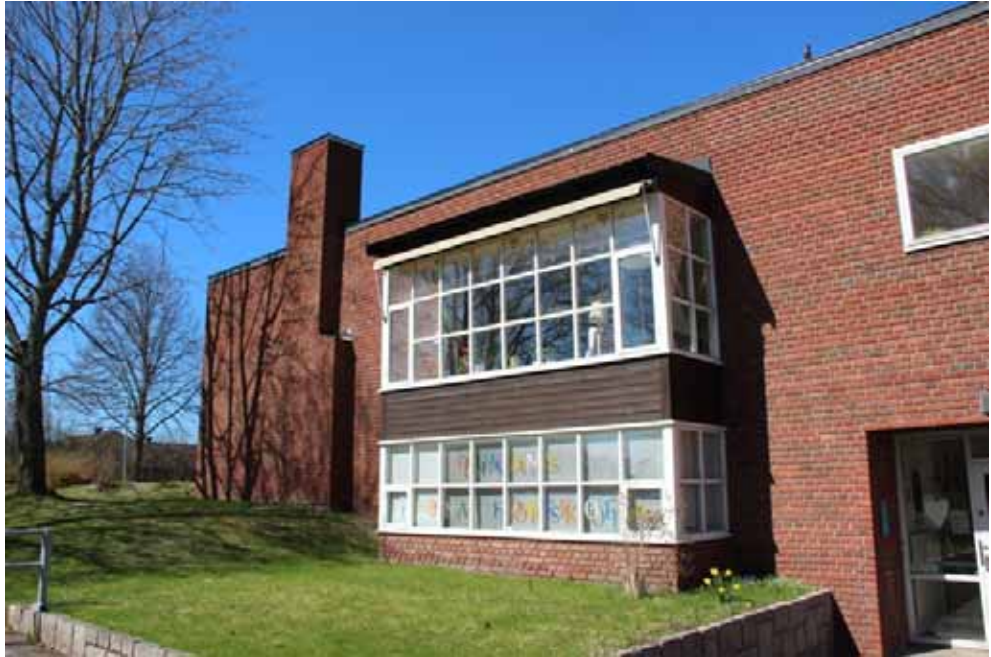
Figur 127. KM13026 Tomaskyrkan_1295 Burspråk i södra fasadens källarplan före åtgärd.
