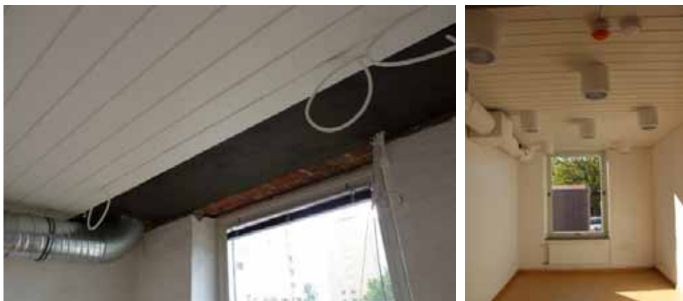
Figur 100. KM13026_0120 Panel nedtagen i rum 159 för montering av dold ventilation.
