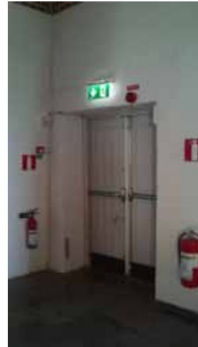
Figur 195. Nödutgång i nordöst kompletterad med ytterligare brandsläckare, ny ledskylt, blyxtljus och panikregel. Foto: Helén Sjökvist.
