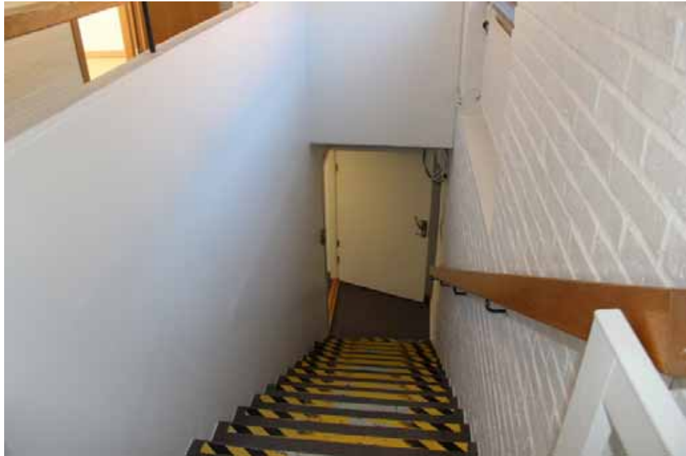
Figur 61. KM13026_0167 Trapphall 015 efter ombyggnad. Till vänster i bild har handledaren byggts in i den nya brandavskiljande väggen.
