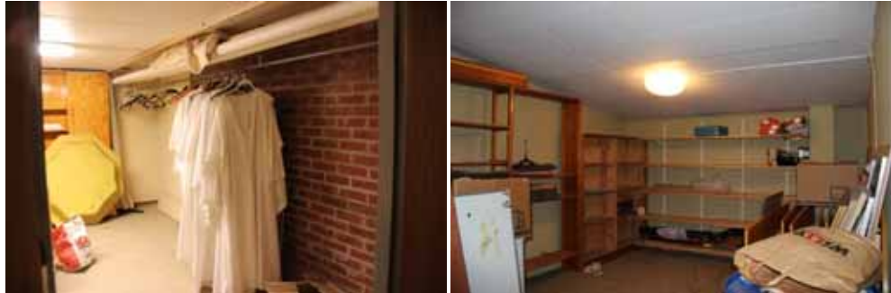
Figur 66. KM13026 Tomaskyrkan_1023 Tegelväggen i bild revs under entreprenaden.
