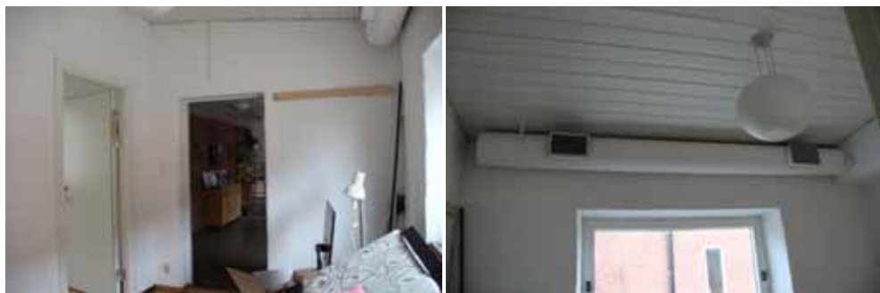
Figur 75 och 76. KM13026 Tomaskyrkan_0768 och -0765. Passage 155 innan åtgärd.
