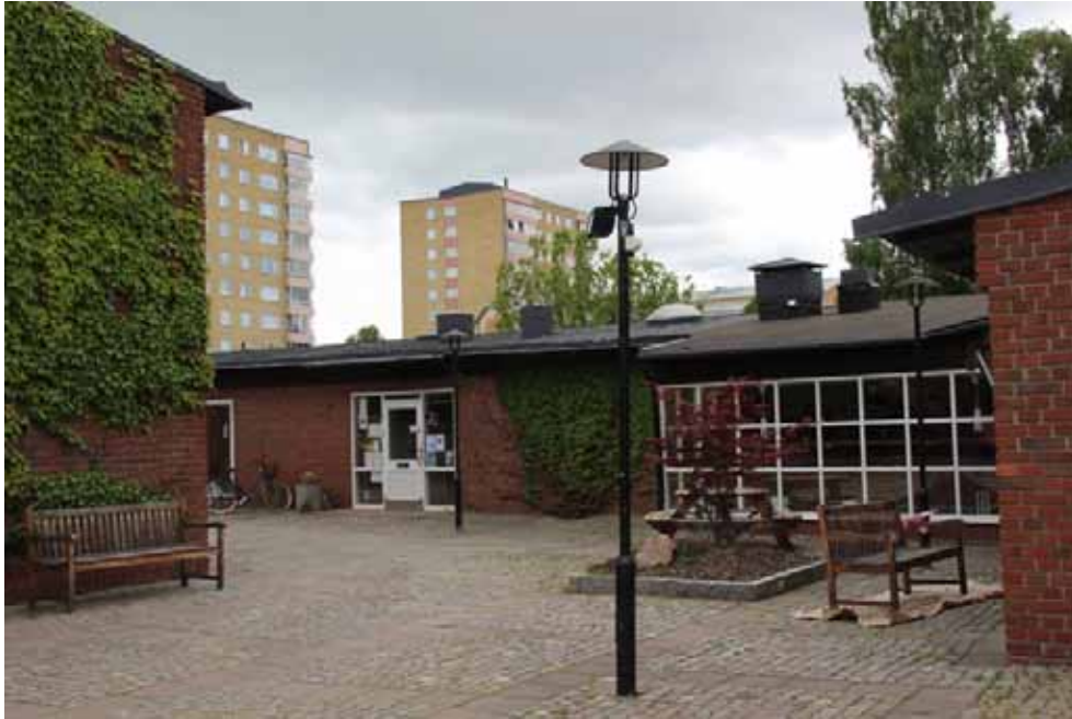
Figur 133. KM13026 Tomaskyrkan_1754 Entré före ombyggnad.
