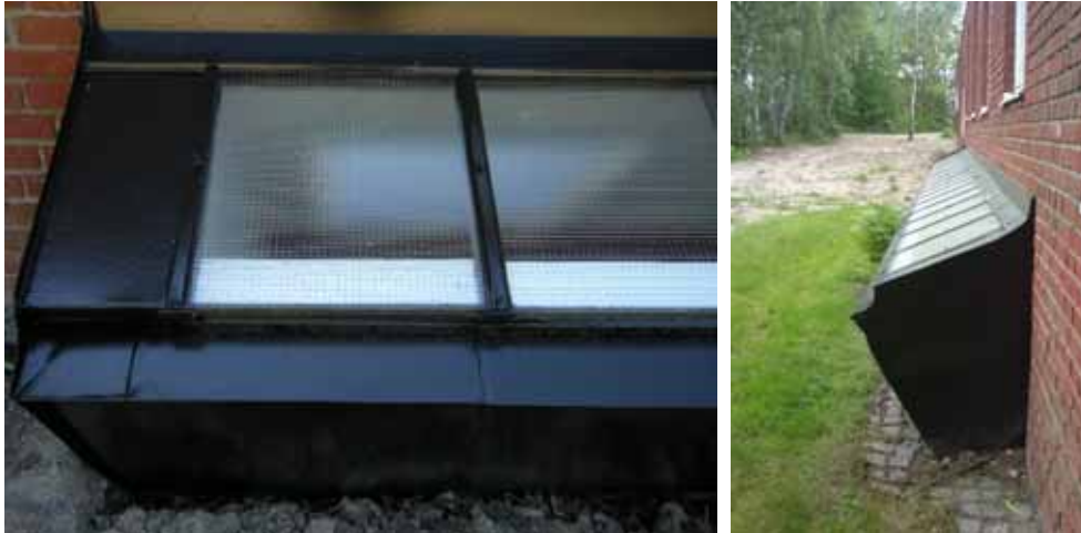
Figur 228 och 229. Lanterninen med nytt trädglas, sedd utifrån efter åtgärder. Foto: Helén Sjökvist.
