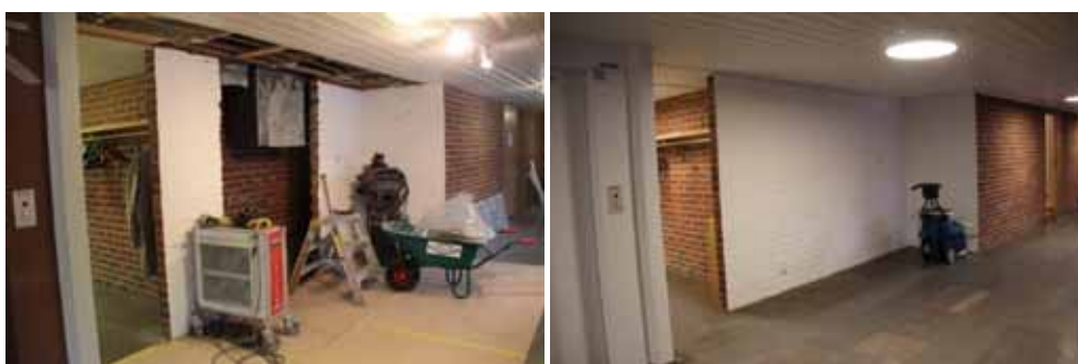
Figur 158. KM13026_0204 Riven vägg till ventilation i hall 143.
