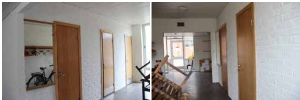
Figur 106 och 107. KM13026 Tomaskyrkan_0862 och -0869. Kapprum 161 före åtgärder.
