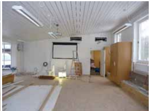
Figur 252. Ny, rund håltagning för ventilationsrör i övre högra hörnet. Foto: Helén Sjökvist.
