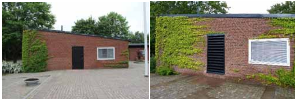
Figur 139. KM13026_1711 Södra gaveln innan åtgärd.
