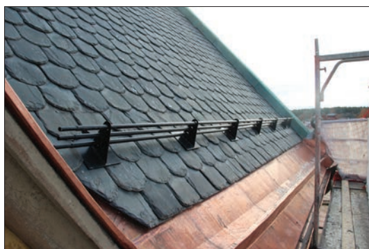
Figur 37. Foto 171. Nya snörasskydd särskilt anpassade för skiffertak.
