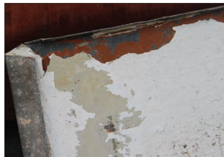
Figur 34. Foto 177. Zinkplåt med färgskikt.
