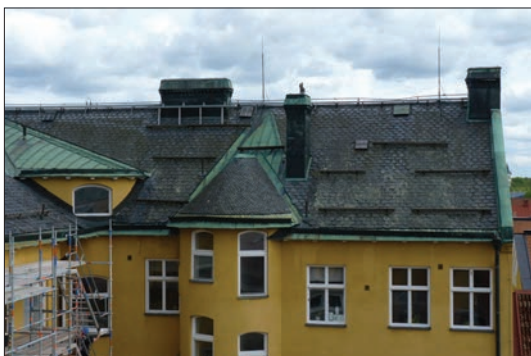
Figur 18, foto 027 och figur 19, foto 306. Takfall mot innergården (byggnadsdel utmed Fredsgatan) före och under omläggning. Där lades det spanska skiffret.
