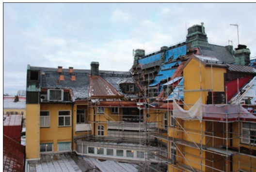
Figur 17, foto 220. Takfall mot innergården. Till vänster syns färdigställd takyta (byggnadsdel utmed Stora Torget). Till höger pågår omläggning.
