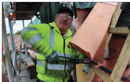
Figur 25. Foto 141. Plåtsgare Seppo Hakola från SG Bleck och Plåt bockar koppjarplåt.
