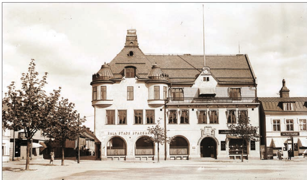
Figur 7. Sala Sparbank år 1935. Arkivfoto nr 45 från Sala kommun. Fotograf Sven Norling. Snörasskydd av plankor är monterade på taket.
