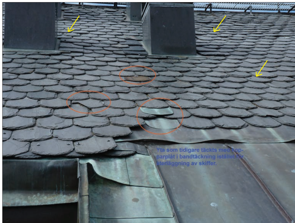
Figur 11. Foto 033. Ringarna markerar sprucken skiffer samt ilagningar med plåt. Pilarna markerar områden där skruv dragits genom skiffer ovanifrån.
