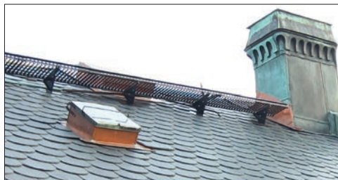
Figur 40. Foto 350. Takfönster efter renovering, med upphöjd sarg.
