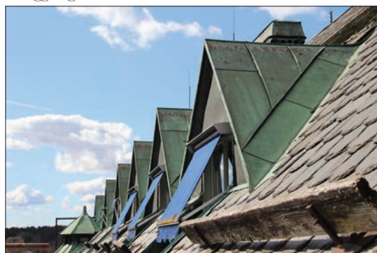
Figur 28. Foto 250. Takkupor på takfall mot Fredsgatan före åtgärd.
