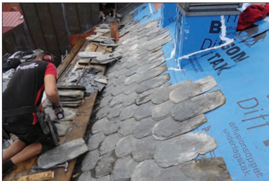
Figur 16, foto 138. Skifferspikning.
