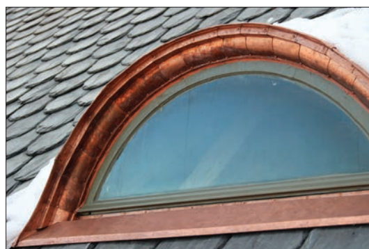
Figur 38. Foto 382. Vindsfönster efter renovering.
