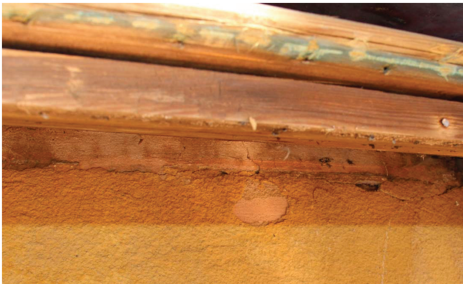
Ursprunglig brädriven och kvastad kalkbruksyta, avfärgad i en rosagul kulör, framträder under sentida sprutputs i gul kulör.
