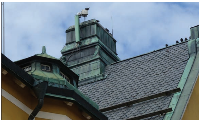
Figur 6. Foto nr 016 taget från Bergsmansgatan.
