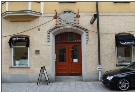
Figur 49. Foto 02. Ursprunglig dörr, trapphus mot Fredsgatan, målad i S 4550–Y50R.
