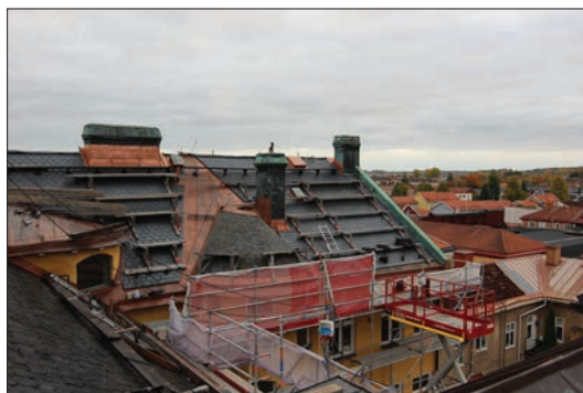
Figur 18, foto 027 och figur 19, foto 306. Takfall mot innergården (byggnadsdel utmed Fredsgatan) före och under omläggning. Där lades det spanska skiffret.
