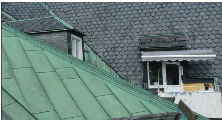
Figur 40. Foto 350. Takfönster efter renovering, med upphöjd sarg.
