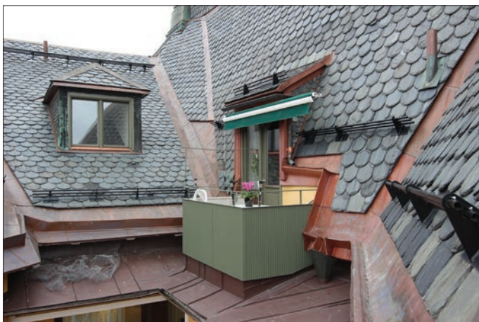
Figur 42. Foto 313. Balkong och takkupa efter renovering.
