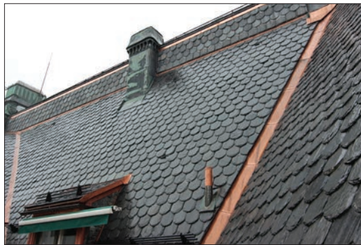
Figur 14, foto 031 och figur 15, foto 289. Takfall mot innergården före och efter omläggning.
