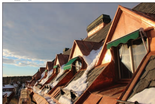
Figur 29. Foto 386. Takkuporna efter åtgärd.
