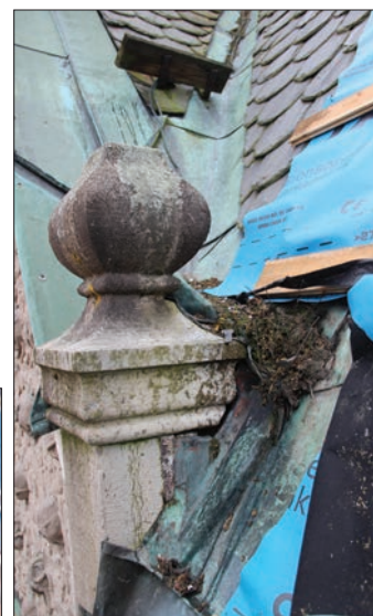
Figur 45. Foto 149. Stendekoration mot Bergsmansgatan (den västra) med rännaldalen ovanför. Skräp samlades och blev liggande i den tidigare konstruktionen.
