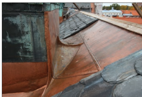
Figur 31. Foto 317. Skorstensplåt på takfall mot innergården och byggnadsdel utmed Bergsmansgatan.
