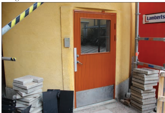
Figur 51. Foto 03. Dörr mot innergården målad i S 4550–Y50R.
