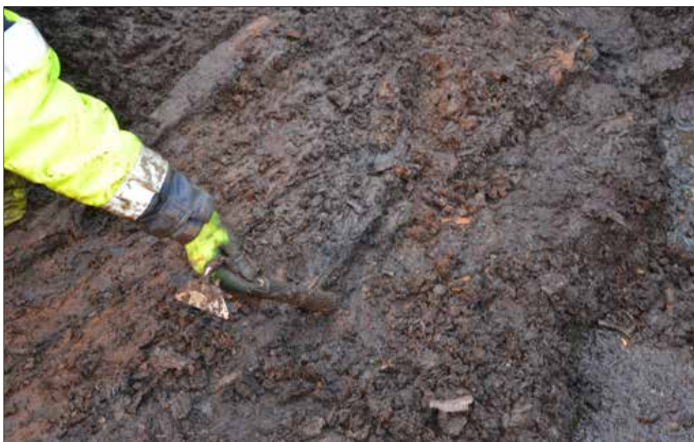
Figur 135. A6000, spångens östra del framrensad. Foto från öster av Mattias Johansson.
