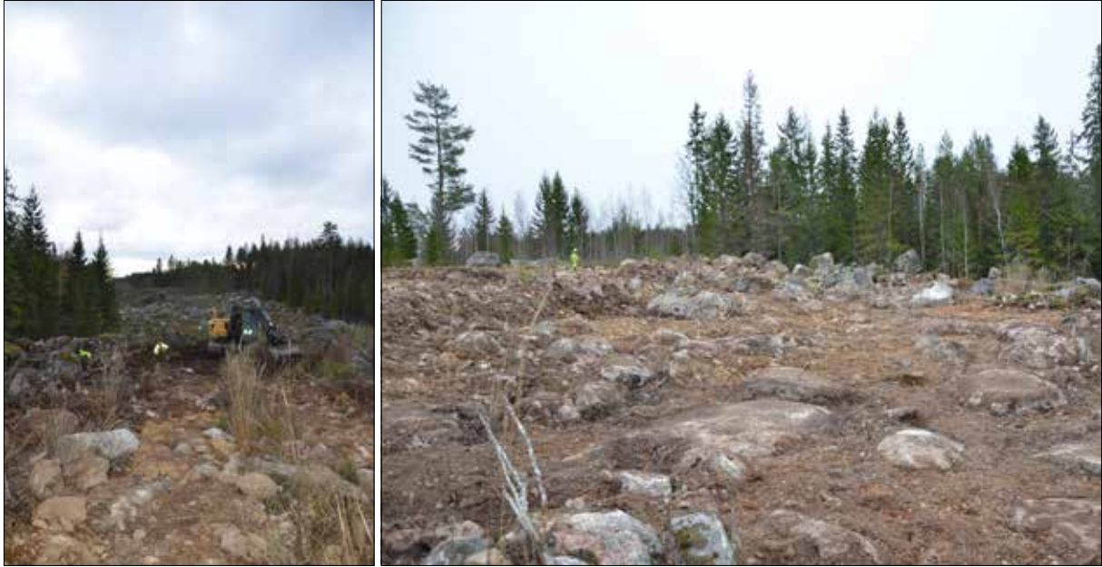
Figur 141–142. Försök till avbaning av Nora 428 under oktober 2014 (t.v.). Nora 428 efter ”avbaning” (t.h.). Stenblocken flyttades för att komma åt marken intill dem (t.h.). Foto från norr respektive sydväst av Tom Carlsson.
