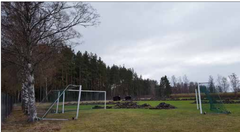
Figur 7. Den östra sidan av fotbollsplanen efter sökschaktning. Foto från norr.
