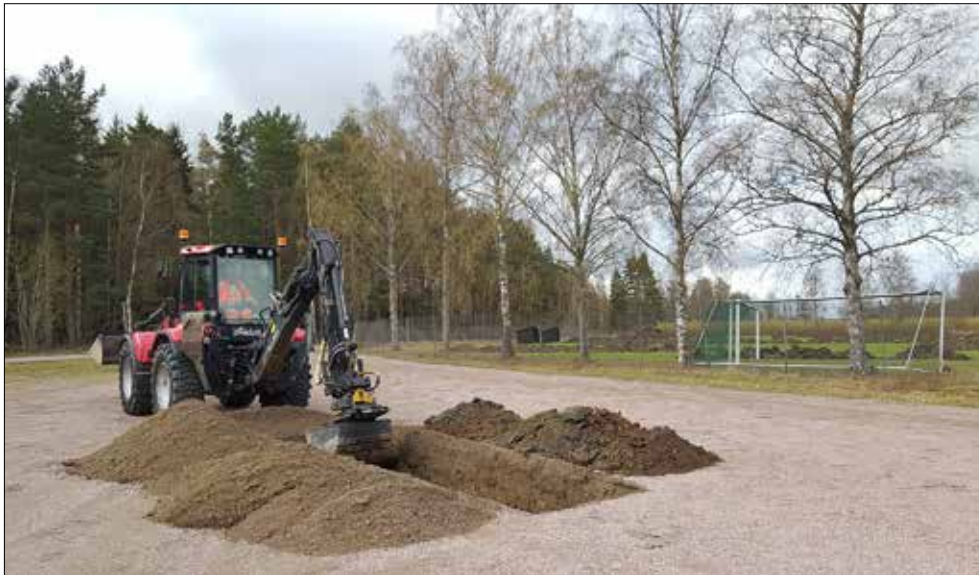
Figur 6. Schakt nummer 13 grävs i parkeringsplatsen till fotbollsplanen. Foto från nordväst.
