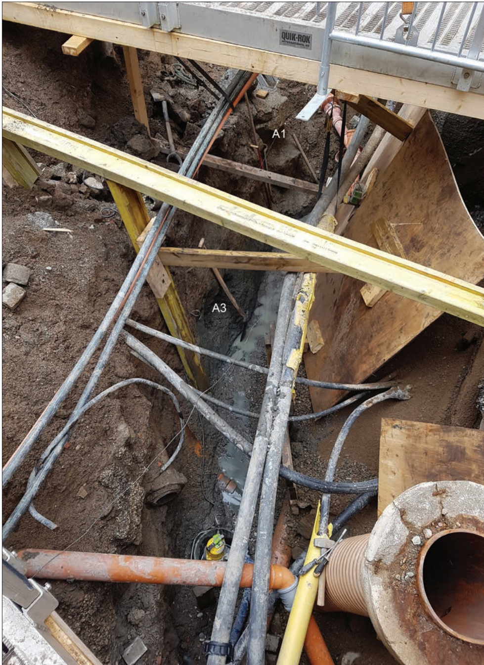
Figur 11. Schaktet sett från sydväst. Läget för A3, tidigmedeltida skelettgran, markerat centralt i bilden. A1, tidigmodern källarmur syns högst upp i bild under den tillfälliga bron. MDF-skivor sattes upp för att motverka ras. Foto från sydväst av Oskar Spjuth.
