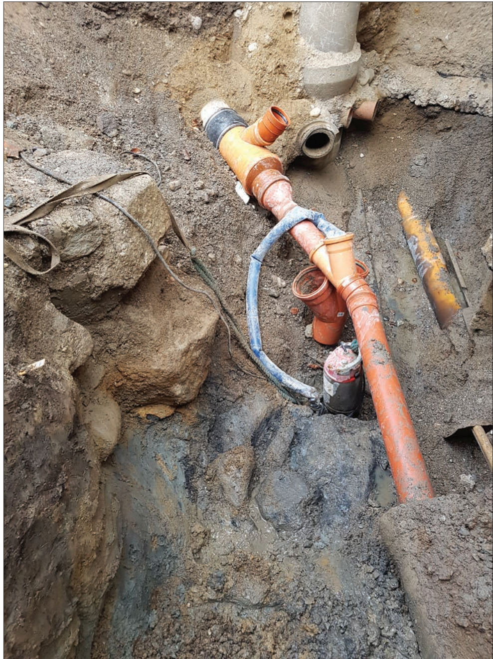
Figur 16. Rester av källarmuren, A1, är synligt i schaktbotten och i schaktväggen till vänster i bild (sektion 1b). Foto från sydväst av Oskar Spjuth.
