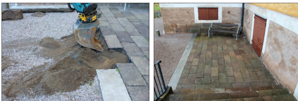
Figur 9 (övre, vänster). Stenväggningen framför västra fasadens norra del hyfs inför kabeldragning.
