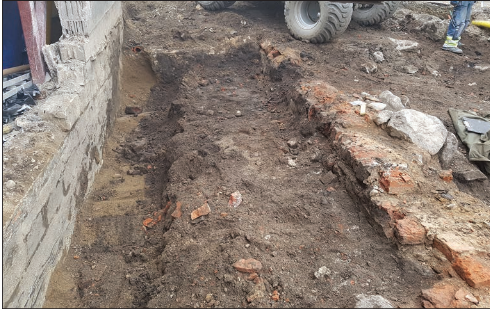
Figur 12. Hus B, med sin murade källare och början på tegelvalv. Foto från nordöst av Oskar Spjuth.
