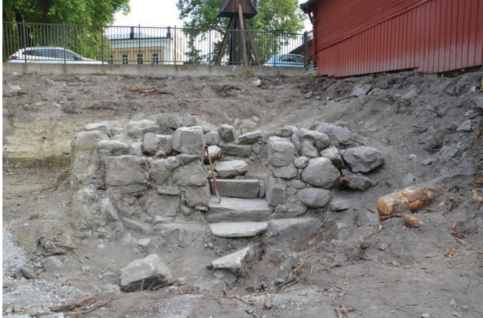
Figur 14. Hus 1. Huset dateras till senmedeltid. Det har varit ett trapphus och utgjort en förbindelse mellan gatan och hus 2, källaren, inne på tomten intill Svartån. Foto från sydväst.
