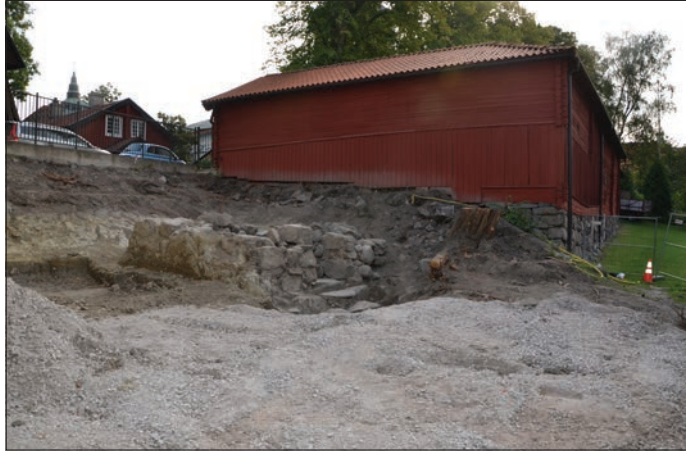
Figur 19. Översikt över trapphuset hus 1. Den röda byggnaden är Biskopens stallar som är uppförd på en stenmur. En stubbe, tillhörande en asp som sågades ner, ses till höger om stenhuset. Foto från nordväst.
