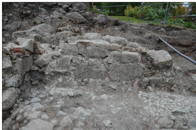
Figur 27. Den sydöstra väggen i källaren, hus 1. I murens övre del ses tegelstenar som utgör anfangsstenar till tunnvalvet som funnits i källaren. Observera att muren har sjunkit och är lägre i bildens högra del som ligger närmare Svartån (jfr figur 25 och 28). Foto från nordväst.
