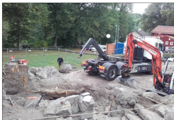
Aspen hade kraftiga rötter och två grävmaskiner och en lastbil användes för att ta bort den. Till höger ses grävmaskinen som användes då jorden schaktades bort.
