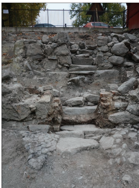
Figur 30. Den nordöstra väggen i hus 2. I väggen finns en dörröppning och därifrån går en trappa upp till hus 1. Dörröppningen har haft en tegelinfattning (jfr figur 29). Foto från sydväst.
