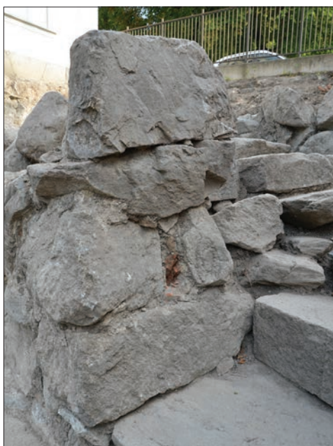
Figur 16. Detalj av öppningen i trappan i hus 1. I muren ses inmurat tegel, sannolikt har öppningen haft en tegelinfattning. Foto från söder.
