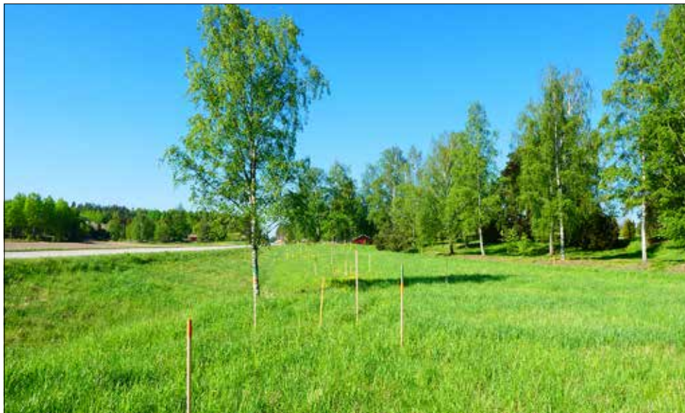
Figur 4. Den sydvästra delen av förundersökningsområdet med stakkeppar för telefoni, opto, el, vatten och avlopp. Den höga stakkeppen centralt i bild markerar gräns för arbetsområde. Foto från nordost.
